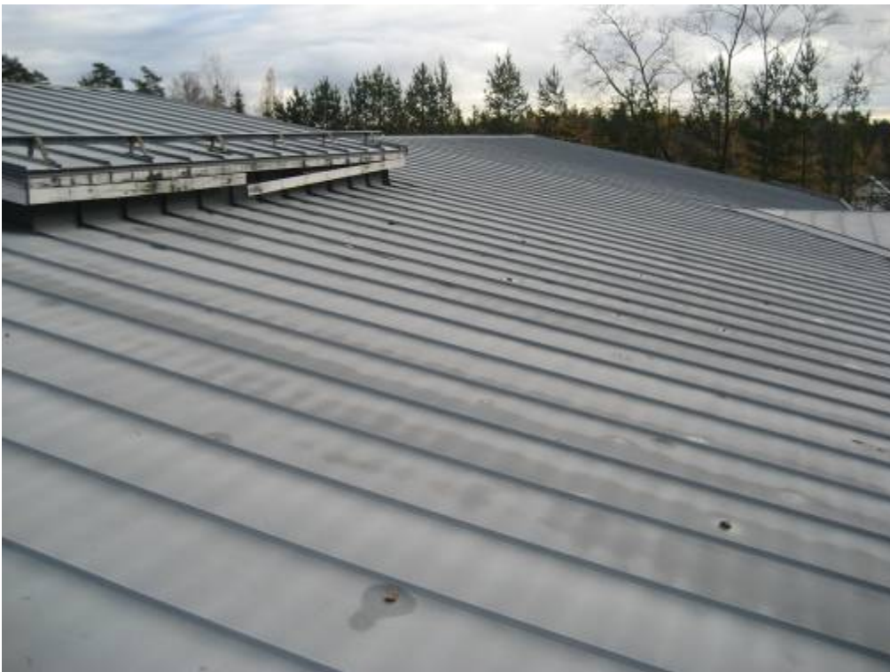
RAK-KUVA 6: Yläpohjarakenteet arvioitiin olevan tyydyttävässä kunnossa kunhan niiden säännöllinen tarkastaminen toteutetaan kiinteistön huolto-ohjelmassa / suoritetaan tarvittavat kunnostustoimenpiteet.
