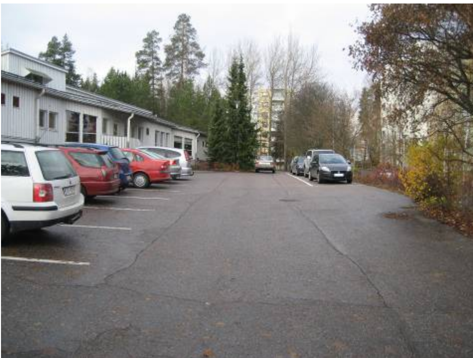
RAK-KUVA 2: Koillissivustalla sijaitseva paikoitusalue on asfaltoitu.
