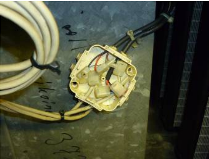
S-KUVA 4. IV-konehuoneen asennus
