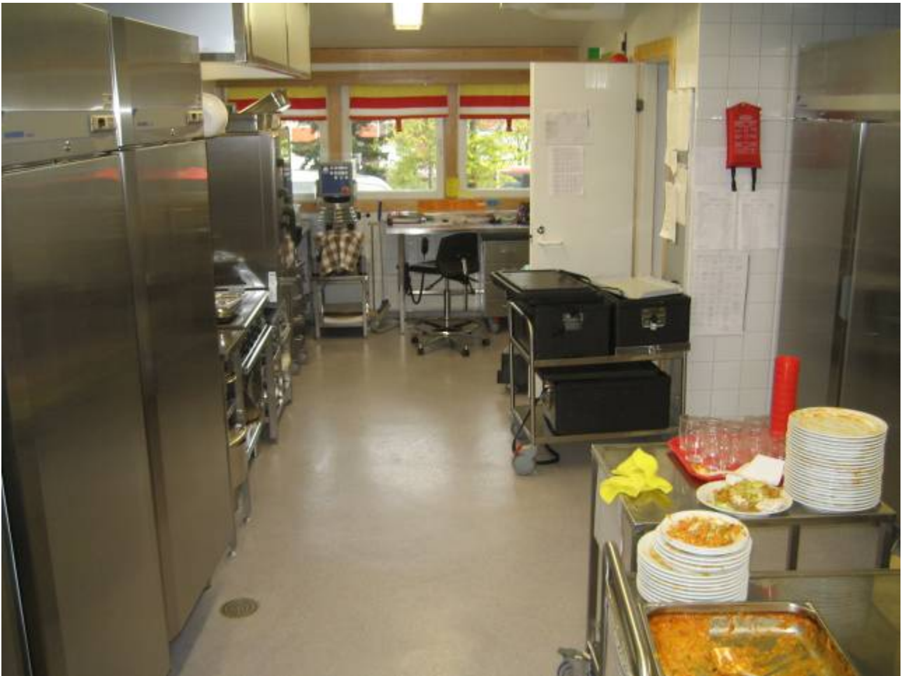
RAK-KUVA 13: Jakelukeittiön rakenteet ovat kokonaisuudessaan hyvässä kunnossa ja niiden arvioitiin vastaan nykyisen käyttötarkoituksen asettamia vaatimuksia.
