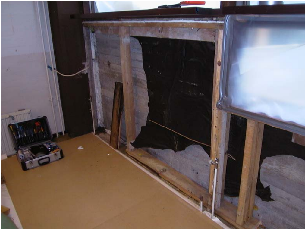
Kuva 1 Purettu seinä, betonisokkelin sisäpinnassa bitumipaperi toimittamassa tulusulun virkaa, vaikka ko seinärakenteessa ei ole tuuletus mahdollinen.
