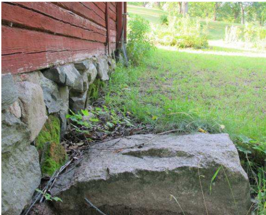
Hirret ovat osin kiviperusmuurin päällä
