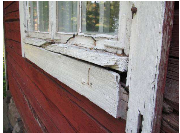
Rakennuksen ikkunat ovat vanhoja puuikkunoita. Ikkunarakenteiden vaurioita
