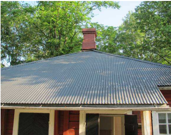
Yleiskuvaa vesikatolta, katemateriaali on muoviprofiilikate
