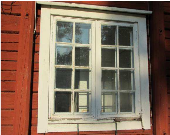
Rakennuksen ikkunat ovat vanhoja puuikkunoita. Ikkunarakenteiden vaurioita
