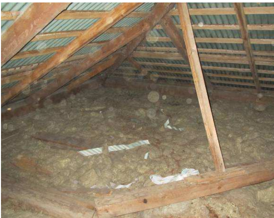
Yläpohjatila tuulettuu alaräystäiltä, yläpohjaeristeenä mineraalivillaa/puraa noin 150mm
