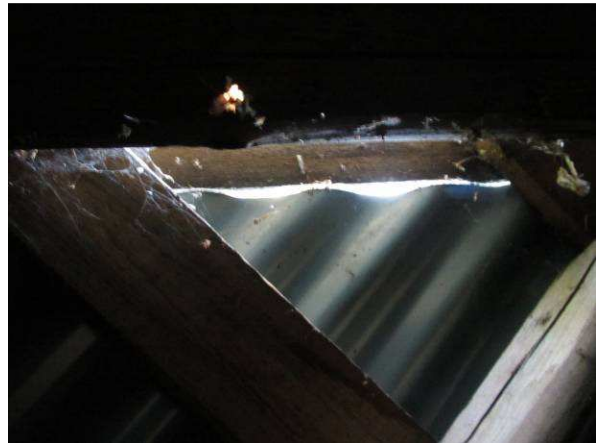
Taivas näkyy yläpohjatilan puolelta
