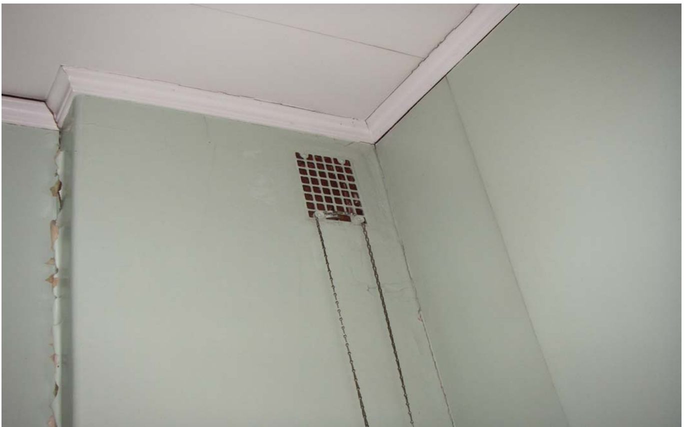
KUVA 4. WC-tiloissa on ritiläsäleikkö.
