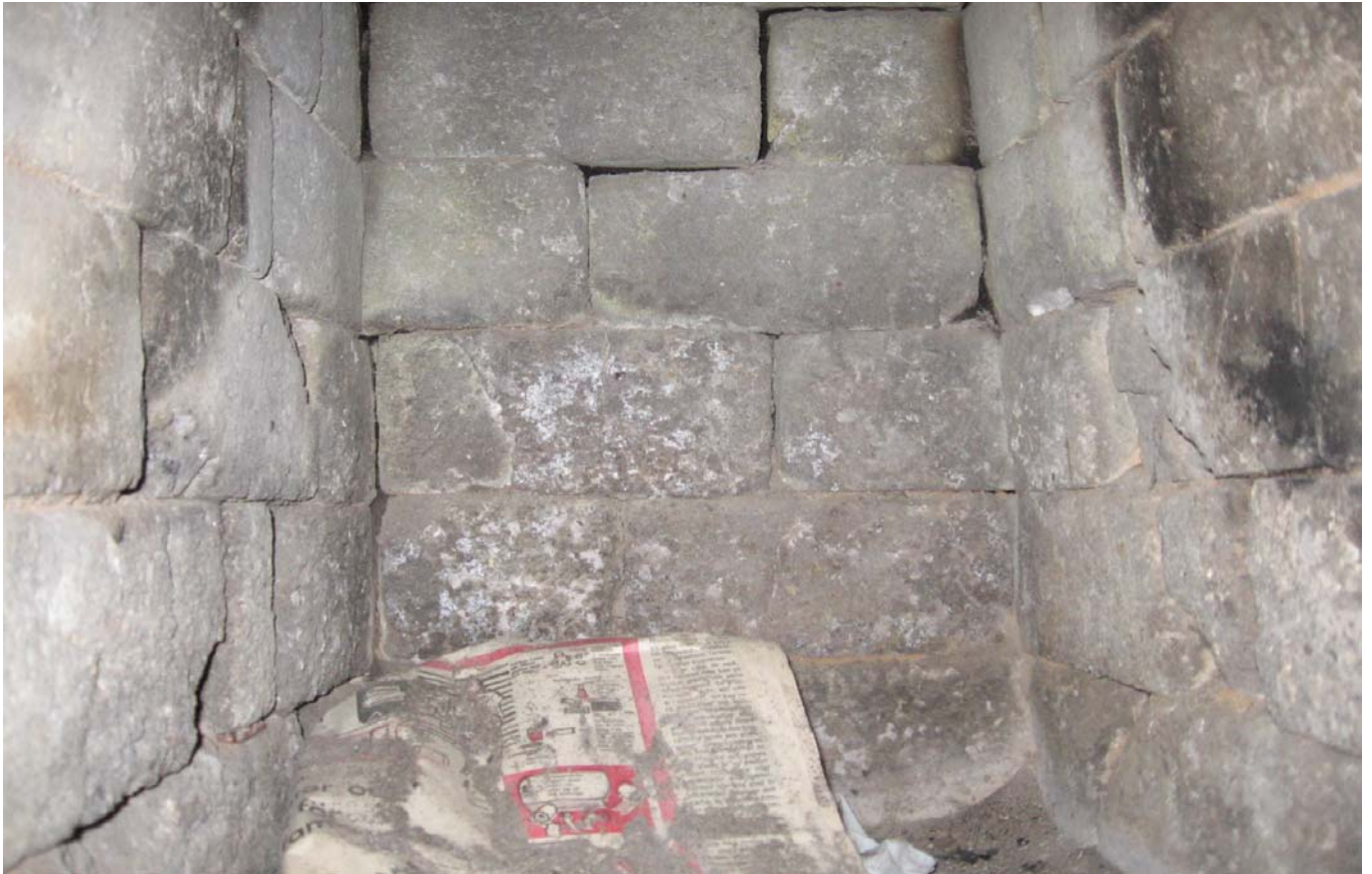
KUVA 27. Yleiskuva uunin n:o 11 tulipesästä.
