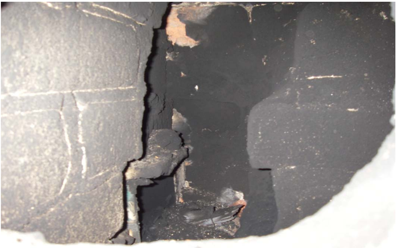
KUVA 34. Öljykattilan savupiipun pohjalla on hieman roskaa.
