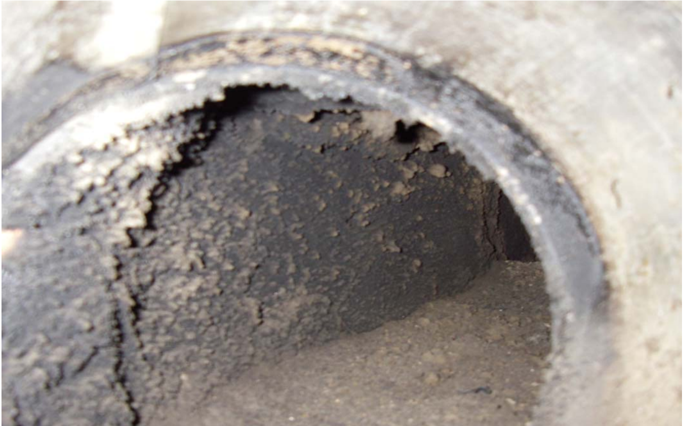
KUVA 1. Poistoilmahormit ovat tiilestä rakennettuja hormeja.
