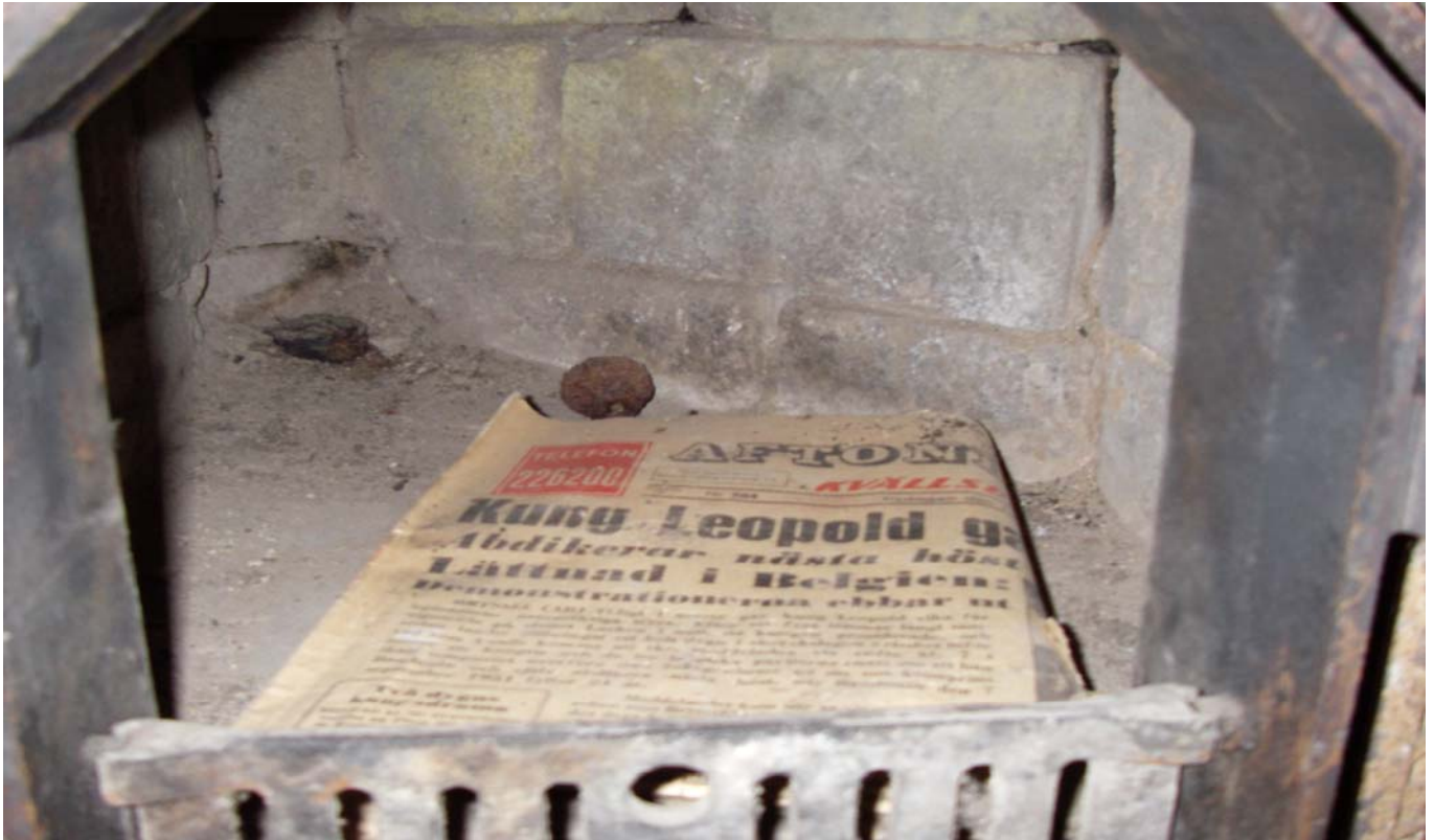
KUVA 13. Yleiskuva uunin n:o 4 tulipesästä.
