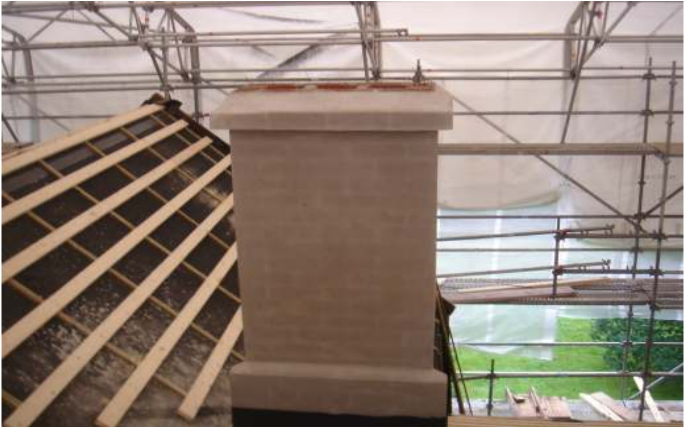
KUVA 3. Piippuryhmä n:o 5 on uusittu ullakkotiloista ylöspäin.
