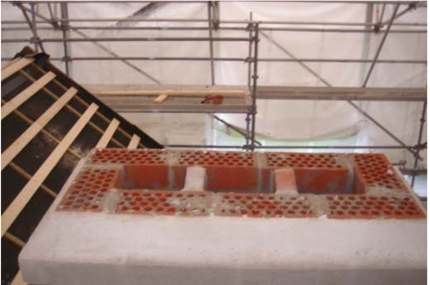
KUVA 11. Yleiskuva piippuryhmästä n:o 5.
