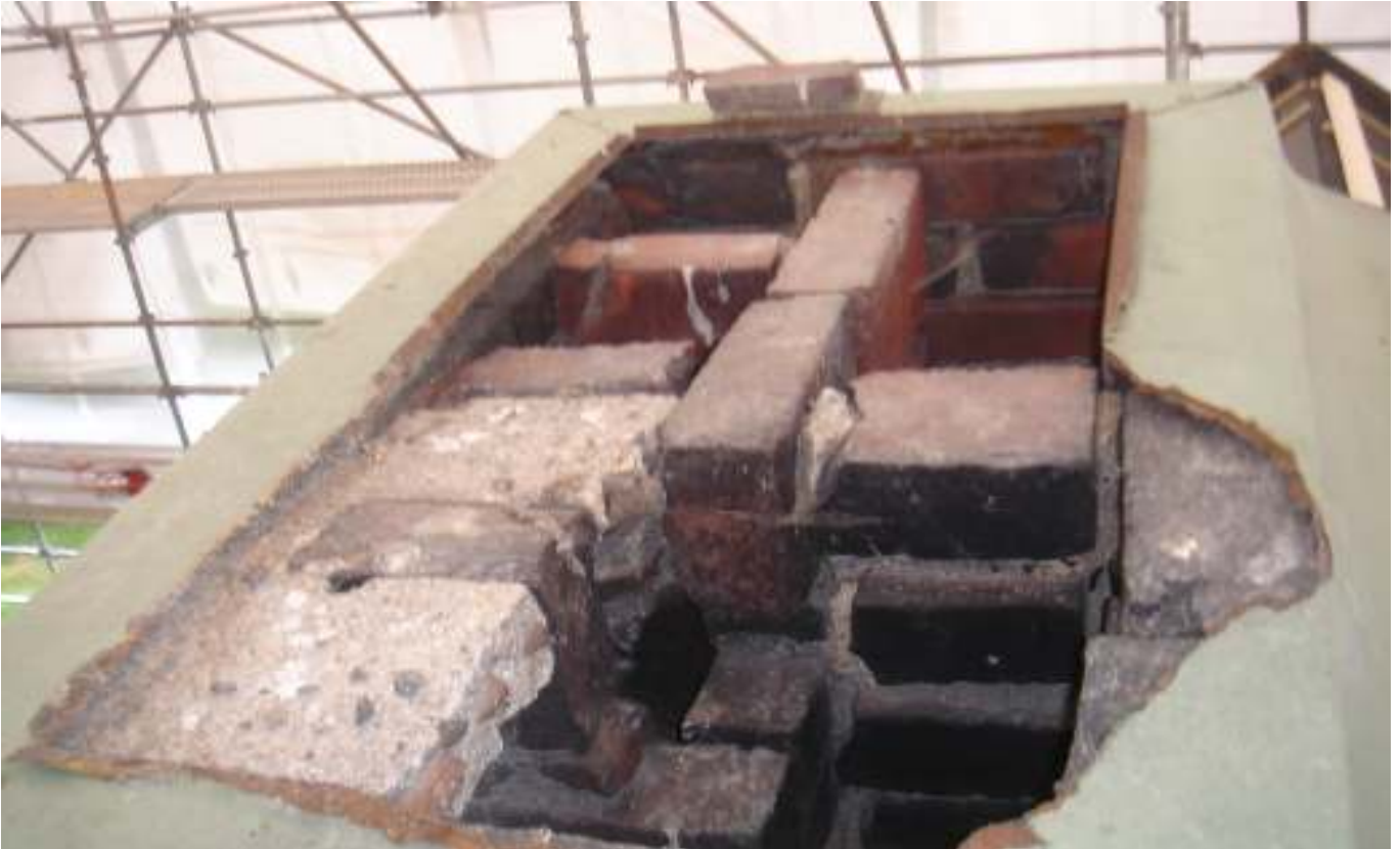
KUVA 1. Piiput ovat tiilestä rakennettuja hormeja.
