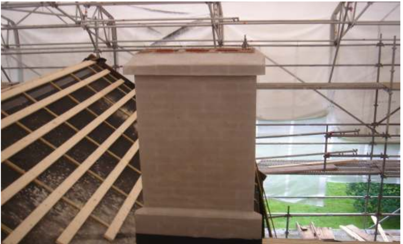
KUVA 10. Yleiskuva piippuryhmästä n:o 5.
