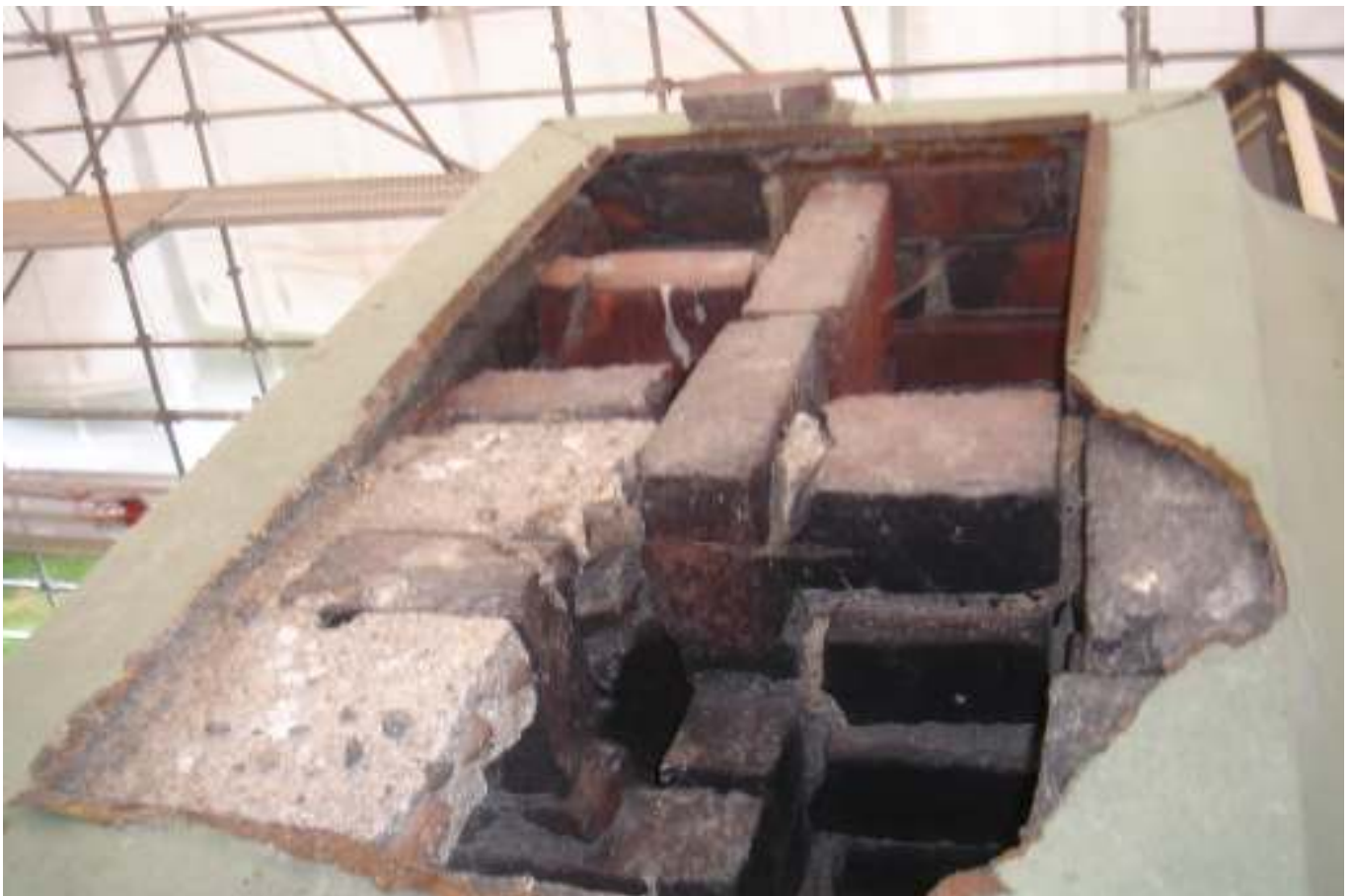
KUVA 6. Yleiskuva piippuryhmästä n:o 3.
