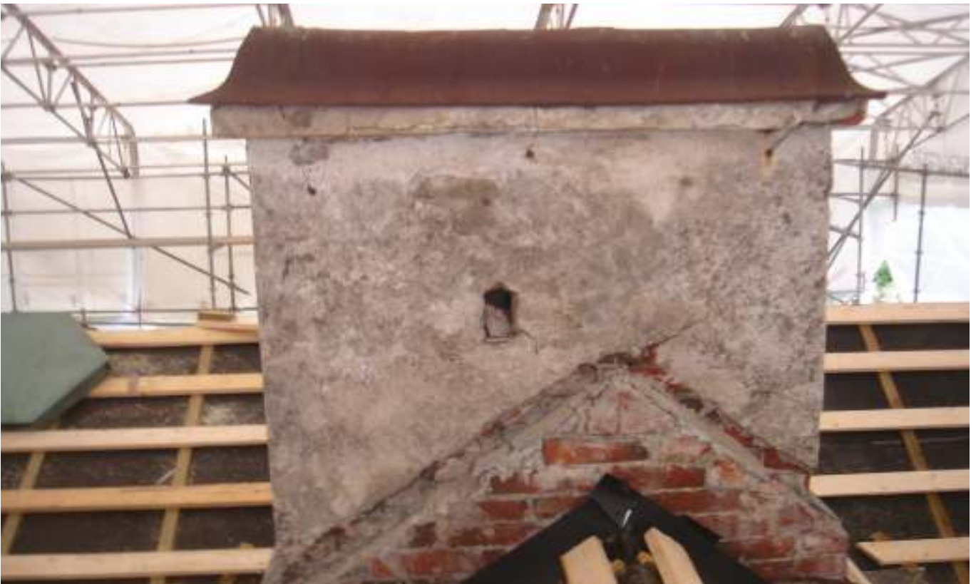
KUVA 2. Piippuryhmässä n:o 2 on reikä.
