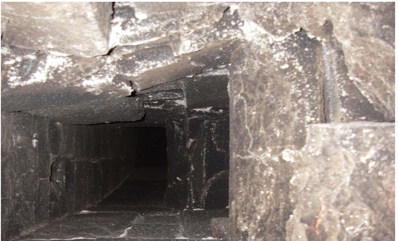
KUVA 8. Yleiskuva uunin n:o 1 savuhormista.
