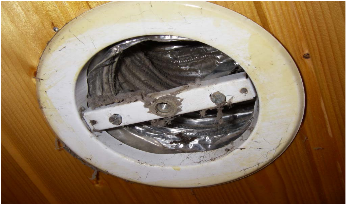
KUVA 2. Erillisen WC:n ja suihkun poistoilmakanava on ns. haitariputkea.
