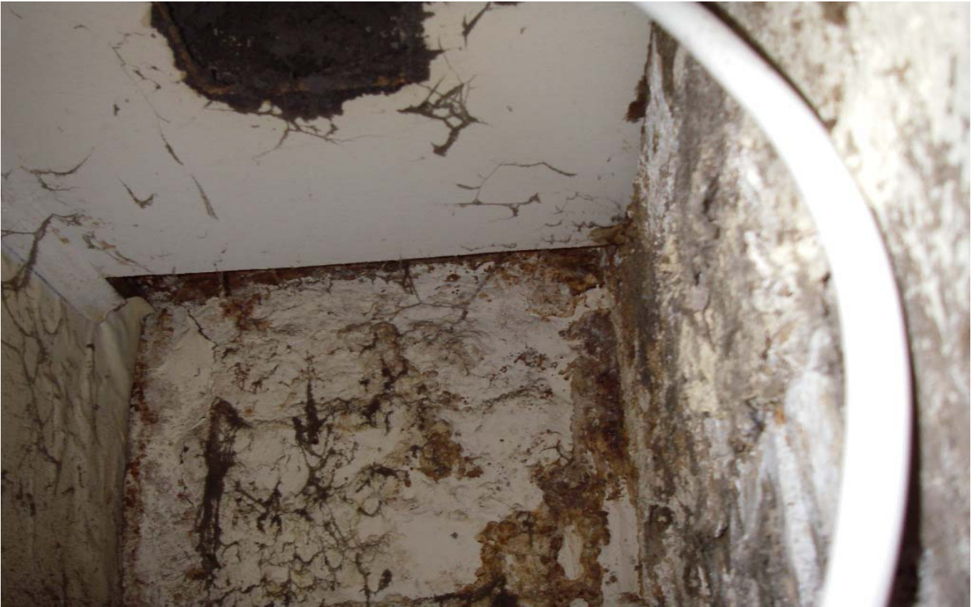
KUVA 3. Poistohormit ovat osin melko pölyisiä.
