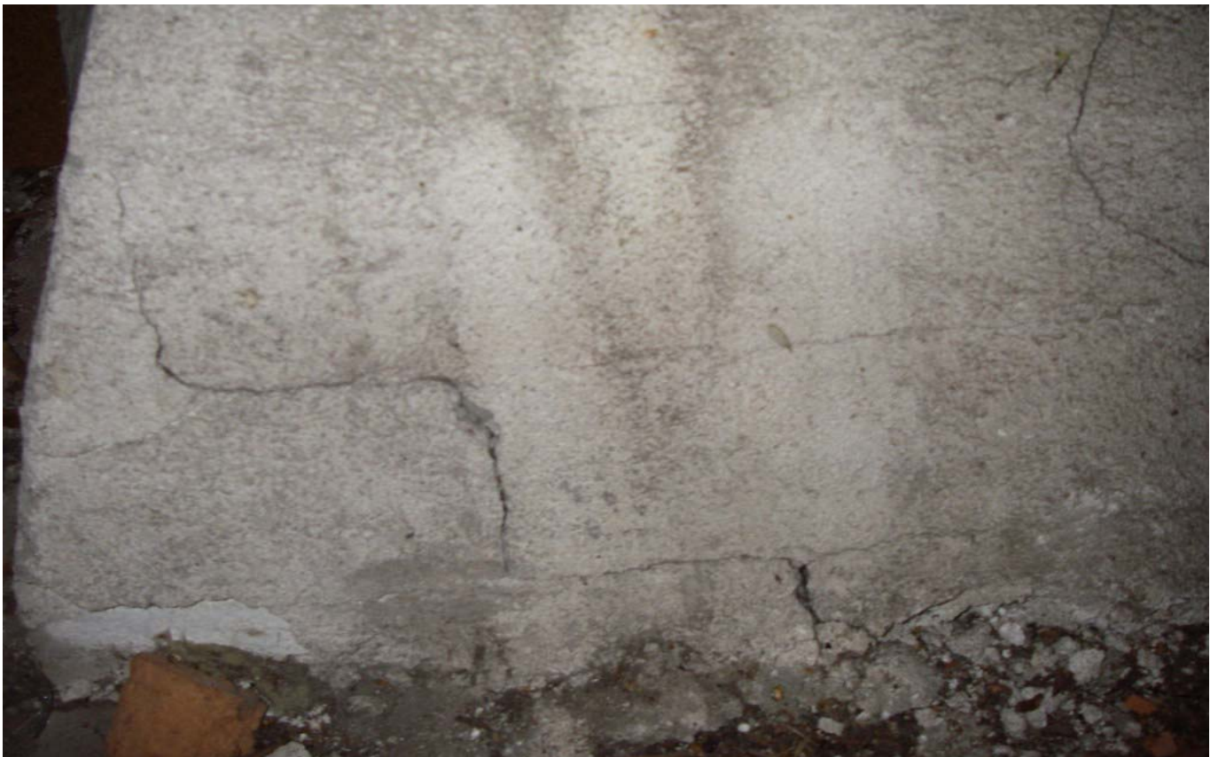
KUVA 16. Yleiskuva ullakolla olevasta savuhormista.
