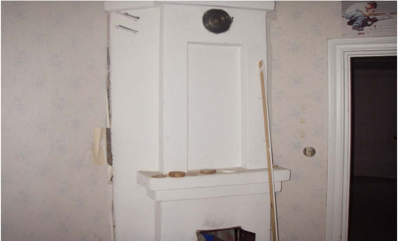
KUVA 5. Pystyuuneissa on korvausilmaventtiileitä.
