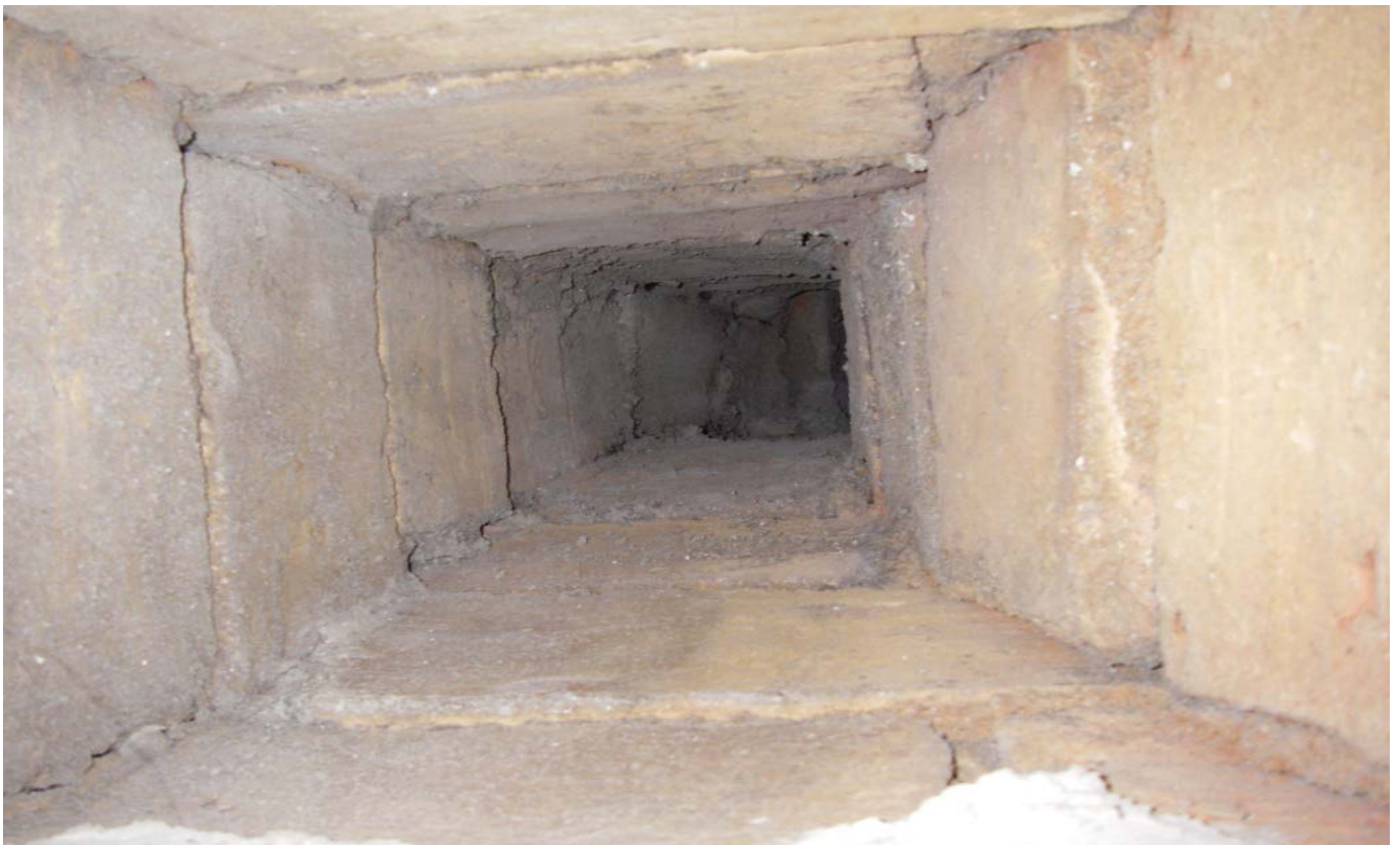
KUVA 10. Yleiskuva uunin n:o 2 savuhormista.
