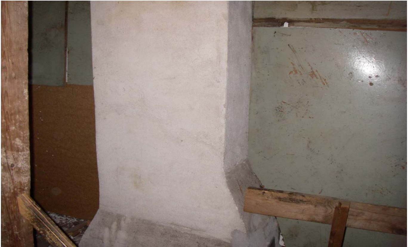
KUVA 17. Yleiskuva ullakolla olevasta savuhormista.
