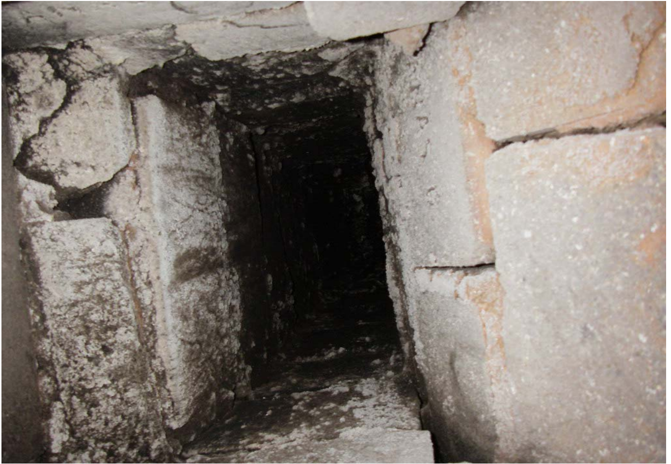
KUVA 13. Yleiskuva uunin n:o 4 savuhormista.
