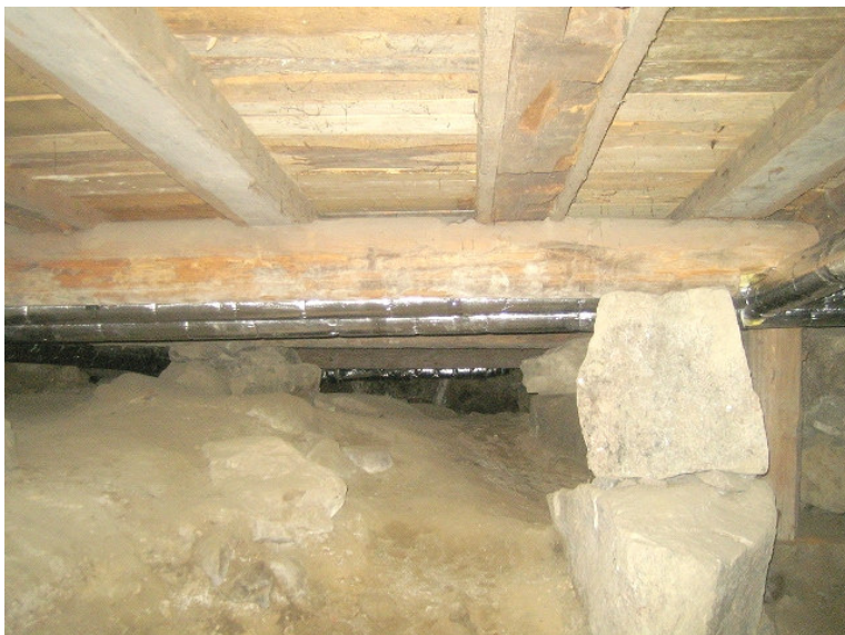
Kuva 1 Alapohjatilat olivat siistejä. rakennevaurioita ei havaittu.
