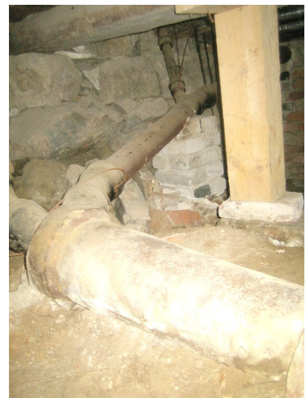
Kuva 2 Vanhat viemärit olivat valurautaa ja keraamista putkea.
