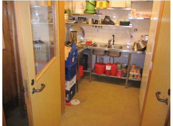
Keittiön muissa tiloissa ei havaittu kohonneita kosteusarvoja (tila 13).
