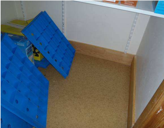
Ruokatavara varastossa ei havaittu kohonneita kosteusarvoja. (tila 12).
