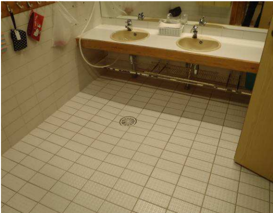
WC-tiloissa ei havaittu kohonneita kosteusarvoja (tila 26).
