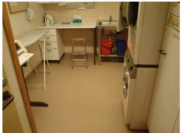
Vaatehuollon tilan pinnat olivat kunnossa siellä ei havaittu kohonneita kosteusarvoja (tila 9).
