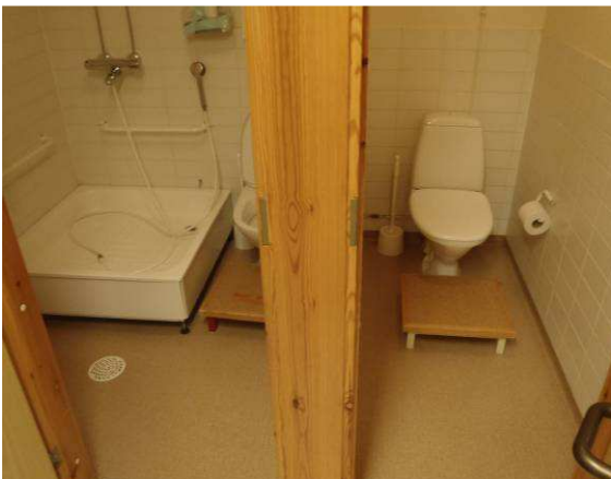
WC-tilassa pinnoitteet kunnossa, siellä ei havaittu kohonneita kosteusarvoja (tila 37).
