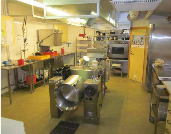
Keittiössä lattiassa on massapinnoite. (tila 13).
