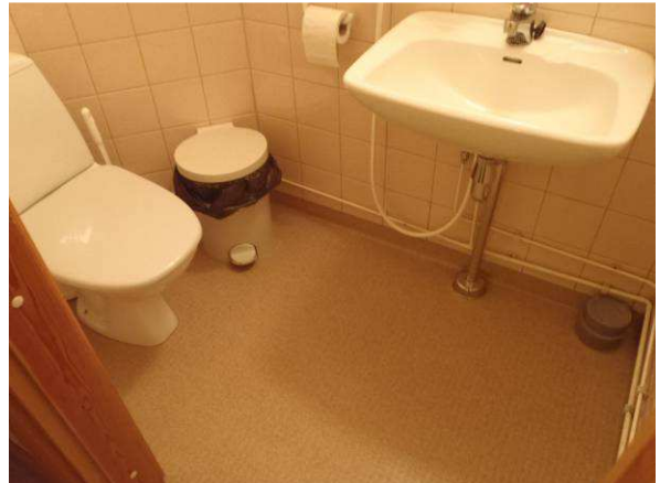
WC-tiloissa ei havaittu kohonneita kosteusarvoja (tila 31).
