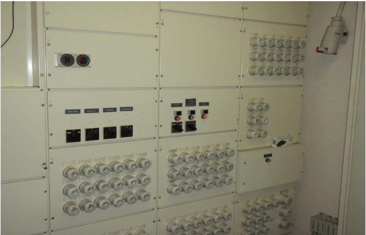
S-KUVA 3. Sähköpääkeskus
