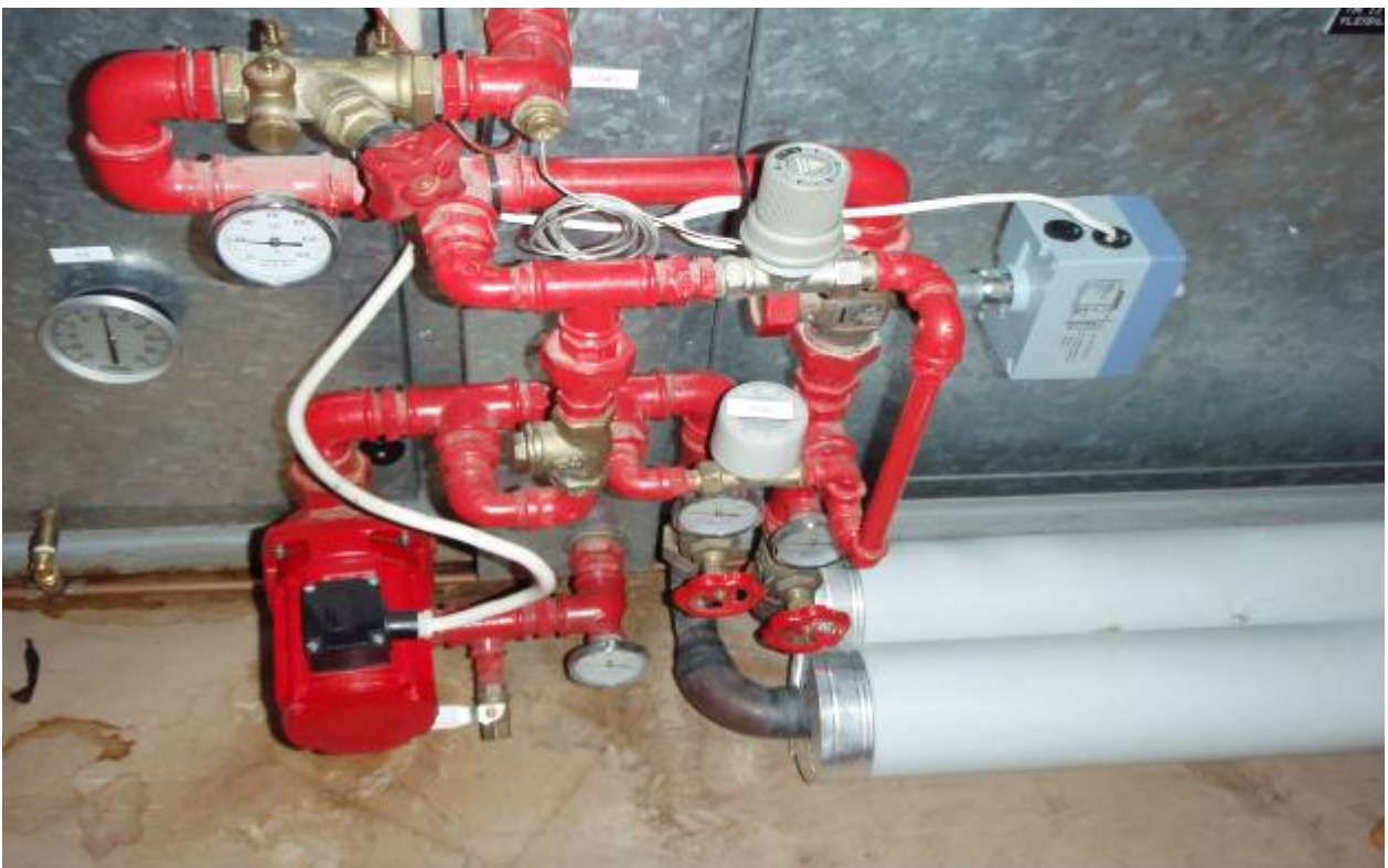
S-KUVA 14. IV- koneikon moottoriventtiili
