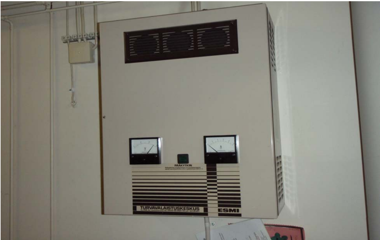
S-KUVA 11. Ovimerkkivalaistuksen keskus
