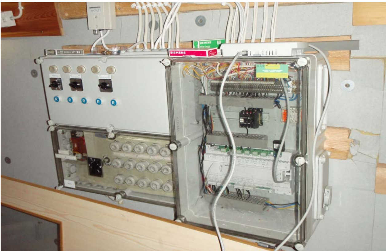
S-KUVA 12. IV- koneikon yksikkösäädin
