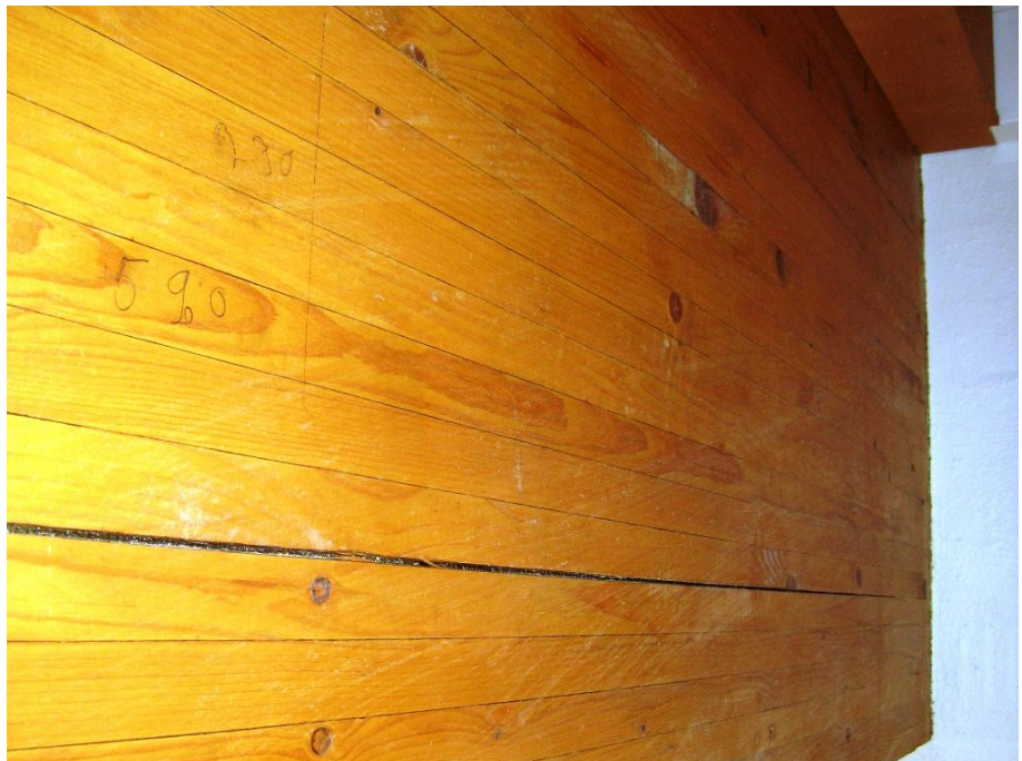
Kuva 4. Palkin 3 alempi halkeama puolapuupäädyn puolella näyttämön puoleisessa päässä. Halkeaman suurin mitattu syvyys oli 50 mm, toisella puolella palkkia ei ollut korkeussuunnassa halkeamaa samalla kohdalla.
