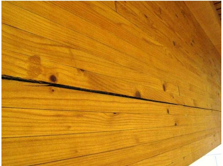
Kuva 1. Halkeama kuudennen lamellin yläreunassa, jonka syvyys oli suurimmillaan 65 mm.
