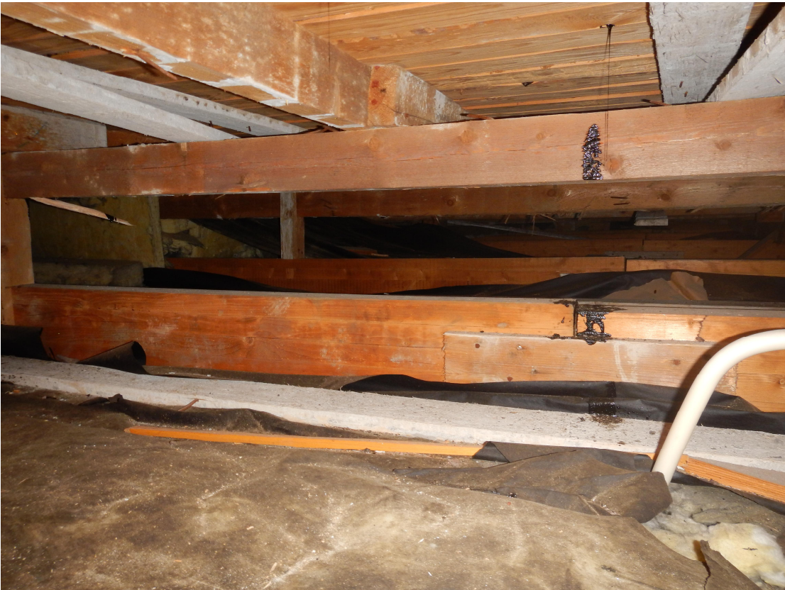
Kuva 2. Liikuntasalin yläpohja. Yläpohjan ilmatilassa ei havaittu aistinvaraisesti normaalista poikkeavaa hajua.
