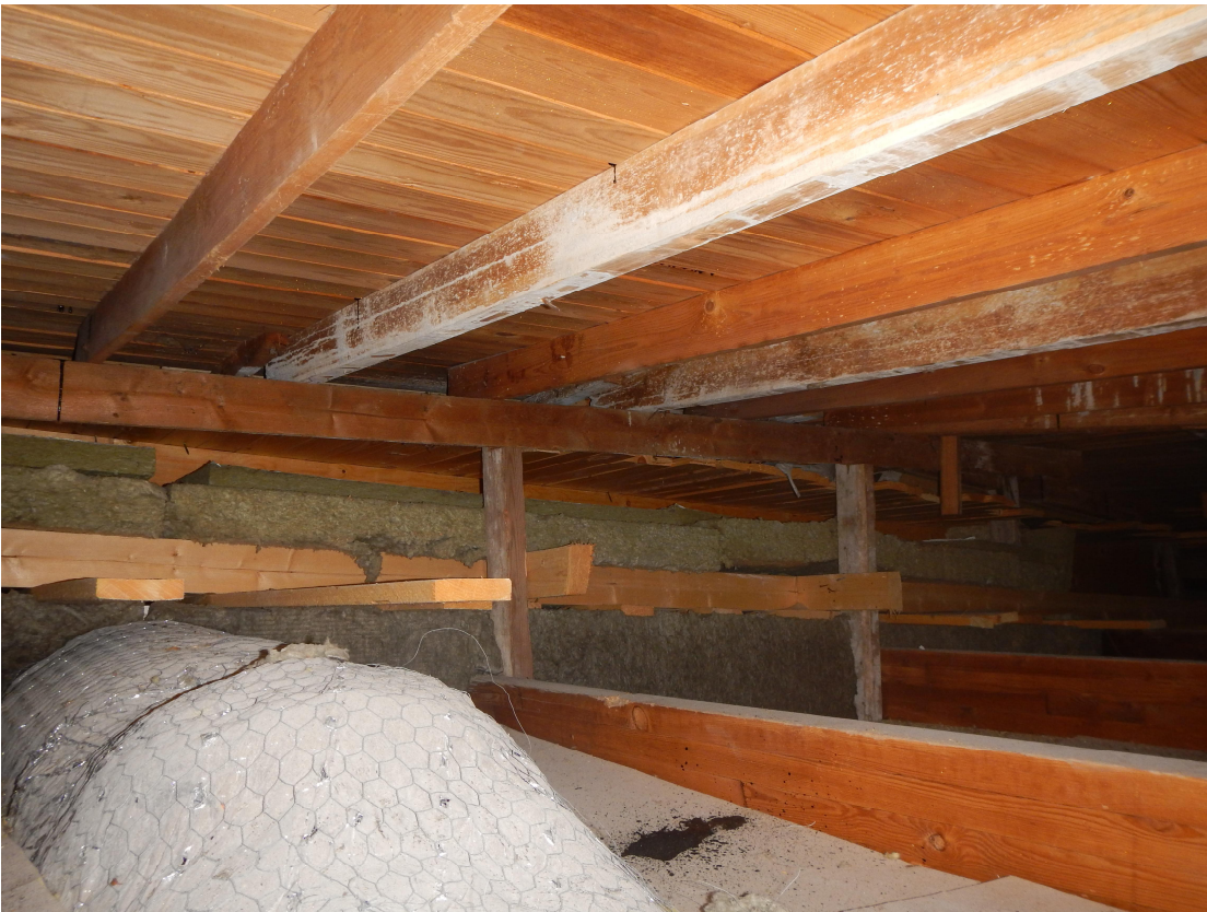
Kuva 7. Keittiön yläpohja. Yläpohjan ilmatilassa ei havaittu aistinvaraisesti normaalista poikkeavaa hajua. Keittiön yläpohjarakenteen ilmatilasta kaasu ei kulkeutunut liikuntasalin sisäilmaan.
