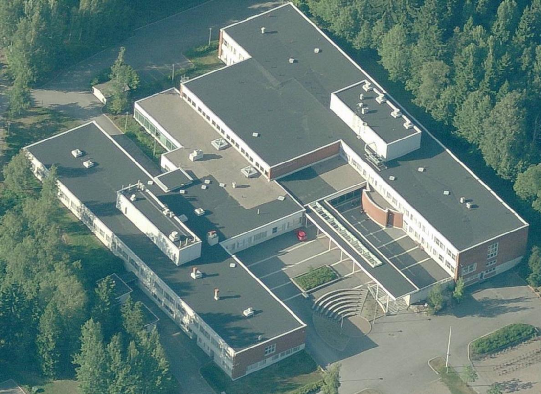
Kuva 1. Rakennuksen liikuntasalin kattorakenteiden ja liikuntasaliin yhteydessä olevien yläpohjarakenteiden siihen liittyvien kattorakenteiden ilmatiiveys suhteessa sisäilmaan
