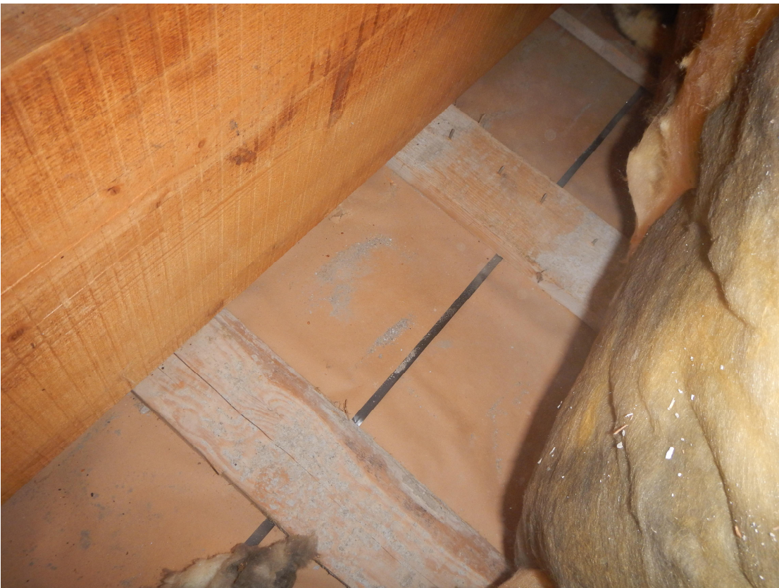
Kuva 4. Liikuntasalin yläpohja. Lämmöneriste (150 mm), harvalaudoitus, eristyspaperi
