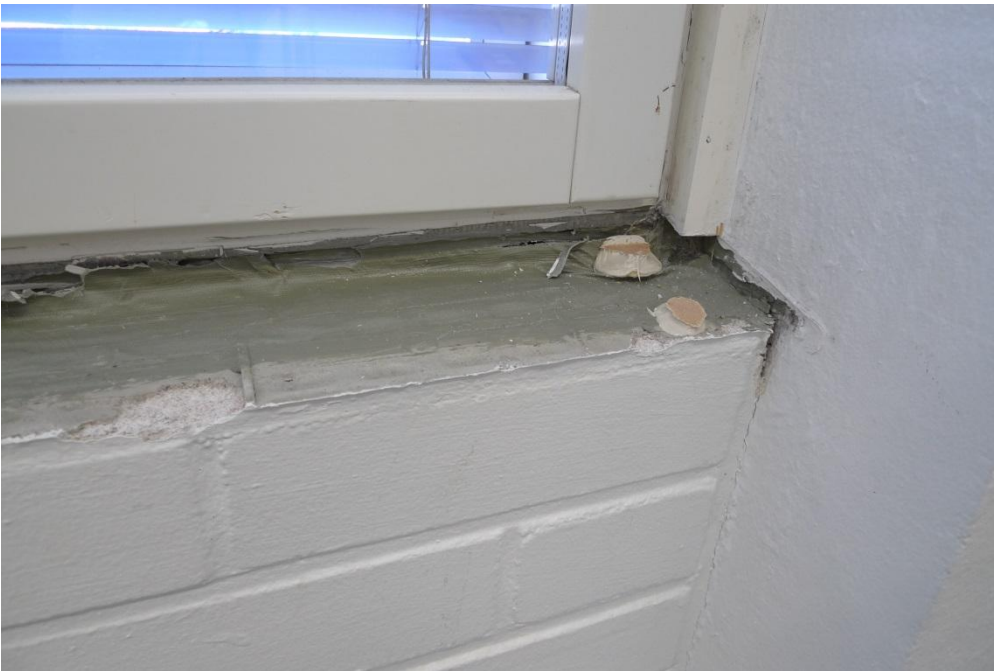
Kuva 13. AVAUS 5. 1060. Ikkunapenkin alle oli levitetty väristä päätellen Ardex S 1-K –vedeneristemassa. Ensimmäisen vedeneristemassakerroksen päälle oli liimattu butyyliteippi karmin ja ulkoseinän liitoksen tiivistämiseksi. Tämän jälkeen vedeneristemassa oli vielä levitetty butyyliteipin yli.
