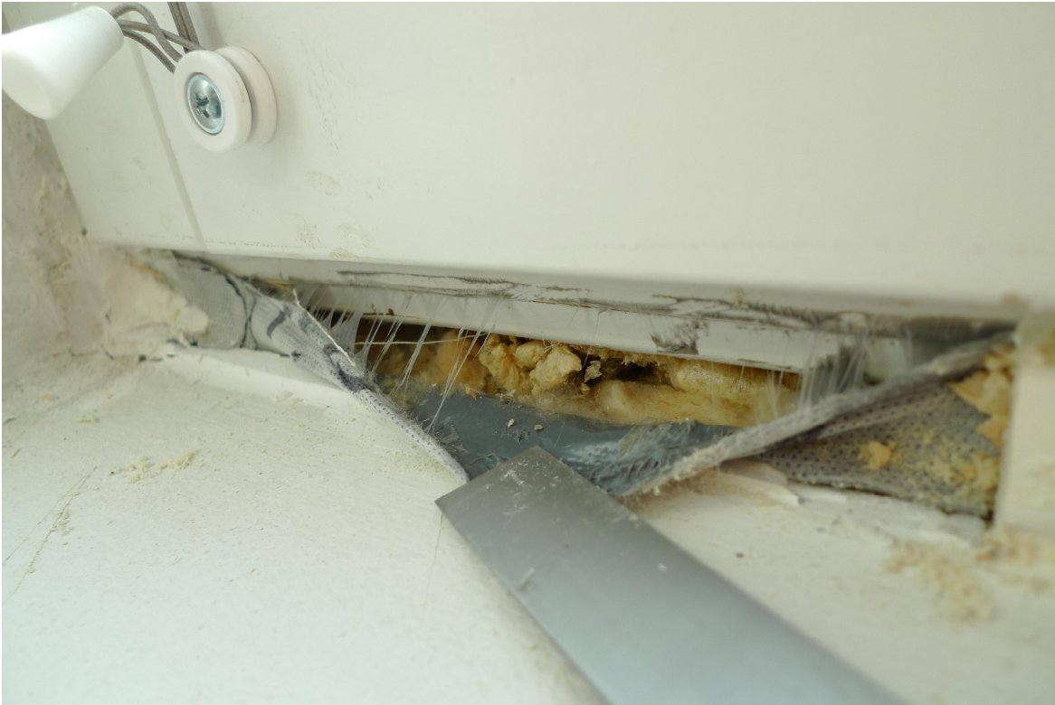
Kuva 23. AVAUS 8. Codex-nauha oli kiinnitetty osin tyhjän päälle villaa ja uretaania sisältävän raon yli.
