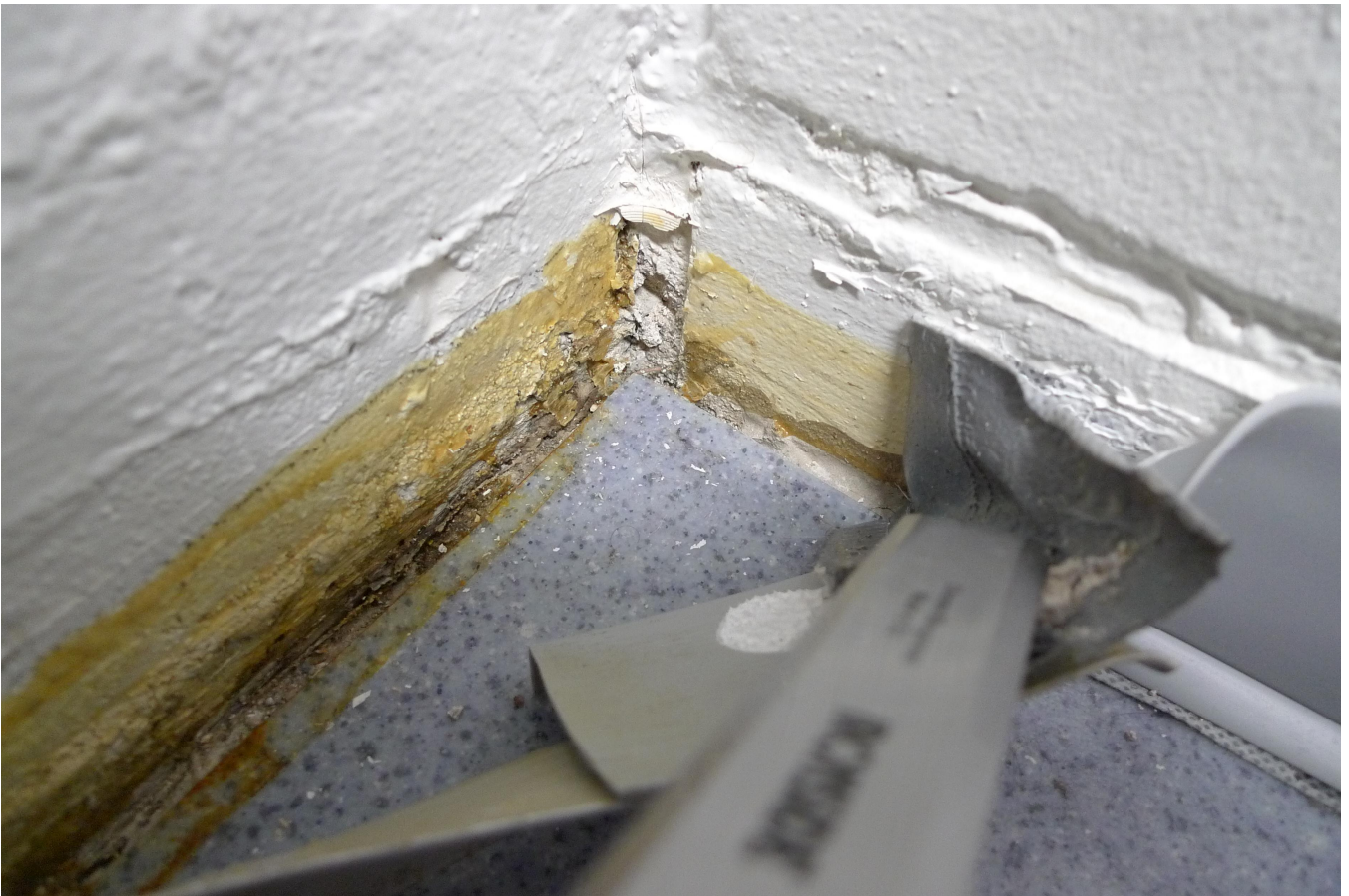
Kuva 9. AVAUS 3. 1004. Codex-nauha oli myös tässä kiinnitetty suoraan vanhan listaliiman päälle epäta- saiselle pinnalle, ja sen tartunta oli huono.
