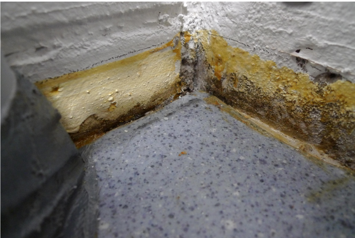
Kuva 6. AVAUS 2. 1004. Codex-nauha lähti helposti irti huonon tartunnan vuoksi.
