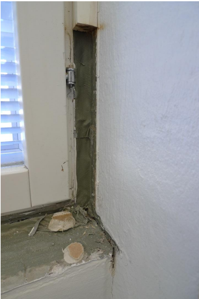
Kuva 15. AVAUS 5. 1060. Ikkunan ja pilarin välisestä liittymästä poistettiin listaa.
