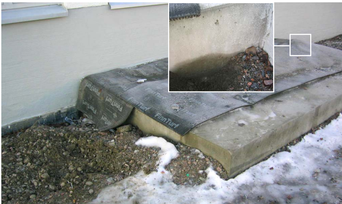
Kuva 5. Vanhan hiililuukun uusi "kansi". Perusmuurilevy näkyy varsinaisella talon seinälinjalla, muttei hiililuukun osalla (pienempi osakuva). Kuvat on otettu 10.12.2004.
