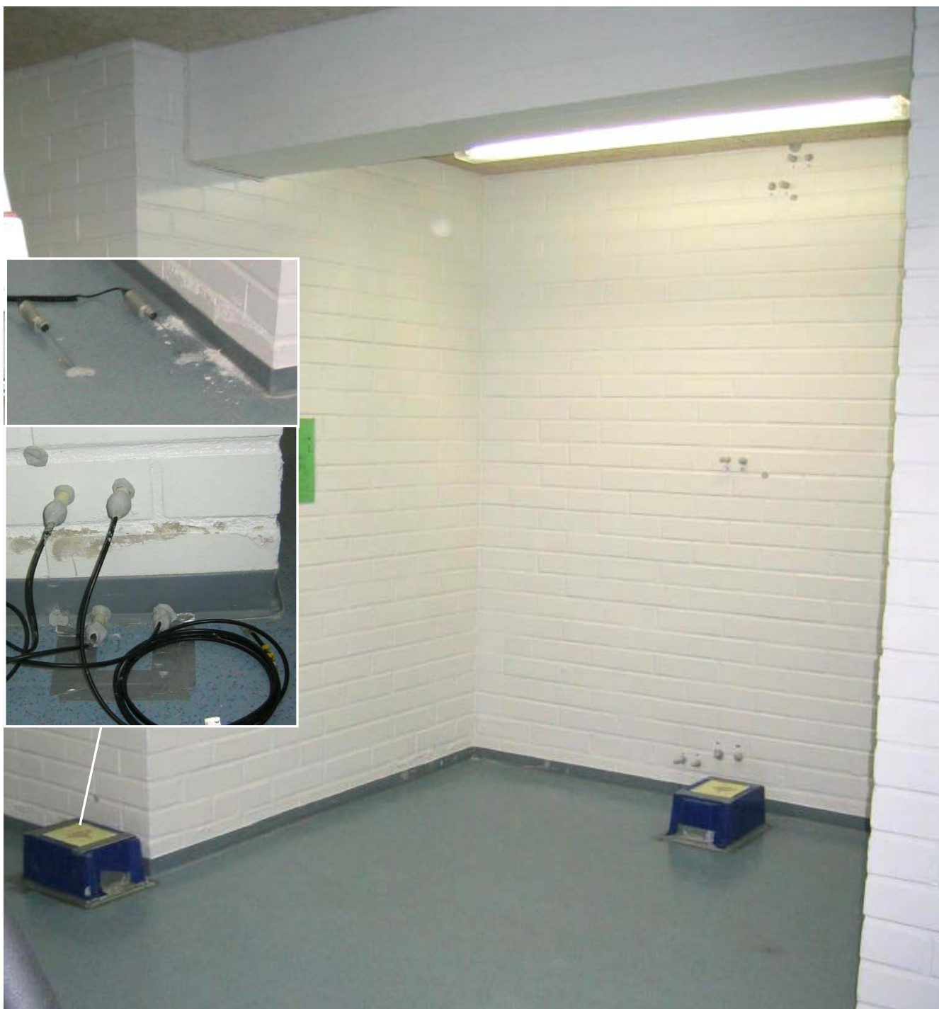
Kuva 3. Lattiamittauspisteisiin asennetut mittapäät suojattuina ja hiililuukun seinän porareikämittapisteeet valmisteltuina 10.12.2004 klo 15:30. Ylemmässä pienessä kuvassa näkyy porareikämittauskohdan viiltomittaukset käynnissä ja alemmassa pienessä kuvassa on HMP44 mittapäät vastaavan seinämittauskohdan mittausputkissa.
