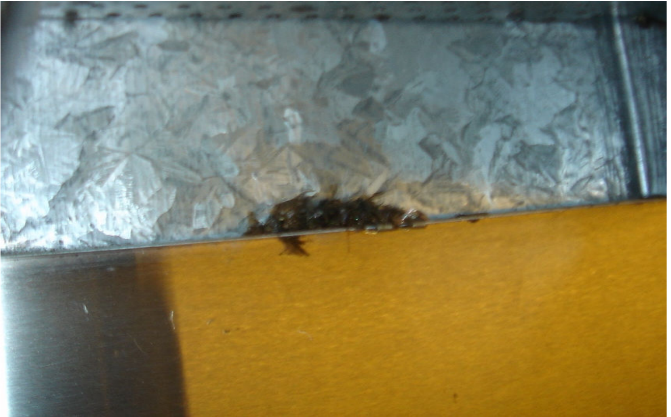
KUVA 20. Tasauslaatikossa on melko paljon kuolleita hyönteisiä.
