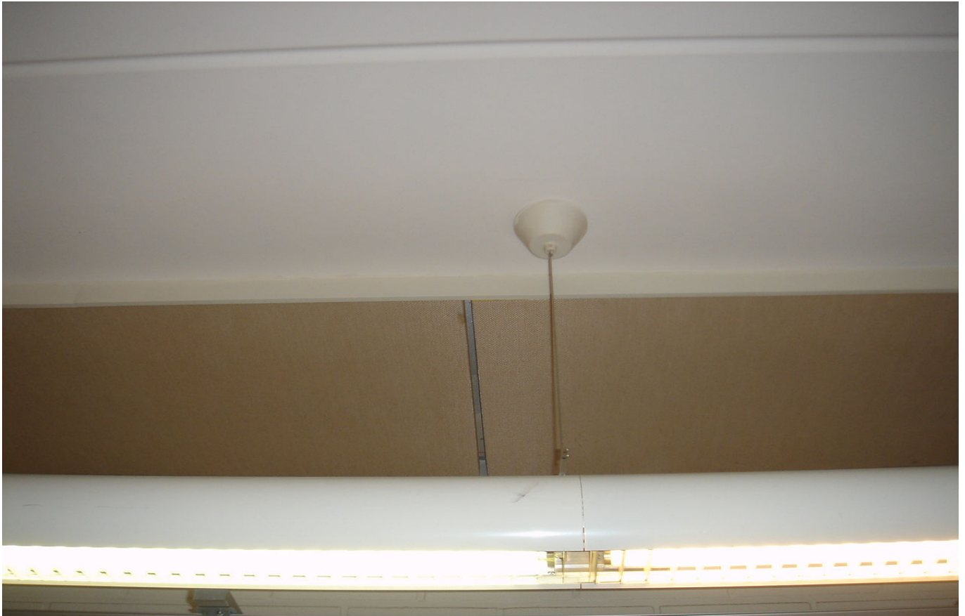
KUVA 22. Yleiskuva luokkahuoneen katosta.
