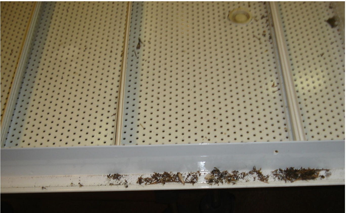
KUVA 21. Tasauslaatikossa on melko paljon kuolleita hyönteisiä.
