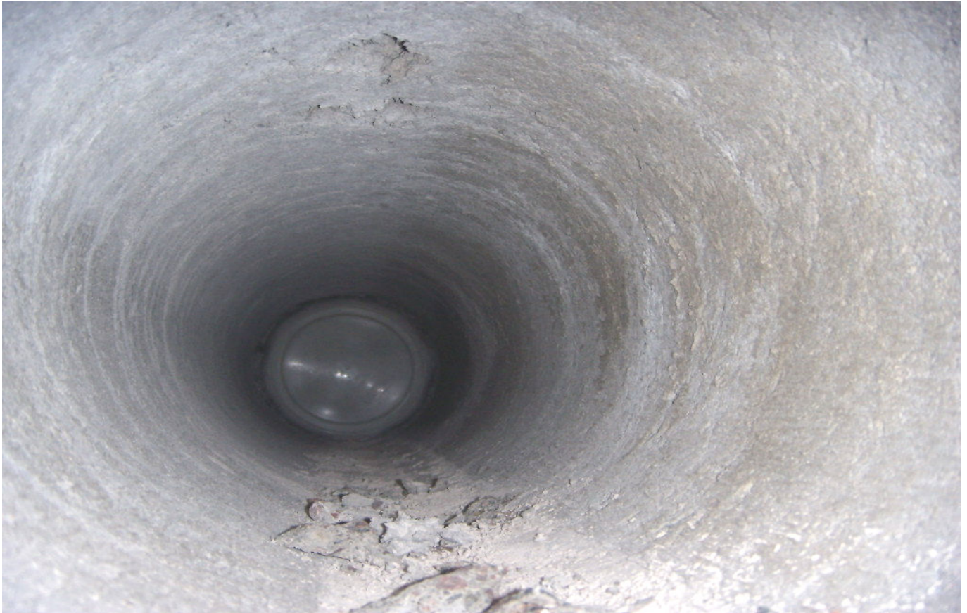
KUVA 16. Yleiskuva ontelokanavasta, jonka pinta on paikoin kolhiintunut.
