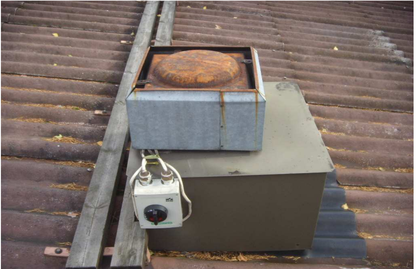
KUVA 14. Yleiskuva vesikatolla olevasta poistoilmapuhaltimesta.
