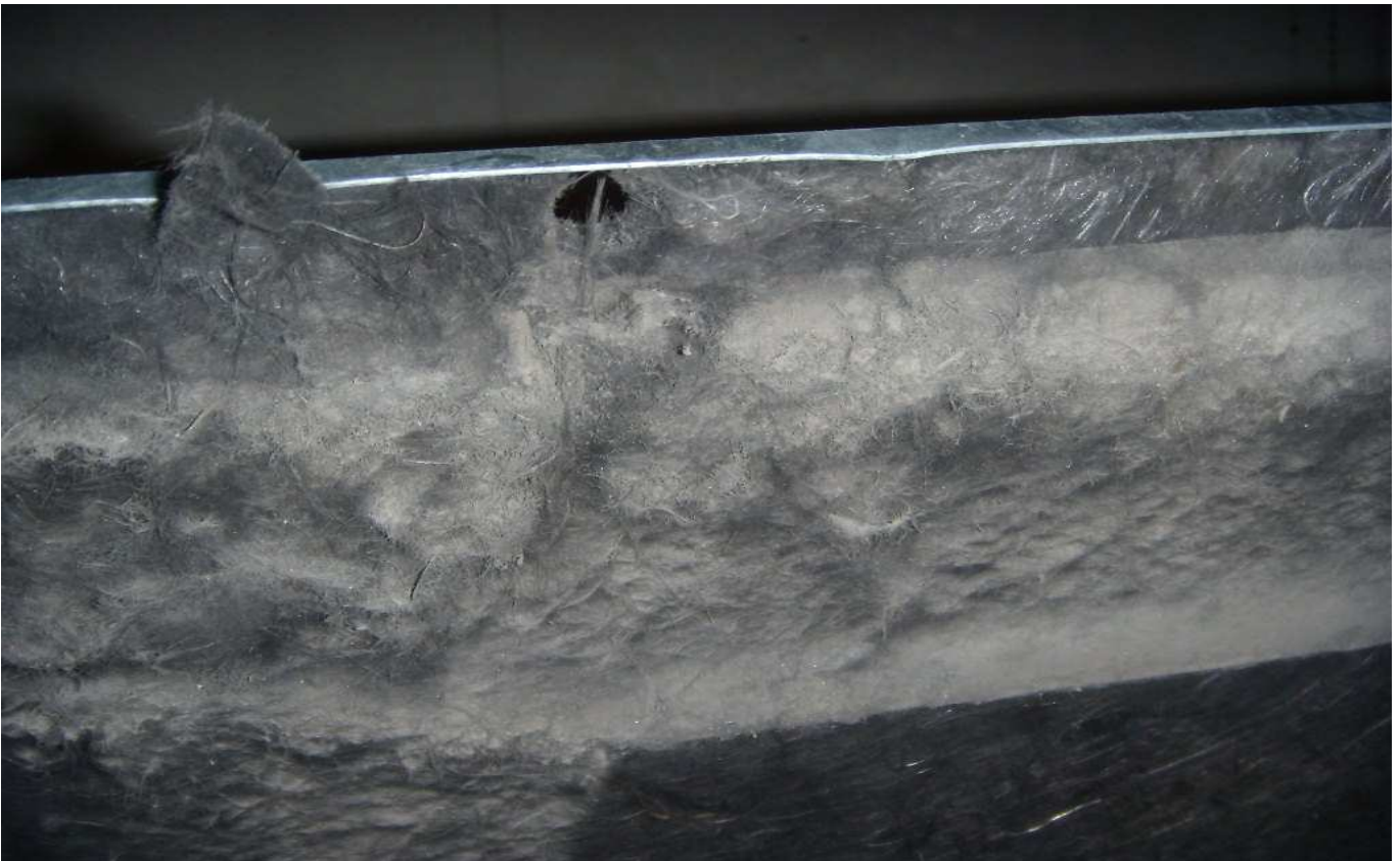
KUVA 13. Yleiskuva tuloilmakoneen luukusta TK 1.
