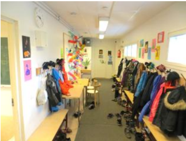
kuva 7 Käytävän lattialla on kuramatot muovimaton päällä, muovimaton saumat on hitsattu.
