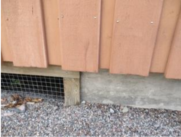
kuva 11 Kulunut maalipinta, alapäitä ei ole maalattu.
