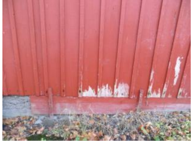
kuva 34 Kulunut lautaverhoukset.
