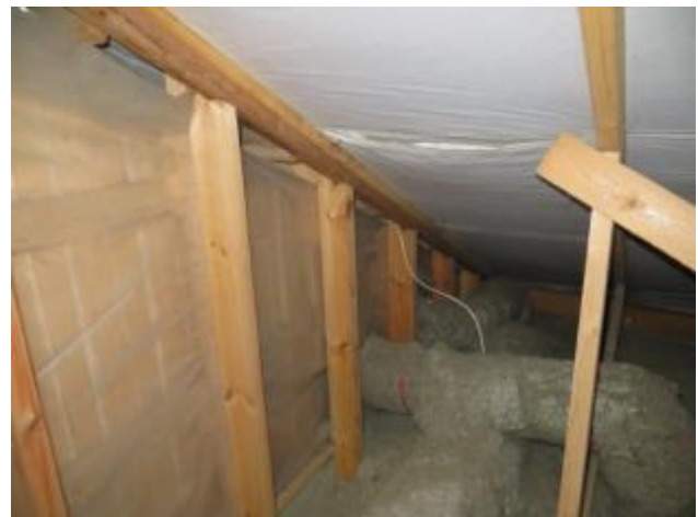
kuva 24 Länsipäädyn muovikelmu estää tuulen ja sateen
