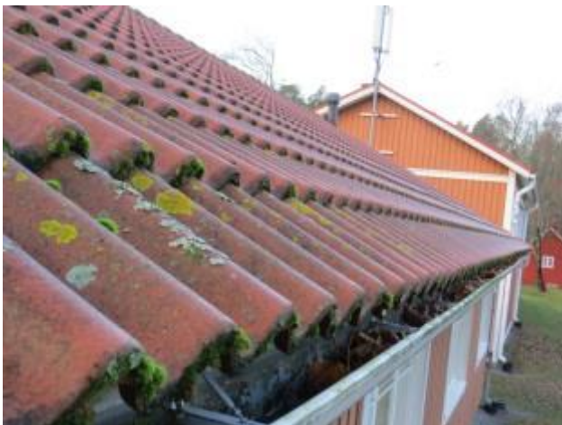
kuva 23 Rännien puhdistaminen on poikkitukien takia hankala, rännit voivat tulvia yli.
