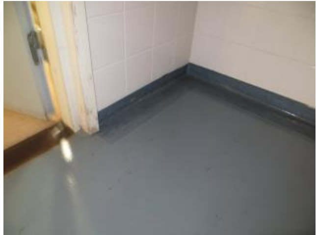
kuva 6 Seinien ja lattian liittymiä on korjattu. Oven karmien ja peitelistan alaosassa on kosteusvaurioon viittaavia jälkiä. Kunnollista kynnystä ei ole.
