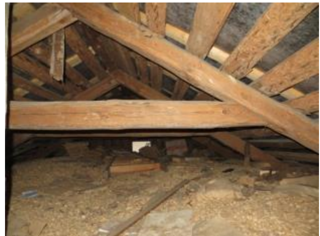
kuva 32 Lämpimän osan yläpohjan purueristys.
