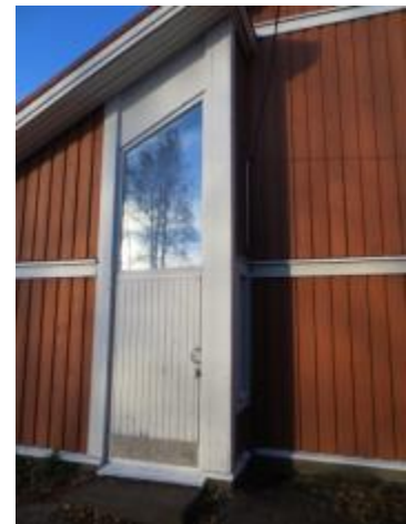
kuva 14 Varauloskäynnin puuovi ja umpilasi-ikkuna.
