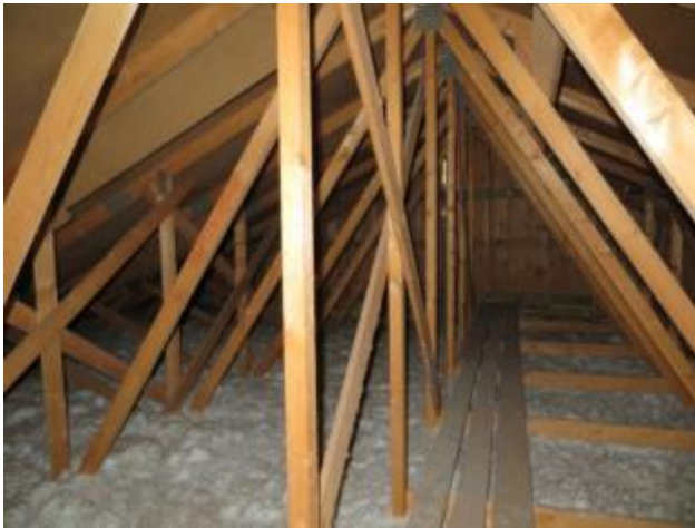
kuva 19 Yläpohjaonteloa salin kohdalla.
