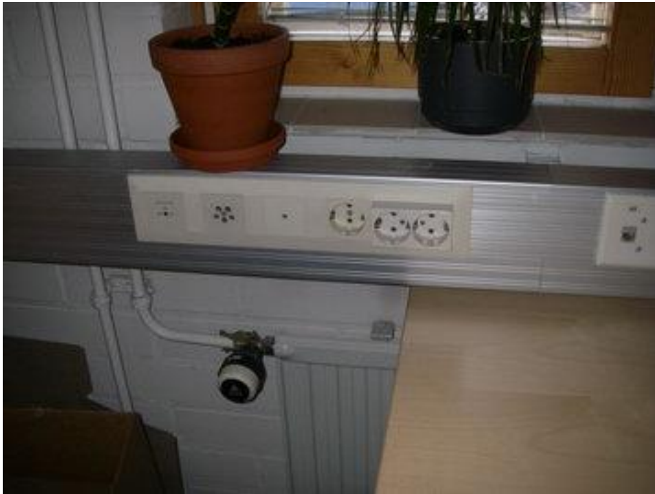
Alkuperäinen metallikouru ja kalusteet.
