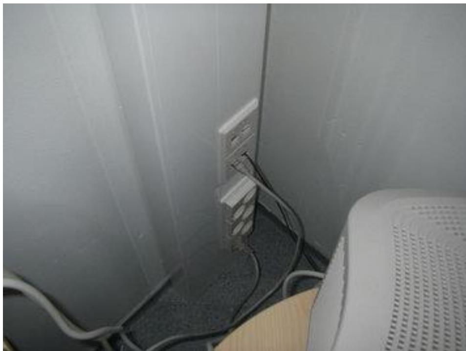
Uusittu muovikouru pohjoispuolen toimiston tiloissa.
