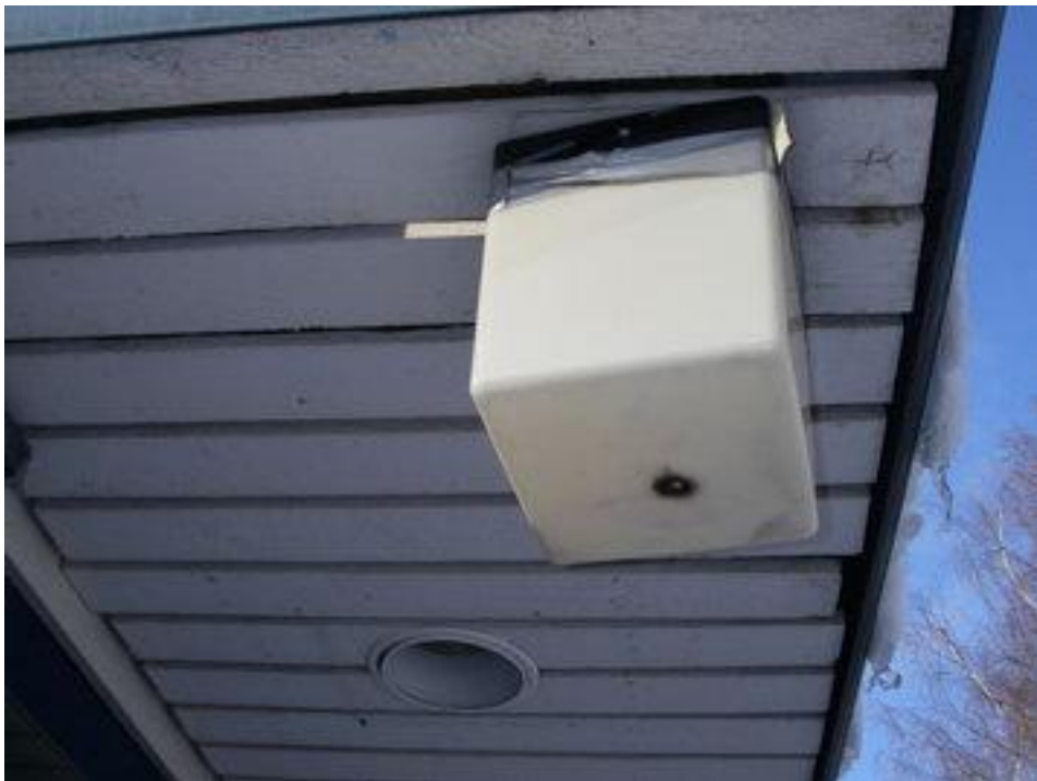
Aluevalaisimen kupu on kiinnitetty teipillä.
