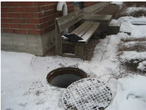
Kuva 5 Tutkittu perusvesikaivo 061 kulmalla.
