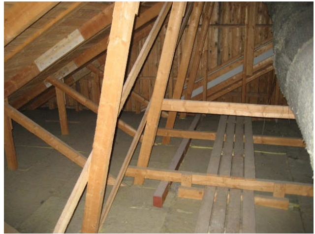
Kuva 16 Yleiskuva alkuperäisen osan ullakolta.
