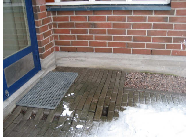
Kuva 10 Vuotava ränni liukastaa kiveyksen. Epätasainen kiveys on vaarallinen.
