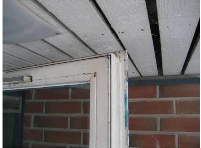
Kuva 14 Alkuperäisen osan lasiovet eivät ole tiiviitä.
