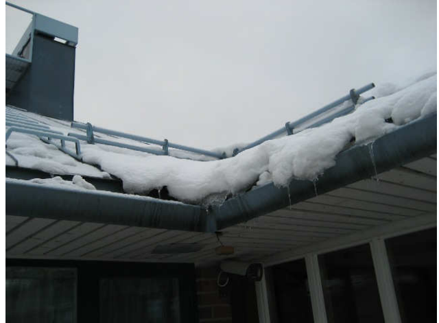
Kuva 2 Jiireihin jäävä lumi ja jää padottaa sula- vesiä.
