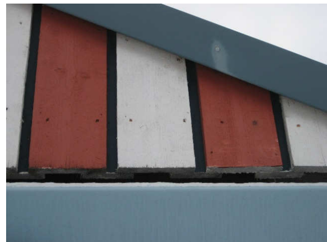
Kuva 12 Alkuperäisen osan laudoituksen päissä ei ole tippanokkaa ja päät ovat maalattua.
