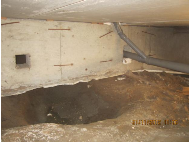
Kuva 31 Lohko 1, alituskaivanto Lohko 5, maa märkä, mikrobeja sekä lahoa puuta
