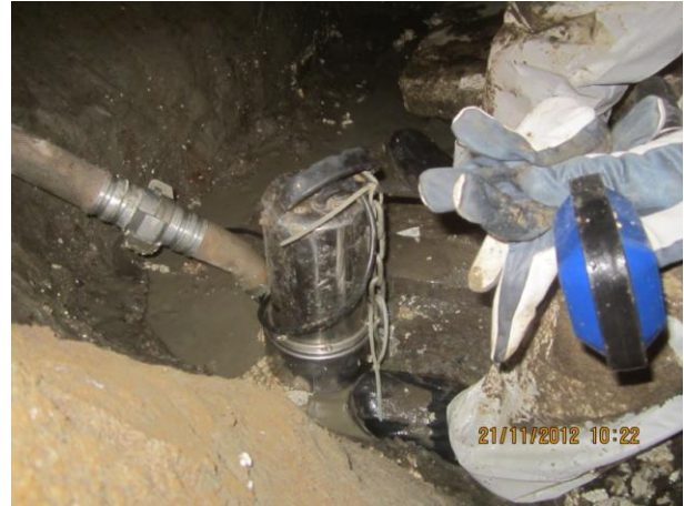
Kuva 14 Lohko 2 alituskaivannosta poistettiin savinen vesi uppopumpulla
