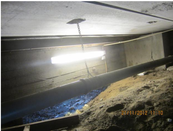
Kuva 9 Lohko 1, HL1 kohta sisäpuolelta
