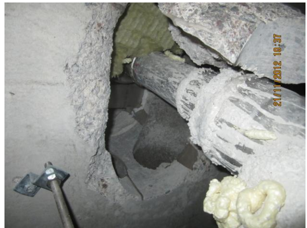
Kuva 22 Lohko 2, keittiön rst-kaivon pohja
