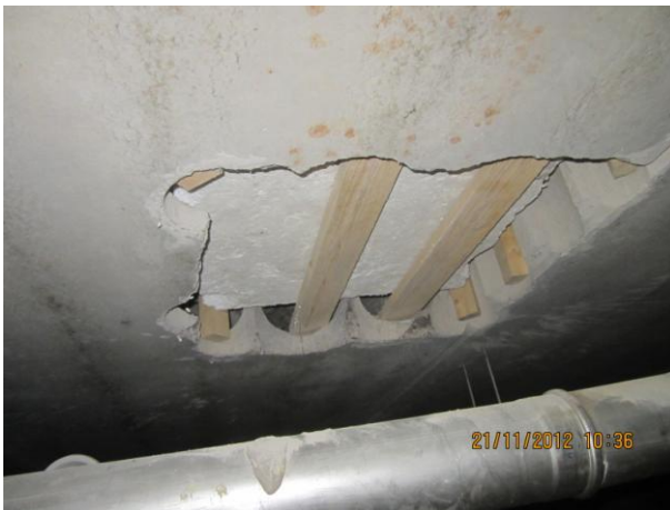
Kuva 21 Lohko 2, keskeneräinen kulkuaukko keskialueella
