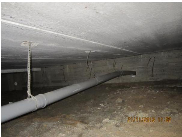
Kuva 35 Lohko 6, perusvesiviemäri (?) köyryllä
