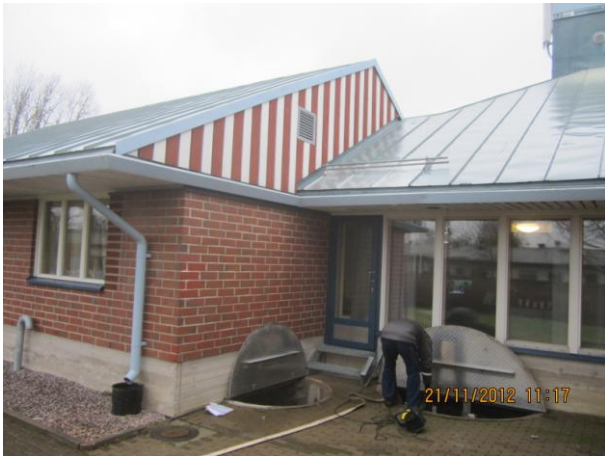
Kuva 43 Eteläsivu, huoltoluukut HL3 ja HL4
