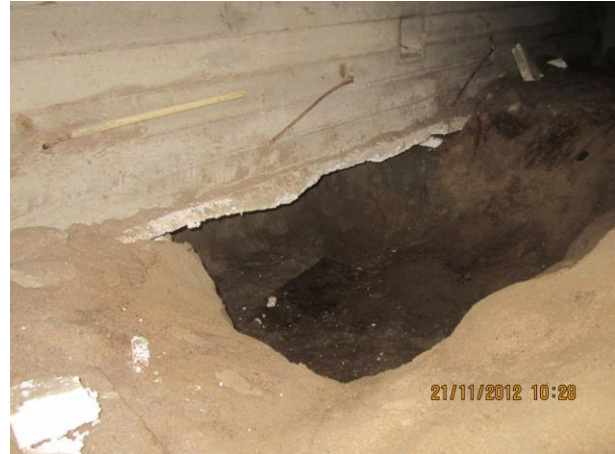
Kuva 26 Lohko 2, alituskaivanto Lohko 4 alustaan, pohjamaa on märkä
