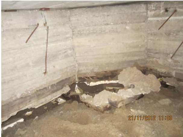
Kuva 33 Lohko 6, peräkulmalla maa vajonnut, märkää, mikrobeja lahoa puuta
