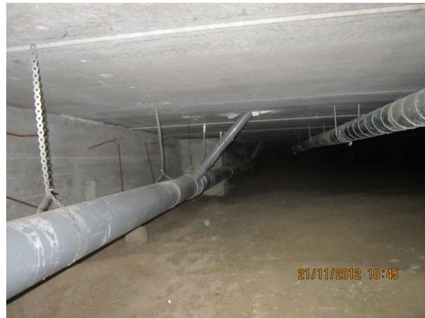
Kuva 10 Lohko 1 alustaa, maan pinta kova, ohut hiekka, paikoin mikrobeja
