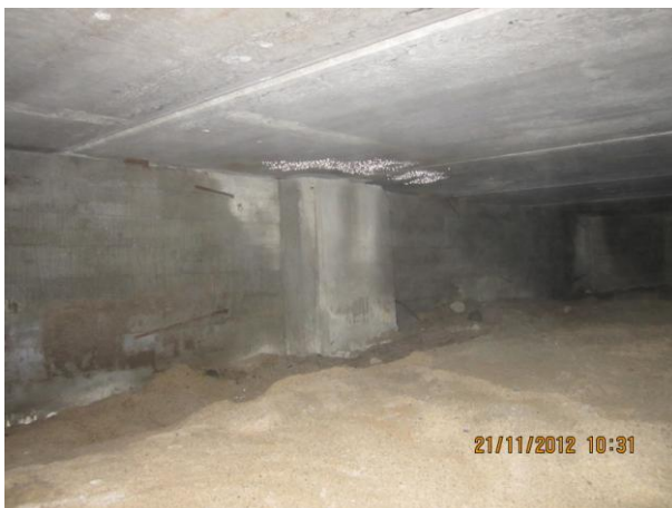
Kuva 29 Lohko 4, keskialue, kondenssia ja kosteutta
