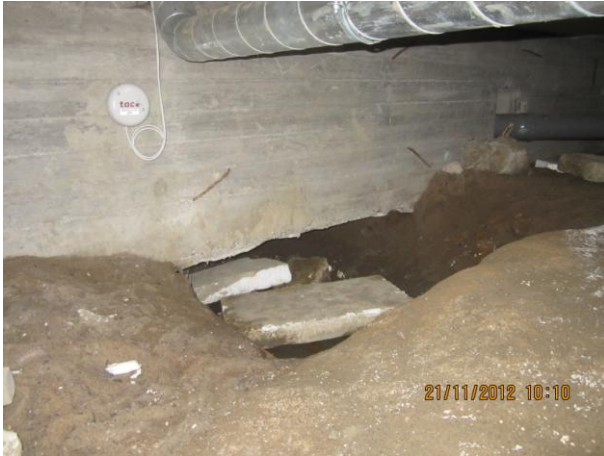
Kuva 13 Lohko 1, alituskaivanto Lohko 2, kosteusanturi peruspalkin sivulla.
