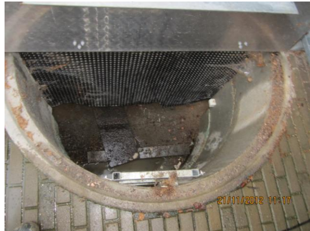
Kuva 44 HL4 pohjalta pumpattiin vesi pois
