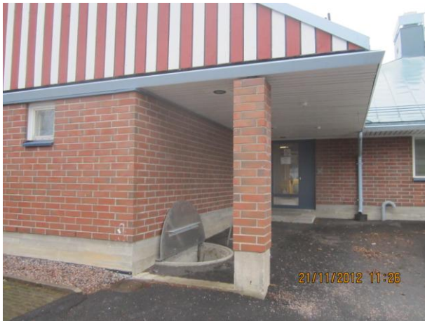
Kuva 37 Huoltoluukku HL2 Lohko 6 itäisivulla
