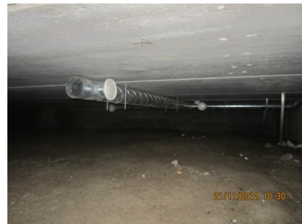
Kuva 30 Lohko 4, maan pinta on märkä, mikrobeja
