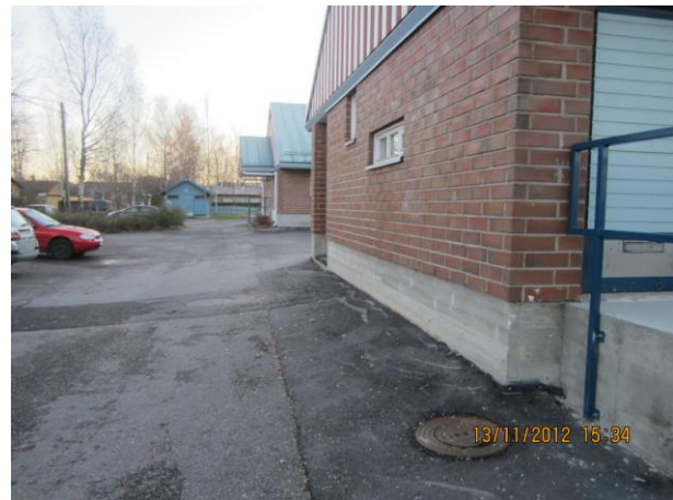
Kuva 2 Yleiskuva itäisivulta, uutta asfalttia.
