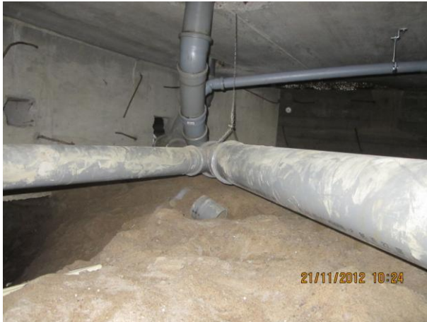
Kuva 15 Lohko 2, vasemmalla alituskaivanto Lohko3 alustaan, perällä kondenssia
