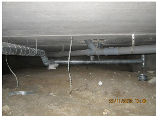
Kuva 24 Lohko 2, lähellä eteläsivua, mikrobeja, kostea maanpinta
