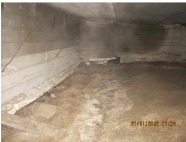
Kuva 41 Lohko 6, itäisivun sokkelin yläosa märkä
