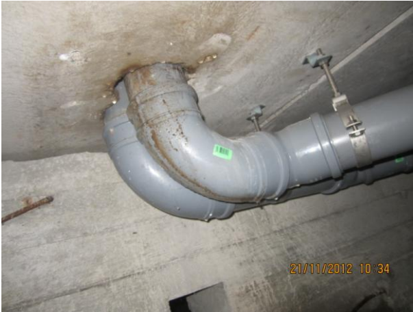
Kuva 19 Lohko 2, vuotava viemäri lähellä keittiötä, virtsanhajua lähistöllä
