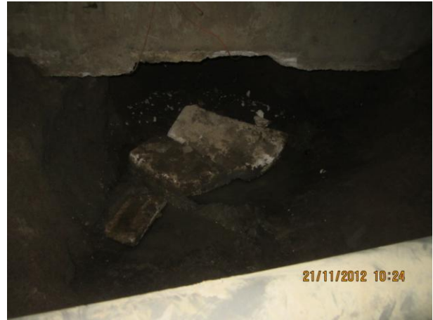
Kuva 16 Lohko 3 alituskaivannon pohjalla oli vettä ja savista maata, tästä ei kuljettu
