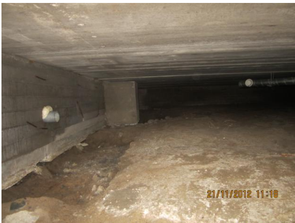
Kuva 45 Lohko 7, maan pinta kova, mikrobeja, lahoa puuta, märkä sokkeli
