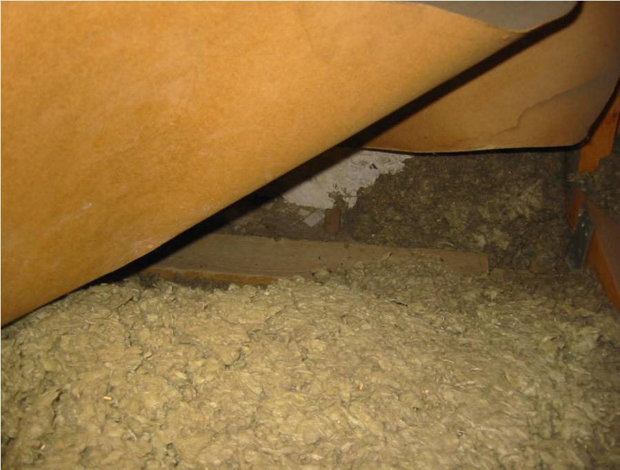
Kuva 11. Tuulenojaimen alla näkyy yläpohjan ontelolaatta (ei eristystä).
