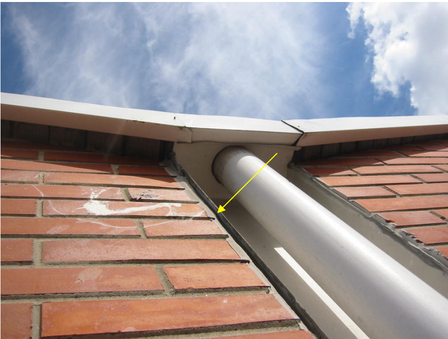
Kuva 26. Juhlasalin ulkoseinän räystäärakenne C1- ja C2-osalla. Räystäärakenteeseen ei liity yläpohjan tuule- tusta (räystääs umpinainen). Seinäsyvennyksessä on U-muotoisen pellin ja julkisivuelementin välissä rako (nuoli).
