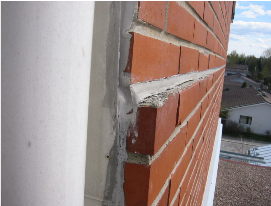
Kuva 27. Hammastus C2-osalla julkisivuelementin vaakasaumassa.
