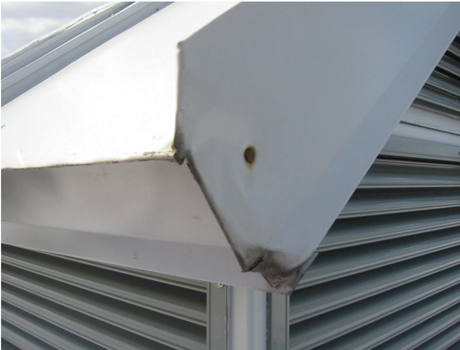
Kuva 17. Myös käytetyt pop-niitit ovat ruostuneet.
