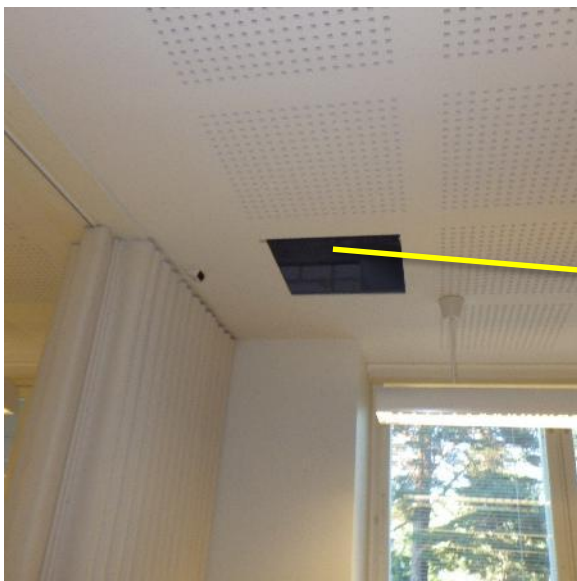
Kuva 13. Luokassa 240 alakaton tarkastuskohta
