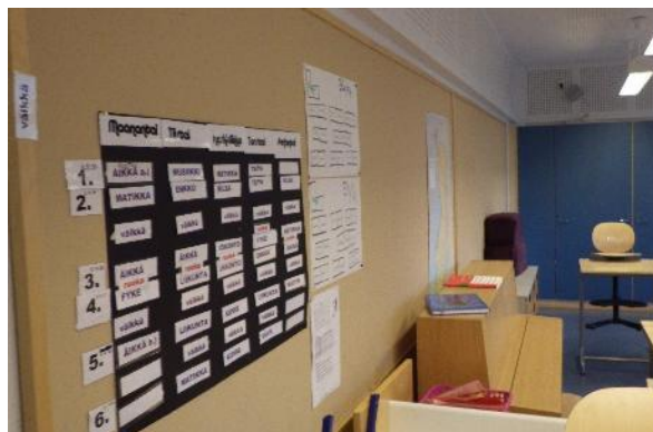
Kuva 26. Luokissa on käytetty yleisesti linoleum-pohjaisia ilmoitustauluja.
