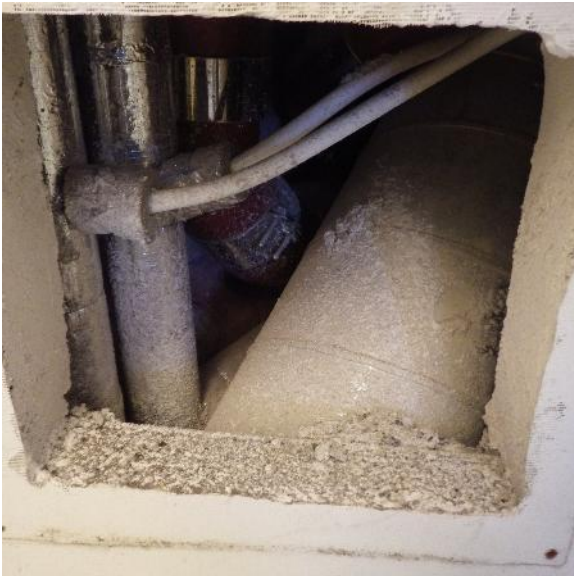
Kuva 17. Luokkien 209-211 kohdalla sijaitsee rakennusaineiset hormit. Tarkastusluukut hormiin ovat luokkien puolella.
