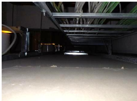
Kuva 24. Neuvotteluhuoneen 229 alakattotilan tarkastuskohta. Havaittavissa ei ole sisäilmaongelmiin viittaavia seikkoja.
