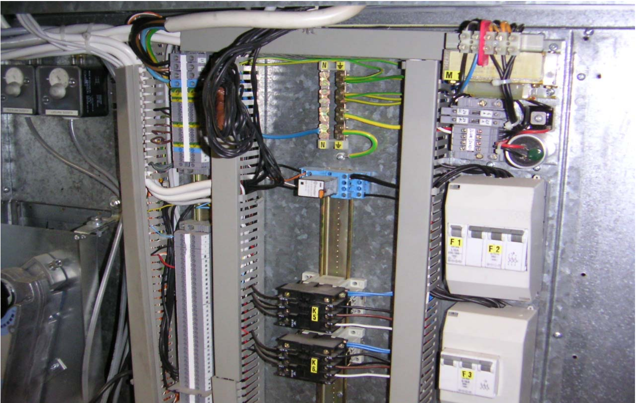
KUVA 2. Poistopuhaltimen luukku ei saa kokonaan auki.
