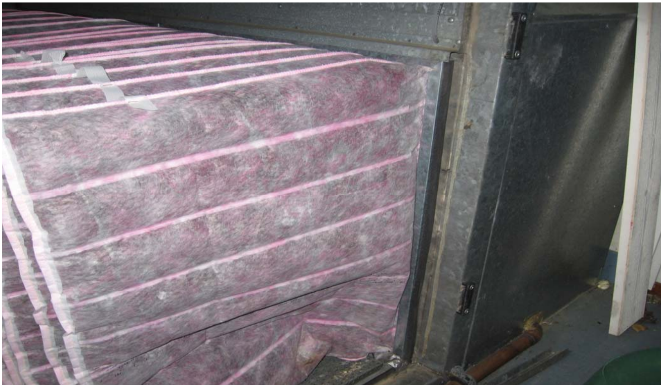
KUVA 3. Suodattimet ovat melko puhtaat, mutta suodatinseinät eivät ole tiiviitä.
