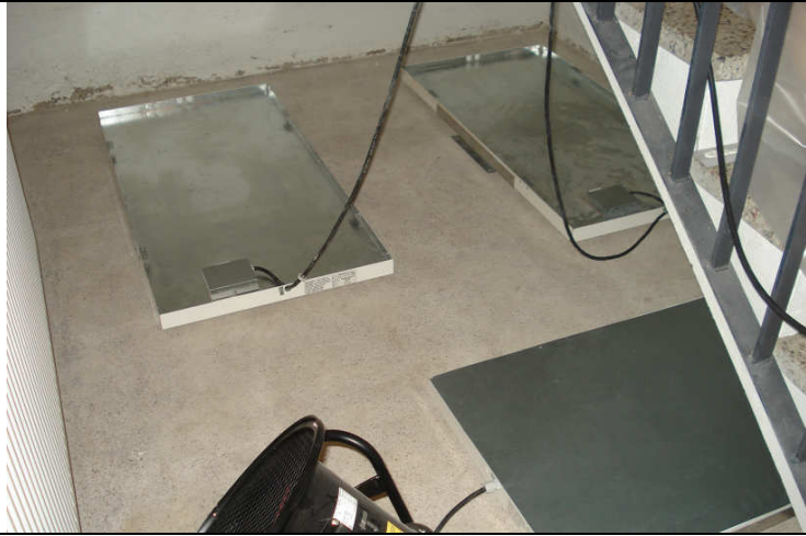
Kuva 1. Porrashuone C/ tila 059. Vinyyliilaatat poistettu. Liima ja tasoite jyrsitty. Kuivaus asennettu.
