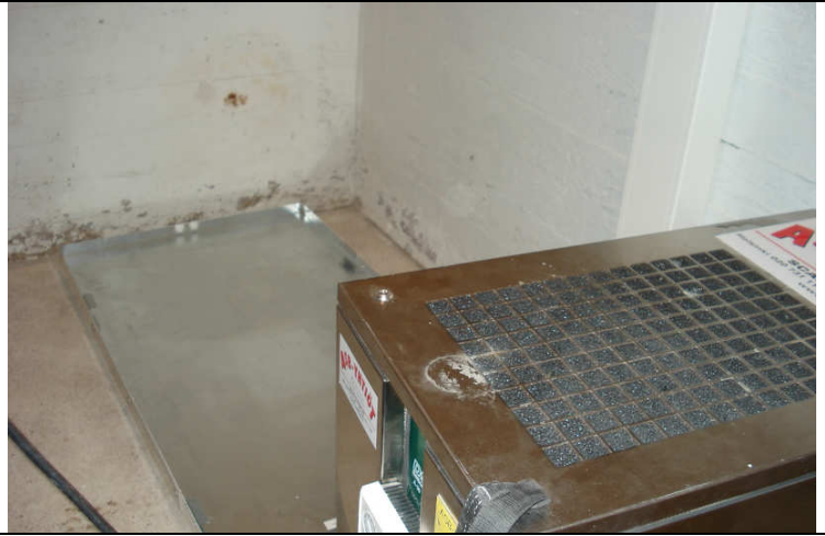
Kuva 2. Porrashuone C/ tila 059. Vinyyliilaatat poistettu. Liima ja tasoite jyrsitty. Kuivaus asennettu.
