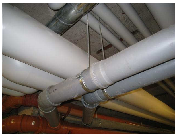
Kuva 8 Tässä kannakoinnit ovat n. 60 cm pitkät ja viemäri pääsee liikkumaan.
