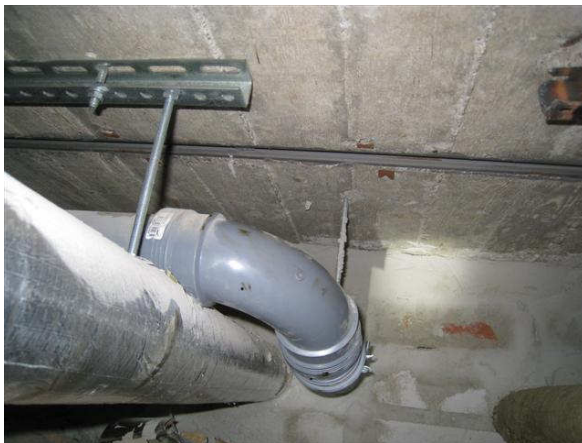
Kuva 15 Mutkakohdassa viemäriä samalla pudotetaan alemmas.
