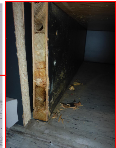
Kuvat 4 ja 5. Luokan 221 koulun aulan suuntaisen seinän kiintoalakaapiston välisokkelirakenne on alaosastaan kosteusvaurioitunut.
