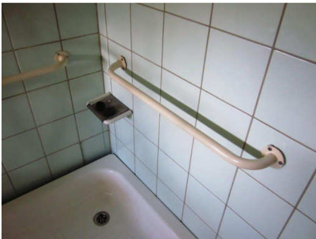
Kuva 15 Kiinnityskohtia ei ole tiivistetty.
