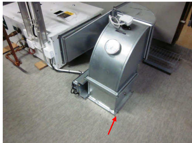
Kuva 24 Tiivistämättömiä porareikiä.
