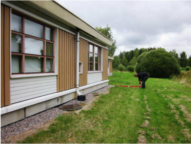
Kuva 3 Räystäskourut ovat koteloituna.
