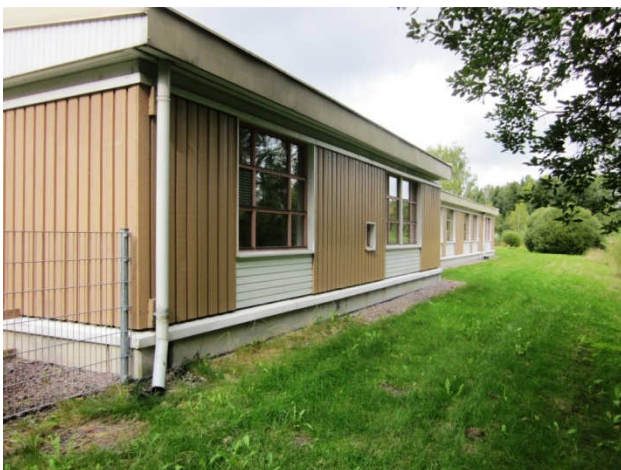
Kuva 1 Sokkelin vierellä sepeliä.
