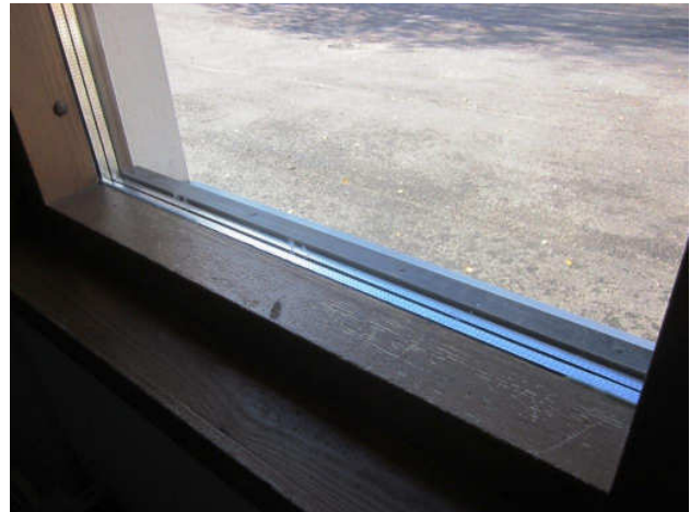
Kuva 10 Lasielementin ja karmien välinen silikonisaumausta irronnut.
