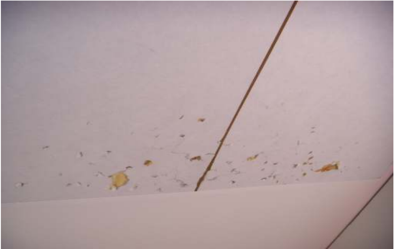
KUVA 15. Yleiskuva leikkihuoneen katosta.
