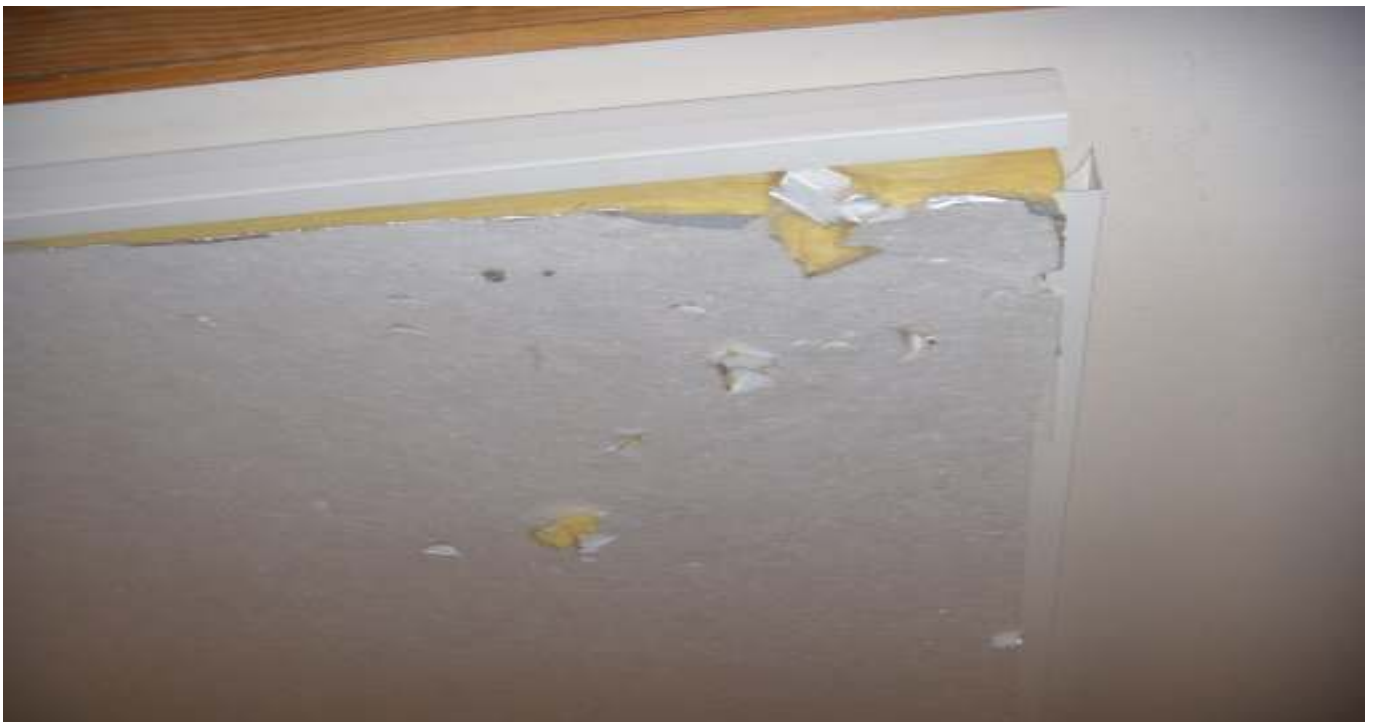
KUVA 14. Yleiskuva leikkihuoneen katosta.
