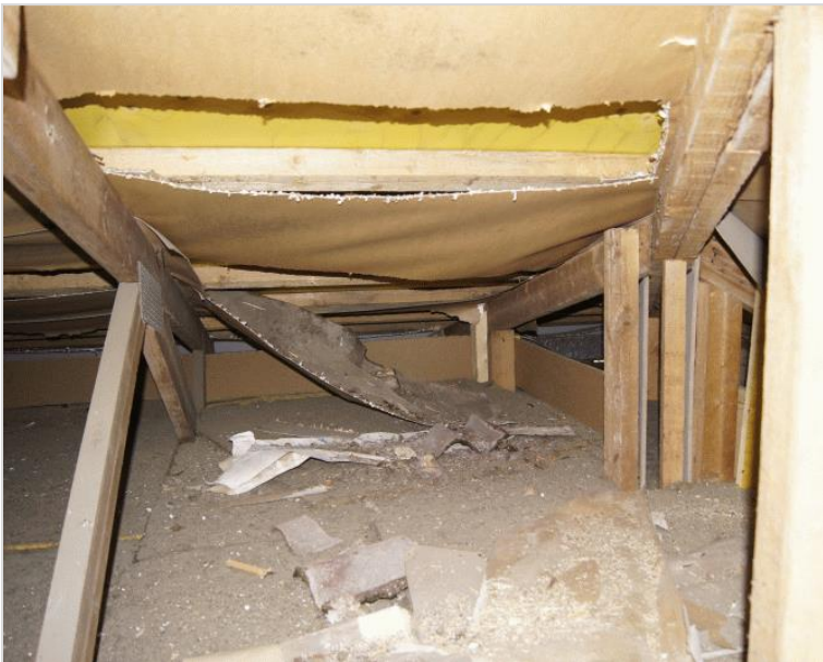
Kuvat 8,9,10. Ullakolla havaittiin rakennusjätettä. Ullakolla oli erittäin paljon pölyä.
