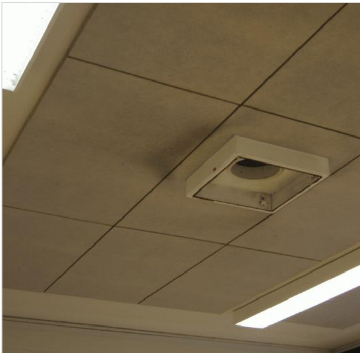
Kuvat 14,15. Opetustilan 161 tuloilmakanavasta otettiin pyyhintäpölynäyte (KP4). Luokkatilan katossa oli mineraalivillaa näkyvissä levyjen reunoissa.
