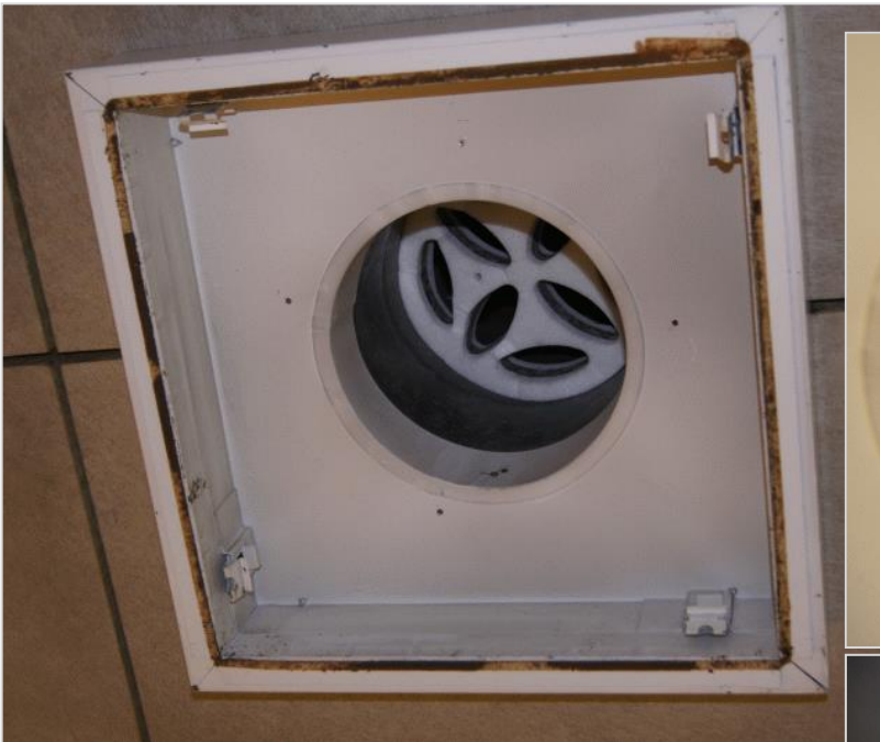
Kuvat 11,12,13. Opetustilan 117 tuloilmakanavasta otettiin pyyhintäpölynäyte (KP3). Kanavan luukussa havaittiin epäpuhtauksia.
