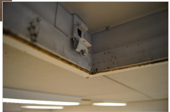
Kuvat 11,12,13. Opetustilan 117 tuloilmakanavasta otettiin pyyhintäpölynäyte (KP3). Kanavan luukussa havaittiin epäpuhtauksia.
