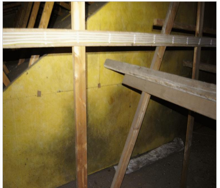
Kuvat 8,9,10. Ullakolla havaittiin rakennusjätettä. Ullakolla oli erittäin paljon pölyä.
