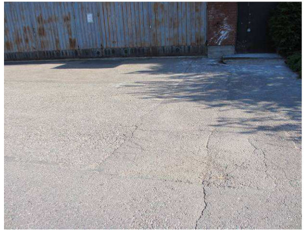
Asfalttoinnin kunto pääasiallisesti tyydyttävä
