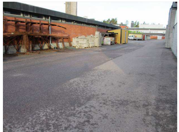
Pinnankallistukset viettävät pois päin rakennuksista.
