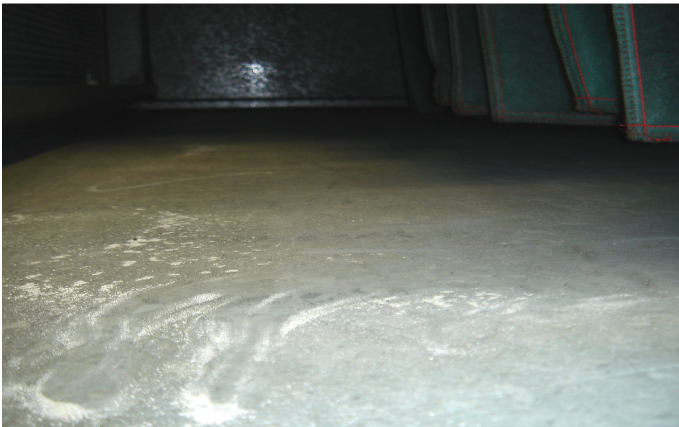
KUVA 5. Yleiskuvat koneen TK/PK 4 kammiosta.
