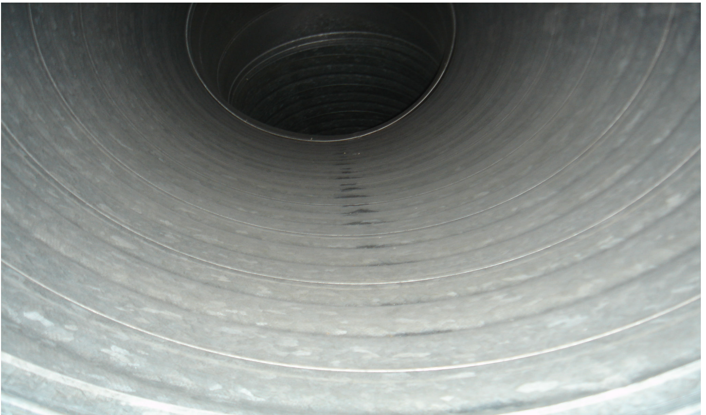
KUVA 4. Yleiskuva poistoilmakanavasta.
