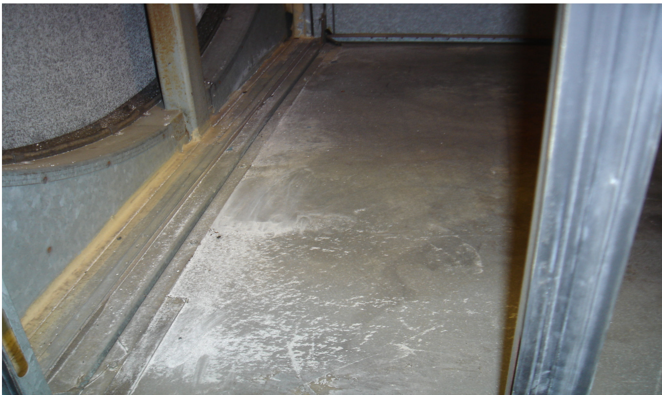
KUVA 6. Yleiskuvat koneen TK/PK 4 kammiosta.
