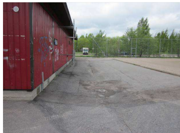
Kuvaa rakennuksen takapuolelta, kallistukset ovat riittäviä ja sadevedet poistuvat kaivoon
