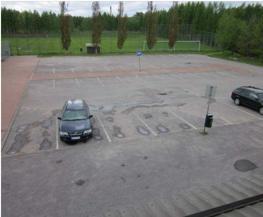
Kuva paikoitusalueelta, asfaltti on vielä tyydyttävässä kunnossa
