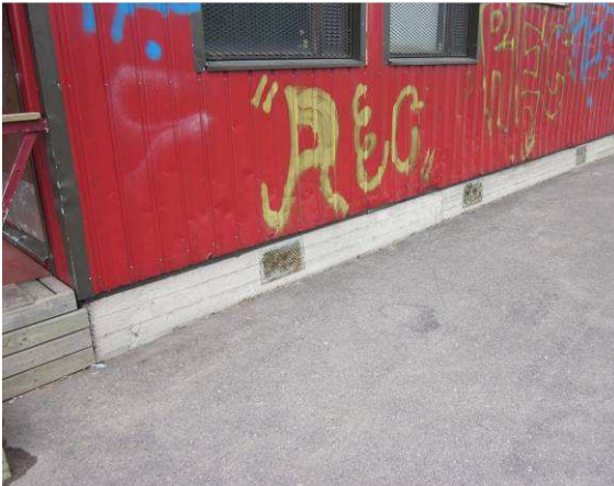
Kohteessa on tuulettuva alapohjarakenne
