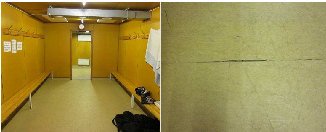
Yleiskuvaa pukuhuonetilasta, yleisilme siisti
