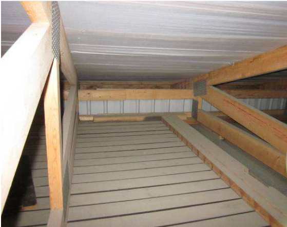
Yläpohjatilassa ei havaittu vuotojälkiä
