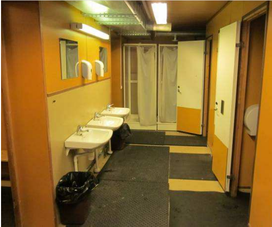
Yleiskuvaa Wc- ja suihkutilasta
