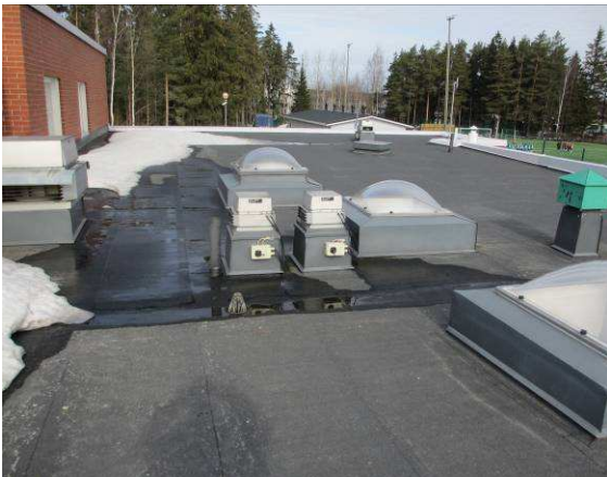
Katekermeissä ei havaittu merkittäviä puutteita
