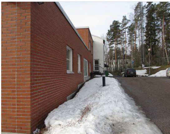
Muuratuissa julkisivuissa ei havaittu viitteitä vaurioista
