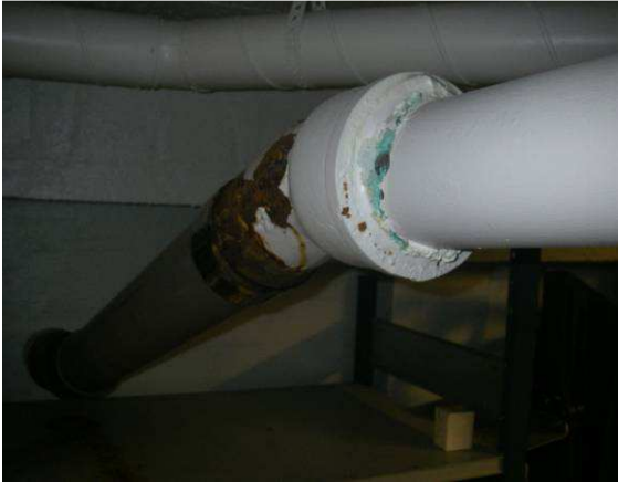
Uusi viemäriosuus yhdistyy vanhaan valurauta-putkeen.
