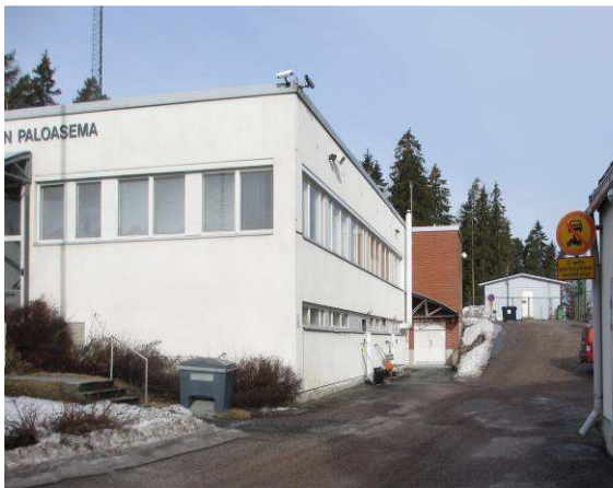
Vanhan osan julkisivut on rapattu 1995 tehdyn korjauksen yhteydessä
