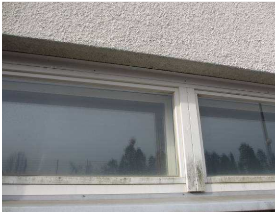
Kohteen ikkunat ovat pääasiallisesti puualumiini-ikkunoita
