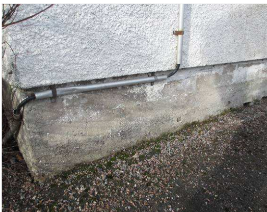
Vanhan osan sokkeli on tehty vaakalautamuotilla
