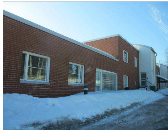
Muuratuissa julkisivuissa ei havaittu viitteitä vaurioista
