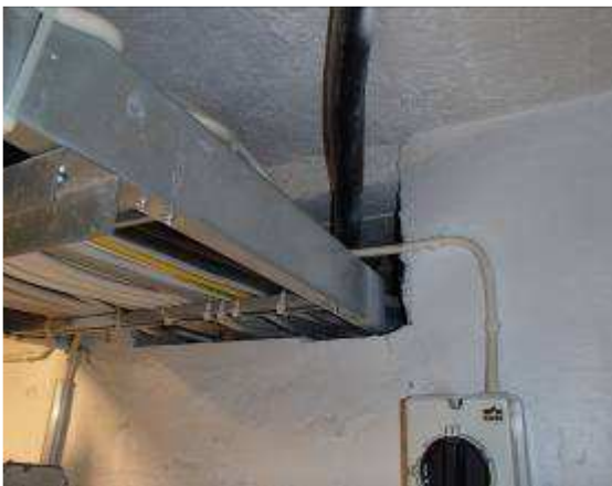
Avonainen läpivienti kellaritiloissa.
