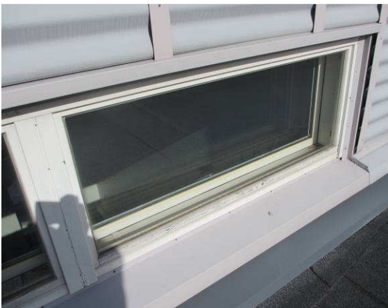
Vesikattotasolla puupinnalla olevia ikkunoita
