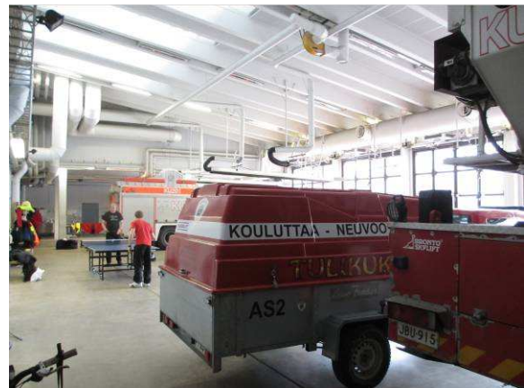
Kantavissa betonirakenteissa ei havaittu viitteitä vaurioista
