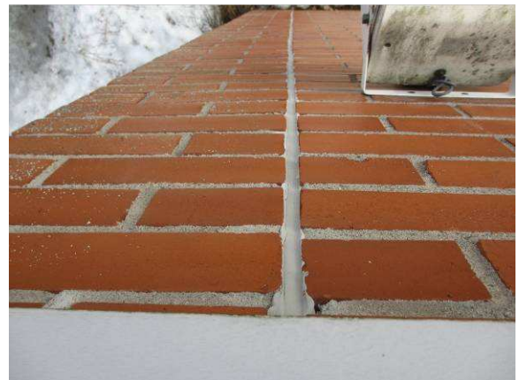
Liikuntasaumakitit tulevat uusimisikään jakson aikana
