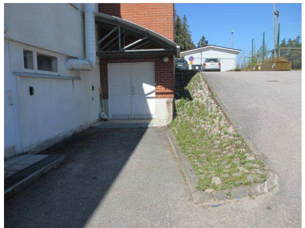
Ylärinteen kivetetty kaista-alue kallistaa rakennuksen suuntaan, muilta osin kallistukset ovat tyydyttäviä
