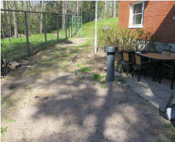
Kuvaa rinteessä ylöspäin, hiekka-alueen sadevesikaivon ympärillä ei ole kivetystä
