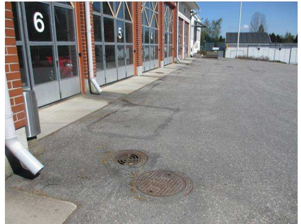
Rakennuksen edustan betonilaatat on varustettu lämmityksillä, kattovedet ohjautuvat asfalttialueen kaivoihin
