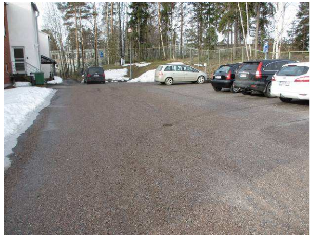
Paikoitusalueen vedenpoisto on toimiva, kaadot keskellä olevaan kaivoon
