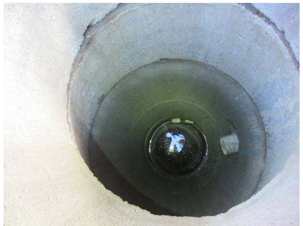
Kuvaa viereisessä kuvassa näkyvästä salaojakaivosta, alimmaisena rakennuksen alle lähtevät salaojalinjat, vedenpinta putkien alla
