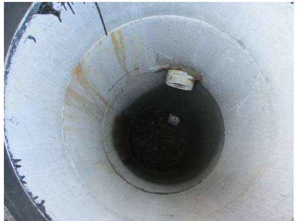
Kuvaa pohjoisnurkan salaojakaivosta, linjat kahdessa korossa, alin noin 2,5m sokkelin yläpinnasta, pohjalla ei vettä
