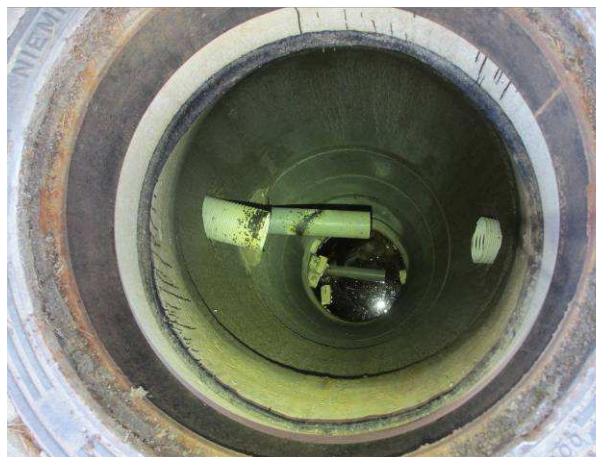
Kuvaa salaojakaivosta jossa ilmeisesti linjojen purkuputki, alin putki osin veden peitossa, salaojat ja sadevedet samassa järjestelmässä
