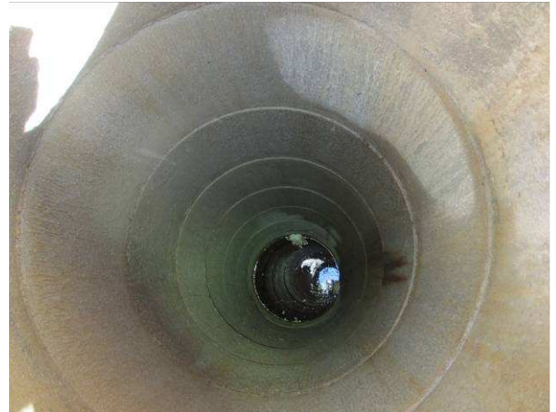
Kuvaa länsinurkan salaojakaivosta, putket noin 4,6m sokkelin yläpinnasta
