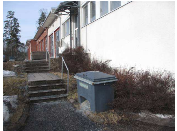
Länsinurkalla humusmaata ja kasvillisuutta sokkelin vierustalla, portaissa kunnostustarvetta
