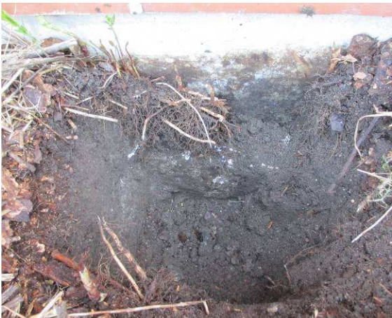
Sokkelin vierustalla humusmaata, kaivettaessa esiin tuli pystystyrox, jonka takana bitumisively
