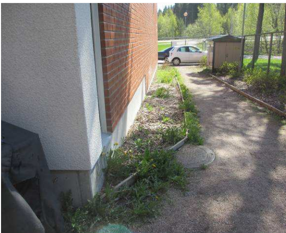
Yleiskuvaa lounaissivulta, sokkelin vierustalla humusmaata, kallistukset kohtuullisia
