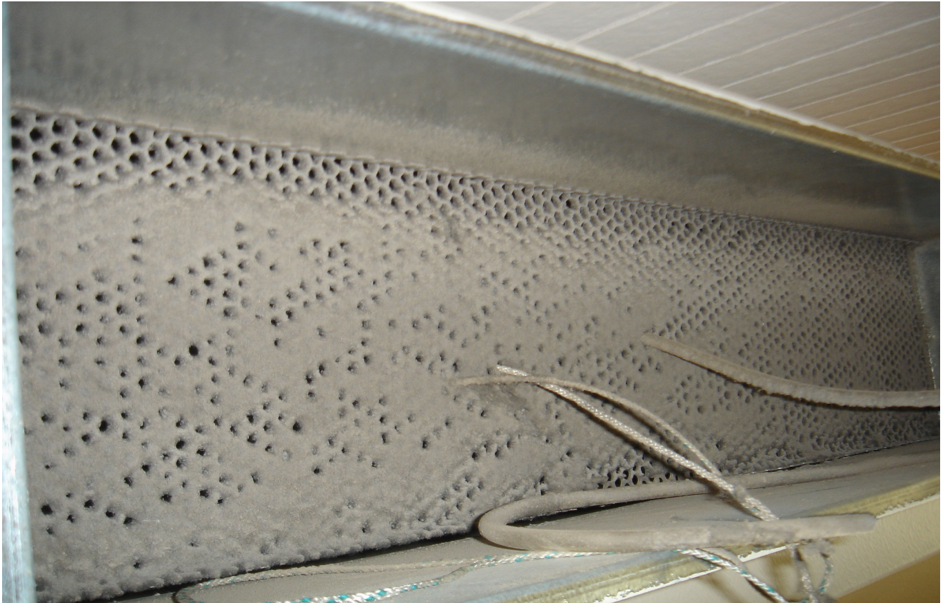
KUVA 61. Yleiskuva poistoilmaritilän alla olevasta reikälevystä.
