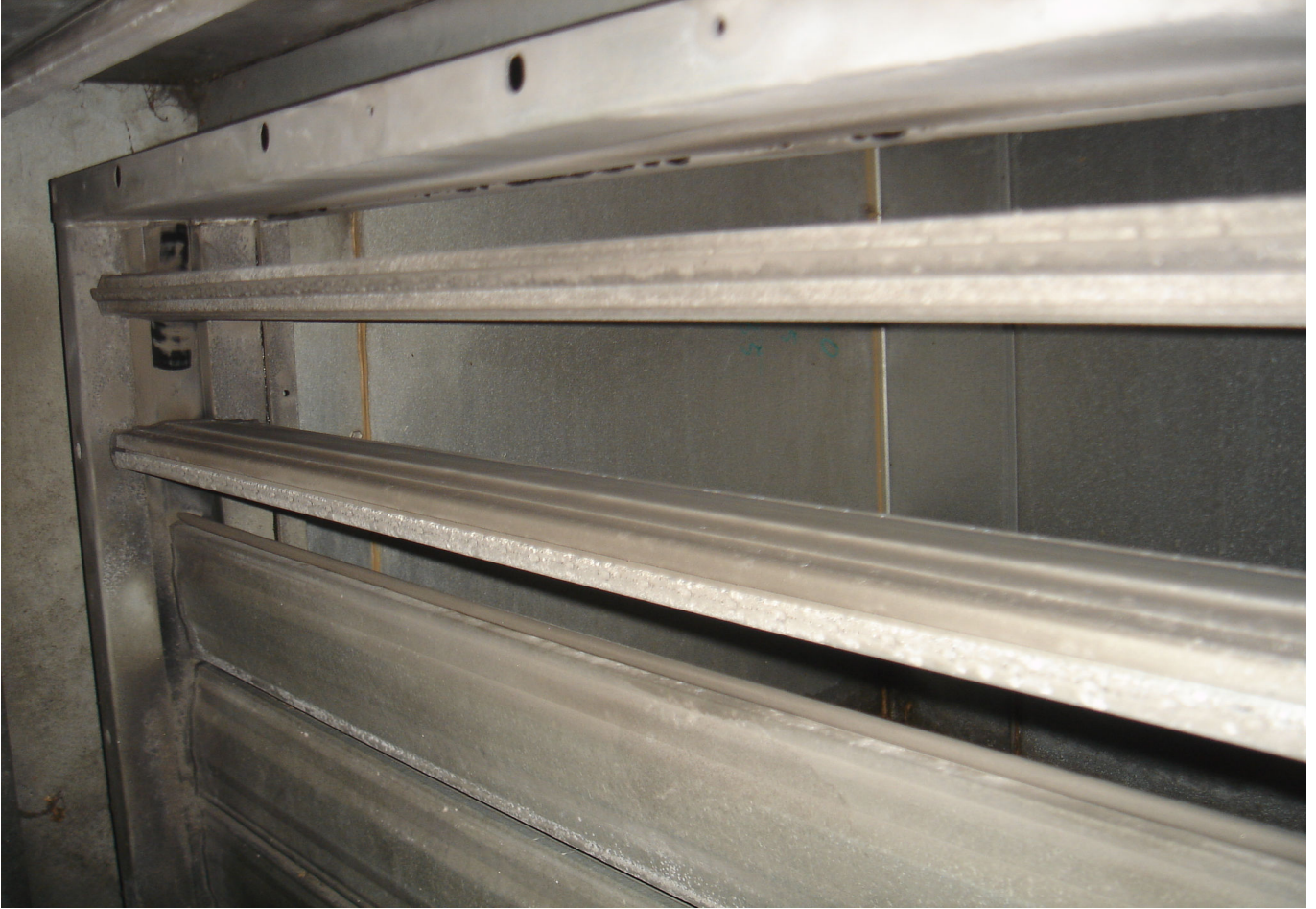
KUVA 53. Yleiskuva räitisilmäpellistä 15TK1.
