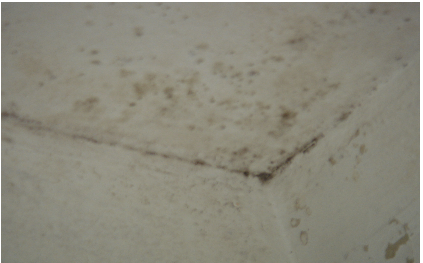
KUVA 64. Yleiskuva huoltomiehen WC- tiloista.
