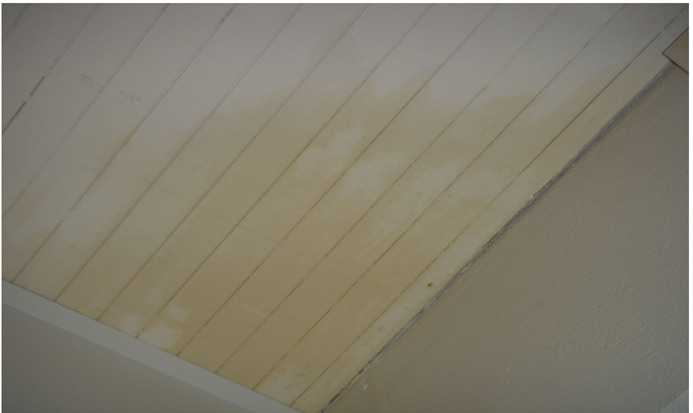
KUVA 66. Yleiskuva luokkahuoneen n:o 206 katosta.
