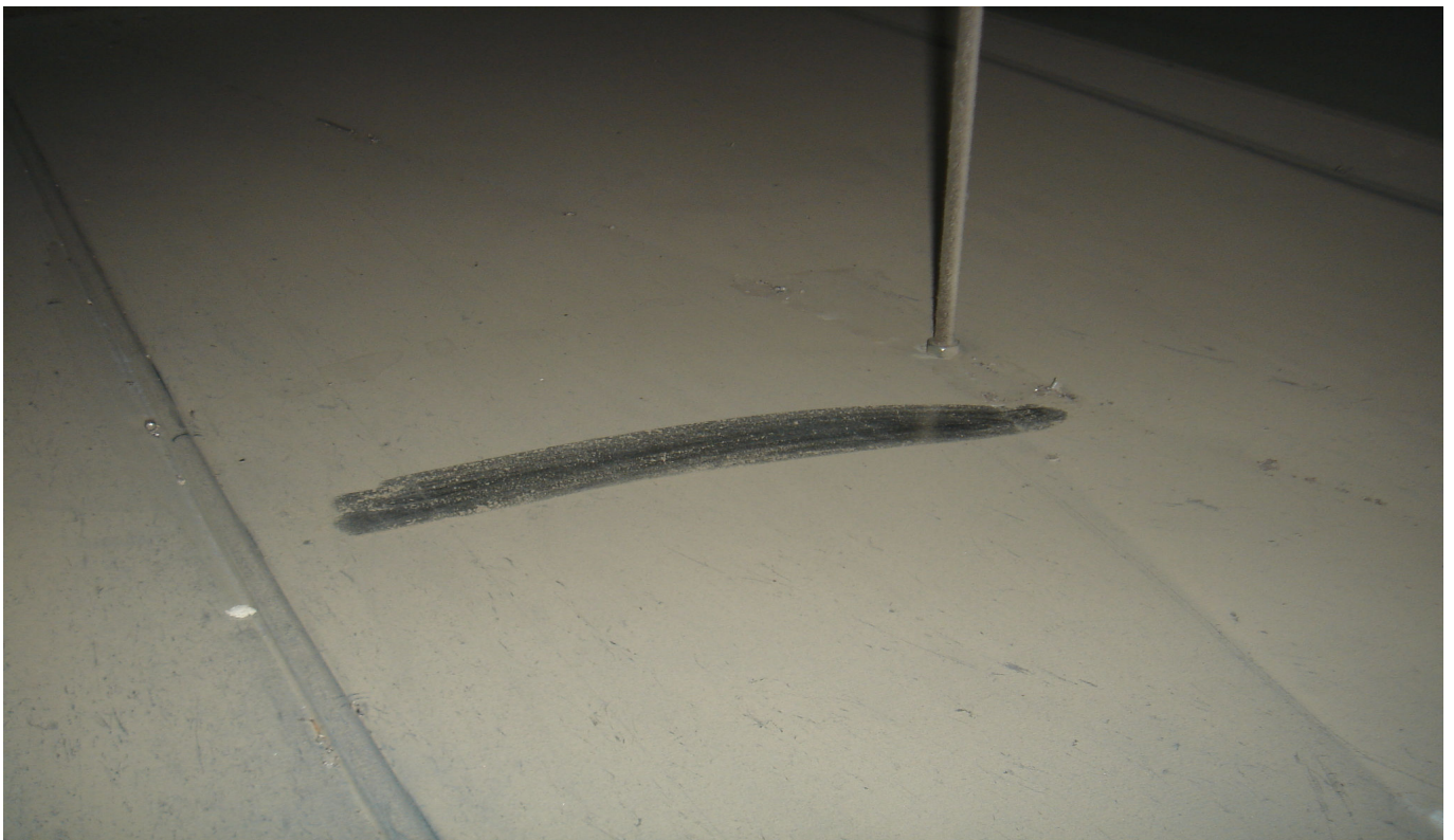
KUVA 20. Yleiskuva poistoilmakammioista TK05, PF1.
