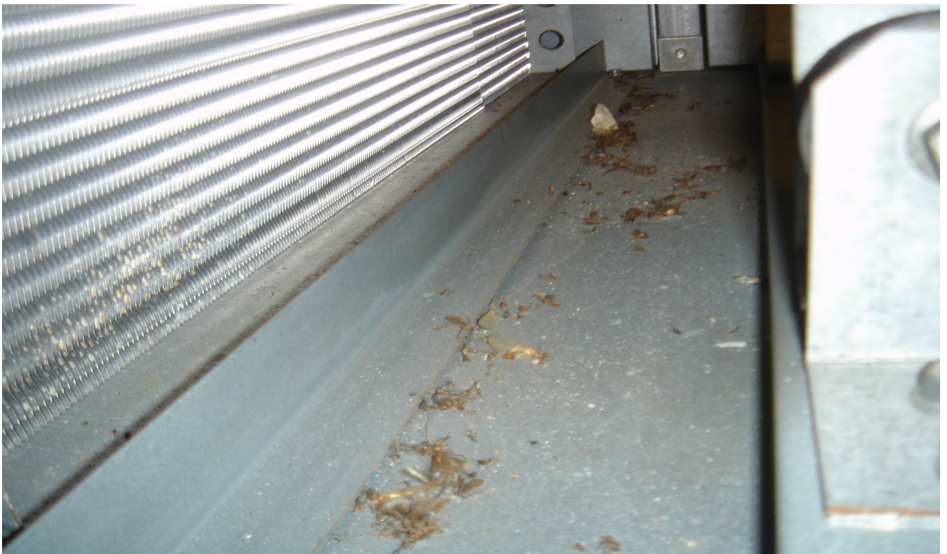
KUVA 26. Yleiskuva tuloilmakammioista 11TK1.
