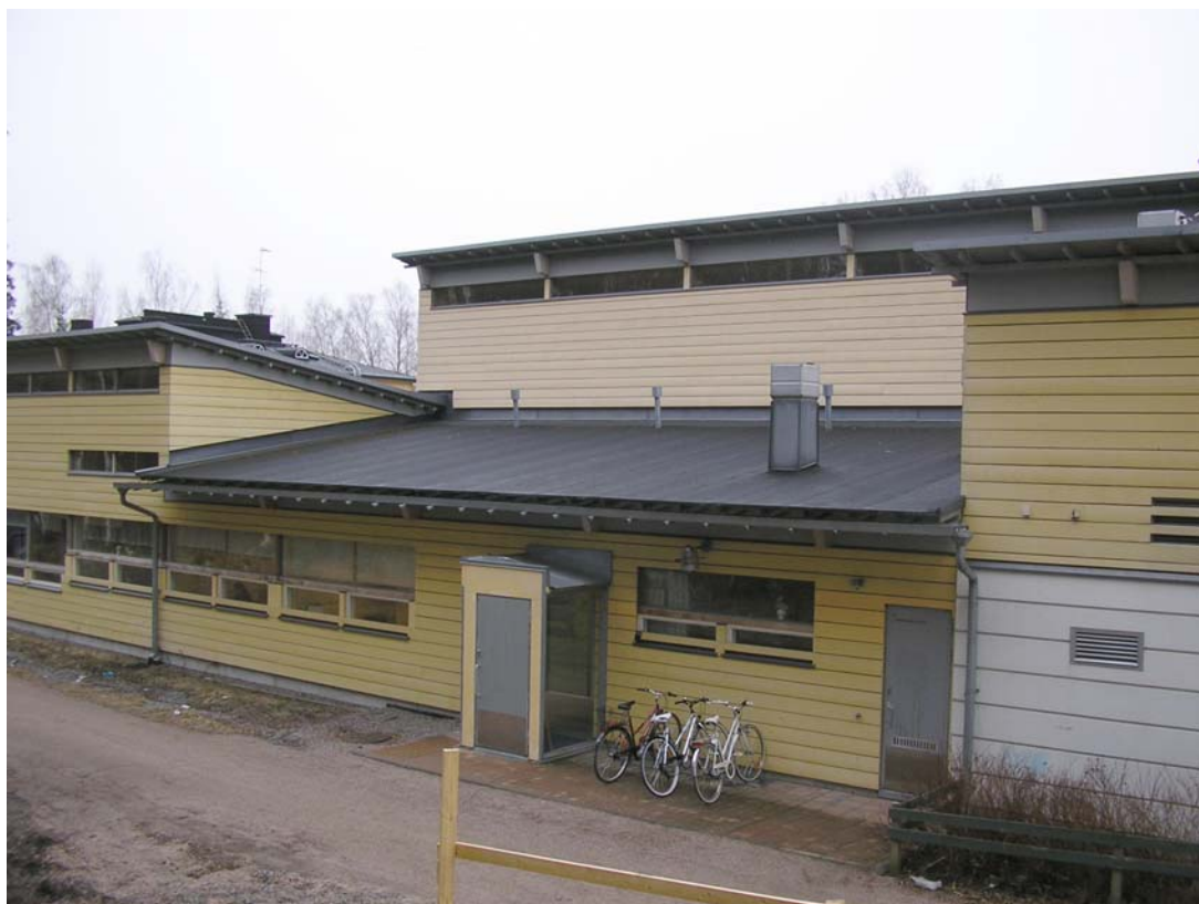
Kuva 2 Itäisivun julkisivu, jossa oikealla on väestönsuojan seinää.
