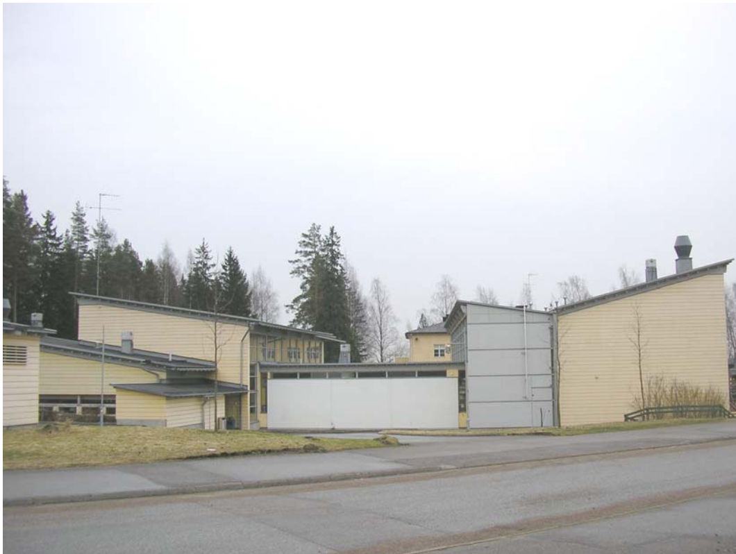
Kuva 1 Pohjoispääty, jossa keittiö ja päiväkoti vasemmalla ja koulusiipi oikealla.
