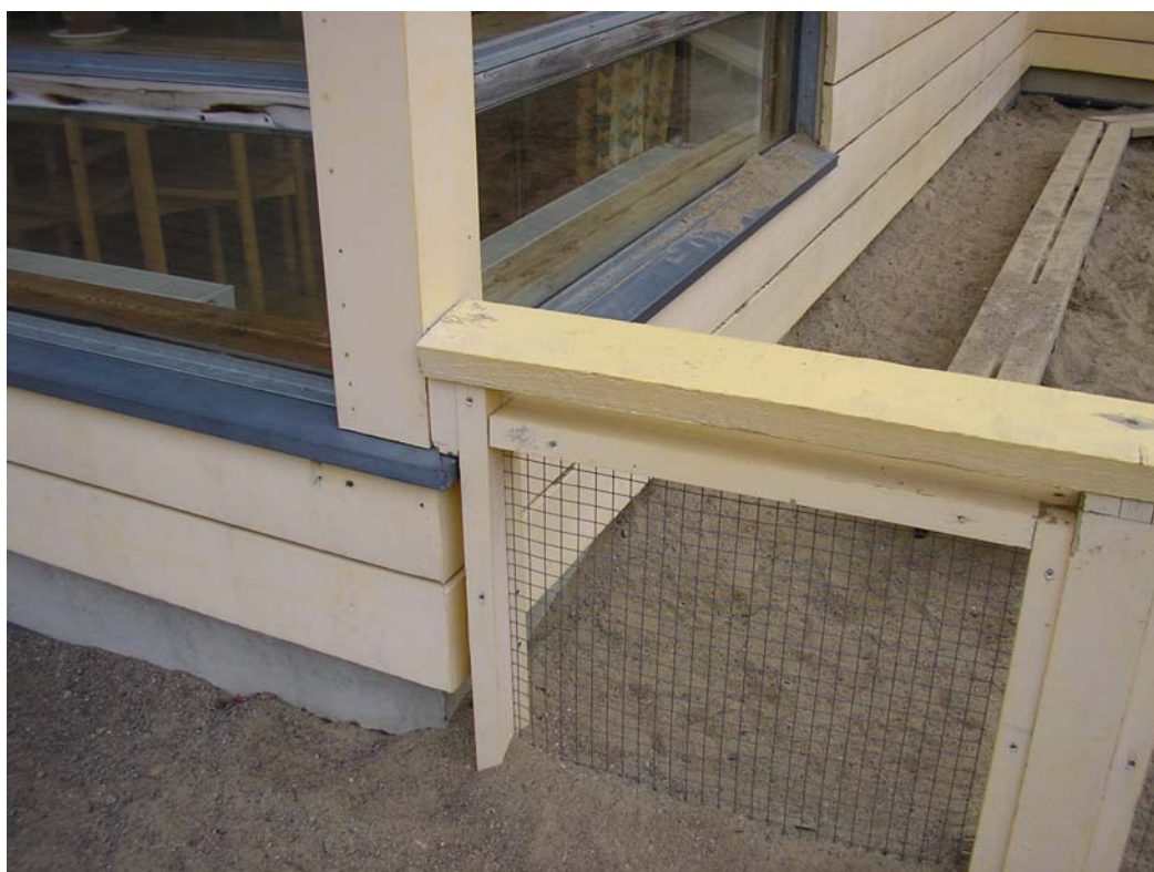
Kuva 20 Päiväkodin leikkiuhan aita liittyy huonosti ulkoseinään.
