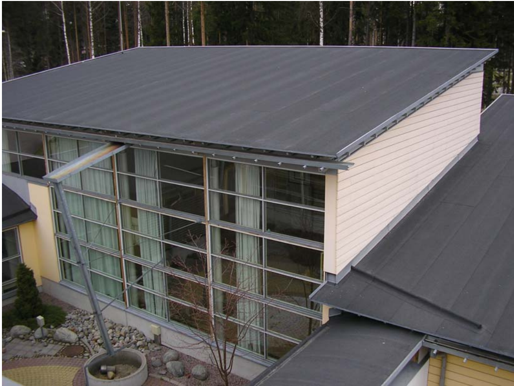
Kuva 3 Monitoimisalin ulkoseinä nousee vesikaton yläpuolelle. Länsisivu on lasiseinä.
