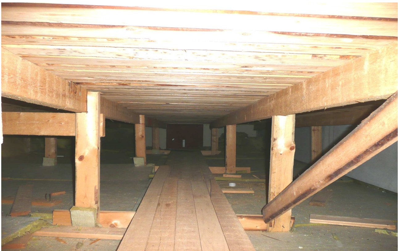
RAK- kuva 10. Vesikaton kantavana rakenteena toimii puisista niskalankuista tehty puurunko.
