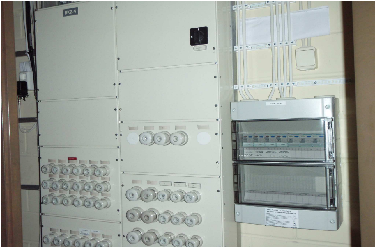
S-kuva 8. Opetustiloja palveleva keskus, keskuksen viereen on lisätty vikavirtasuojakyt- kimet.
