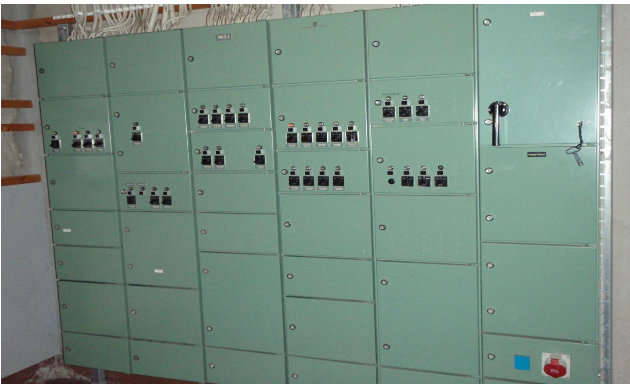
S- kuva11. IV- laitteistoja palveleva keskus.
