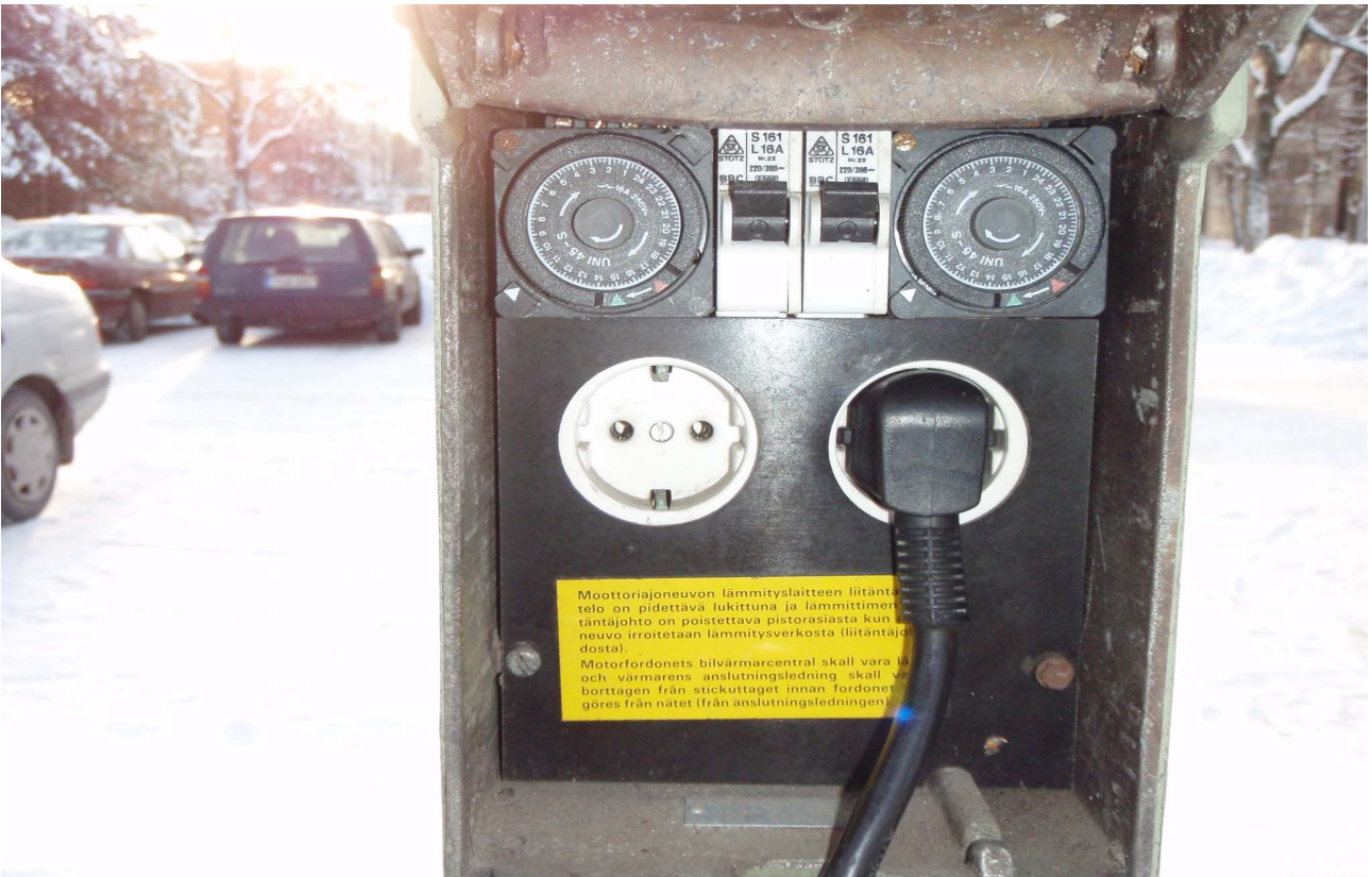
S-kuva 3. Autolämmityspistorasiakotelo.
