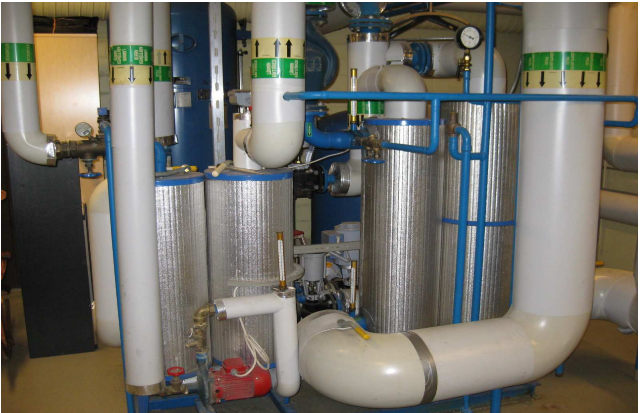
LVI- kuva 1. Yleiskuva lämmönjakohuoneesta.
