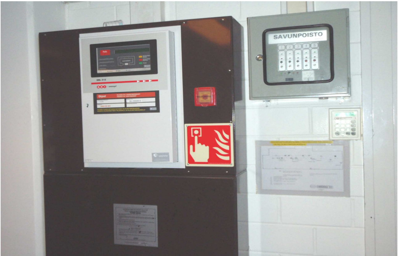
S-kuva 24. Paloilmoitinjärjestelmän keskus.
