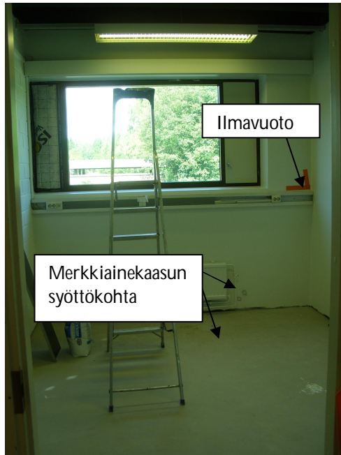
Kuva 1 (vasen). Huonetila 182 . Tiivistystyön jälkeen luokkahuoneessa havaittiin vain yksi (kuvaan merkitty) ilmavuotokohta.
