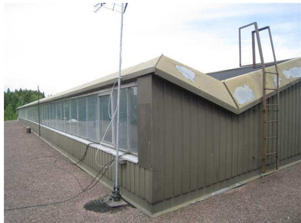
Kuva 52 Keskialueen kattolyhty, jonka vesikatteenä on musta pintahuopa.
