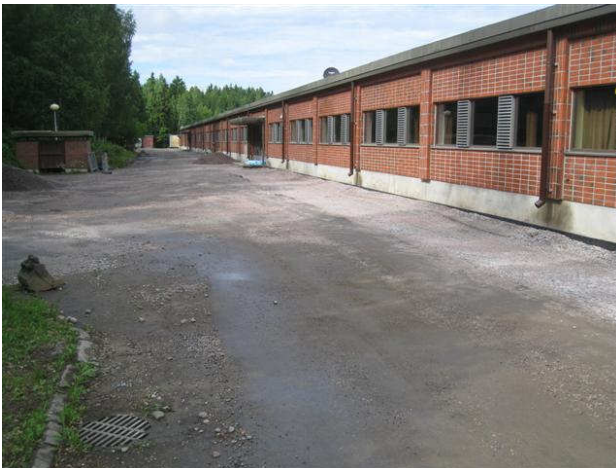
Kuva 33 Työpajarakennuksen länsisivulla on tehty pintakallistuskorjauksia ja uusittu salaojat.
