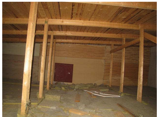
Kuva 48 Eteläosan yläpohjaontelossa ei havaittu vuotojälkiä, perällä kulkuluukku.
