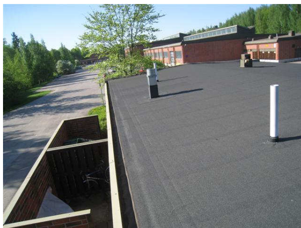
Kuva 71 Vesikaton rännit ovat räystäään sisällä.
