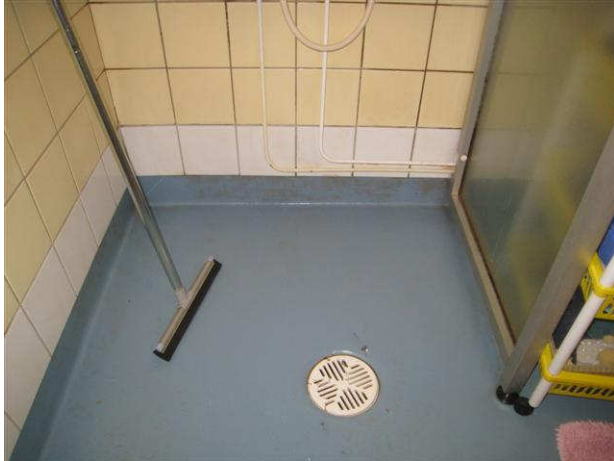
Kuva 73 B-asunnossa lattiamatto ja lattiakäivon on uusittu ja alimmat seinälaatat.
