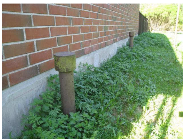
Kuva 66 Alustatilan tuuletusputket pohjoispäädyssä, maanpinta on tasainen. Sokkelit ovat nk. valesokkelit.
