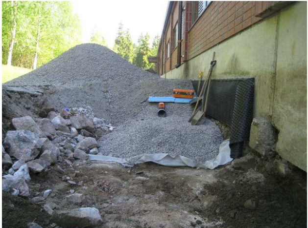
Kuva 36 Länsisivun uusi salaoja, sepelitäytöt, routasuojaus ja sokkelilevy.
