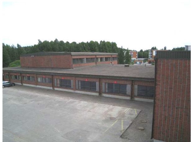
Kuva 14 Yleiskuva koulun ja ruokala-liikuntasalin vesikatoille, katteet ovat alkuperäisiä.
