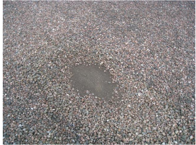
Kuva 44 Singelikerroksen alla on tyydyttävässä kunnossa oleva bitumikermikate.
