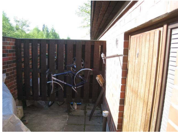
Kuva 68 Sisäänkäynnin viereiset suojatilat ovat sään armoilla, koska ei ole kattoa.
