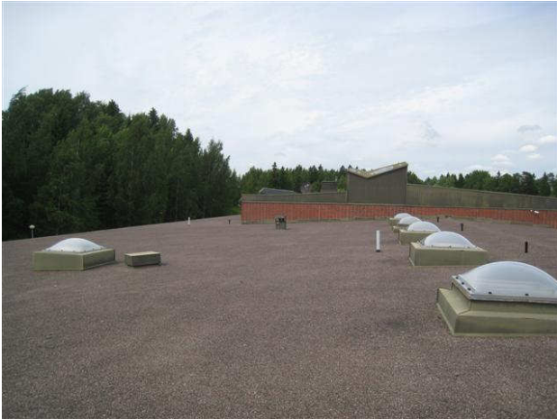
Kuva 43 Yleiskuva Työpajarakennuksen eteläosan vesikatolta.
