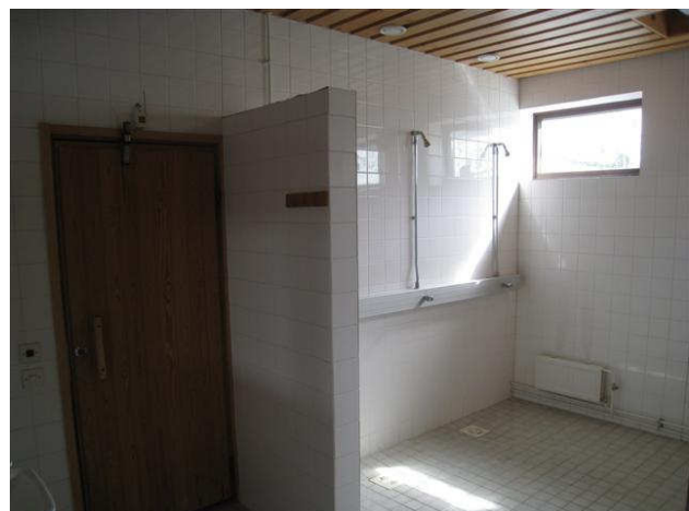
Kuva 24 Liikuntasalin suihkutila 201, lattioissa on laatat.
