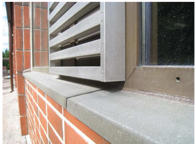
Kuva 42 Työpajarakennuksen kiinteä 1. krs:n muovikarmi-ikkuna.
