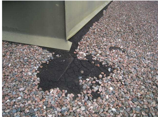
Kuva 50 Siirtynyt singeli ja sen takia halkeillut pintakermi.
