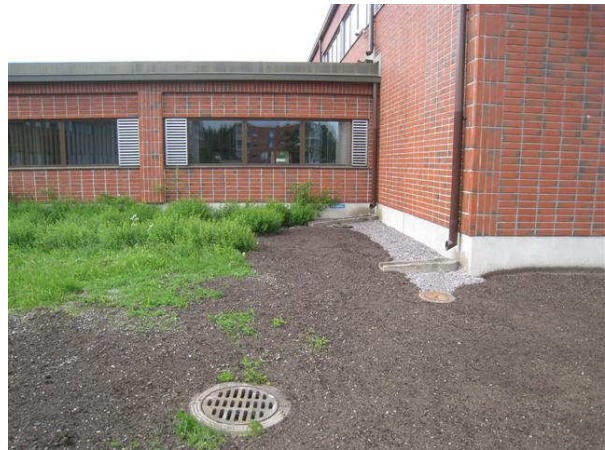
Kuva 4 Pintakallistuskorjaukset on tehty liikun- tasalin kulmalla. Rännivedet jäävät 1 m päähän sokkelista.
