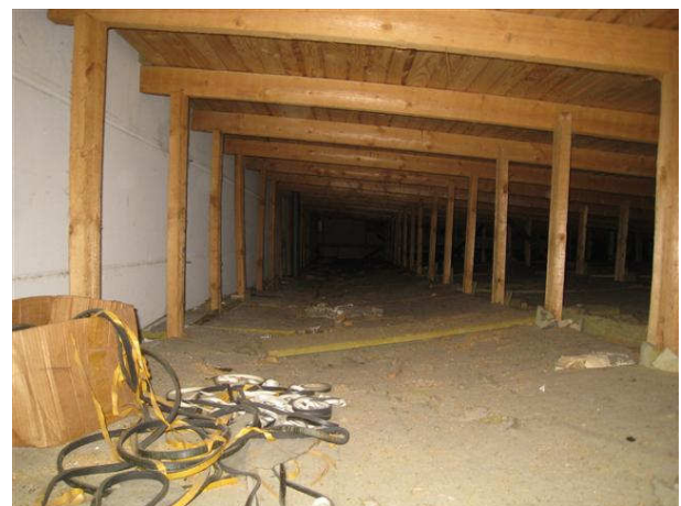
Kuva 54 Yläpohjaonteloa työsali 081 yläpuolella kattolyhtylinjan vieressä.
