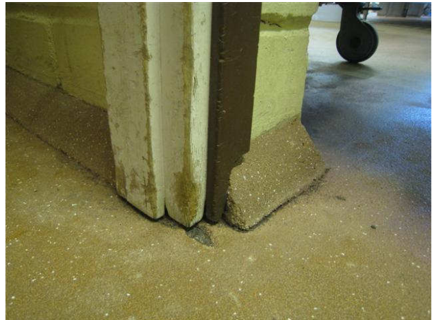
Kuva 20 Holkkalista on irti, pinnoite on rikki, ovikarmi on kulunut.
