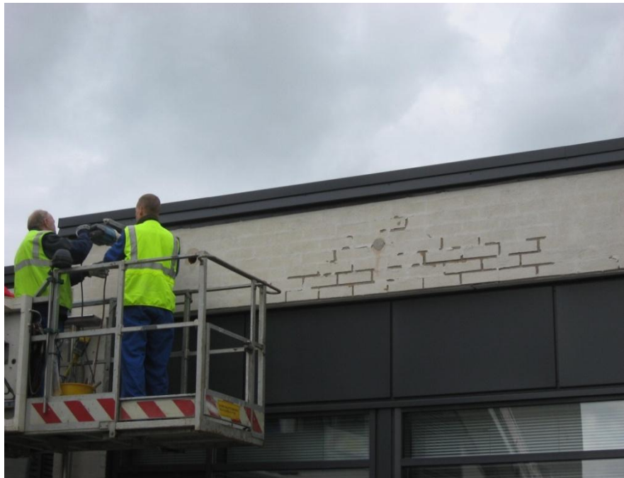
Kuva 2. Näytteenotto kohta T6 (vaurioituneen alueen vieressä oleva silmämääräisesti tarkastellen ehjä kohta) hammashoitolan yläpuolella.
