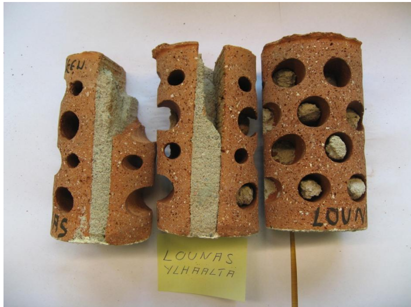
Kuva 8. Lounaaseen avautuvasta julkisivun yläosasta poraamalla irrotetut näytteet. Näytteet on irrotettu ehjästä kohdasta läheltä vaurioitunutta kohtaa. Vasemman puoleinen näyte asetettiin jäädytys - sulatuskäsittelyyn, keskimmäisestä näytteestä tehtiin ohuthie ja laastianalyysi. Oikeanpuoleisesta näytteestä tehtiin ohuthie ja määritettiin laastin vetolujuus.
