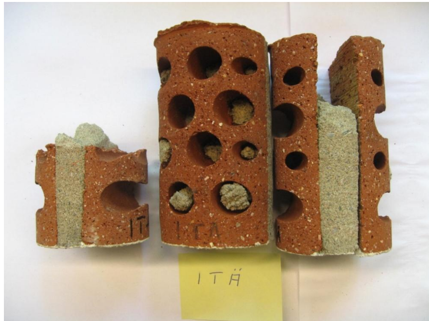
Kuva 6. Itään avautuvasta julkisivusta (ehjä alue) poraamalla irrotetut näytteet. Vasemman puoleinen näyte asetettiin jäädytys - sulatuskäsittelyyn, keskimmäisestä näytteestä tehtiin kaksi ohuthiettä ja laastianalyysi. Oikeanpuoleisen näytteen laastista määritettiin laastin vetolujuus.
