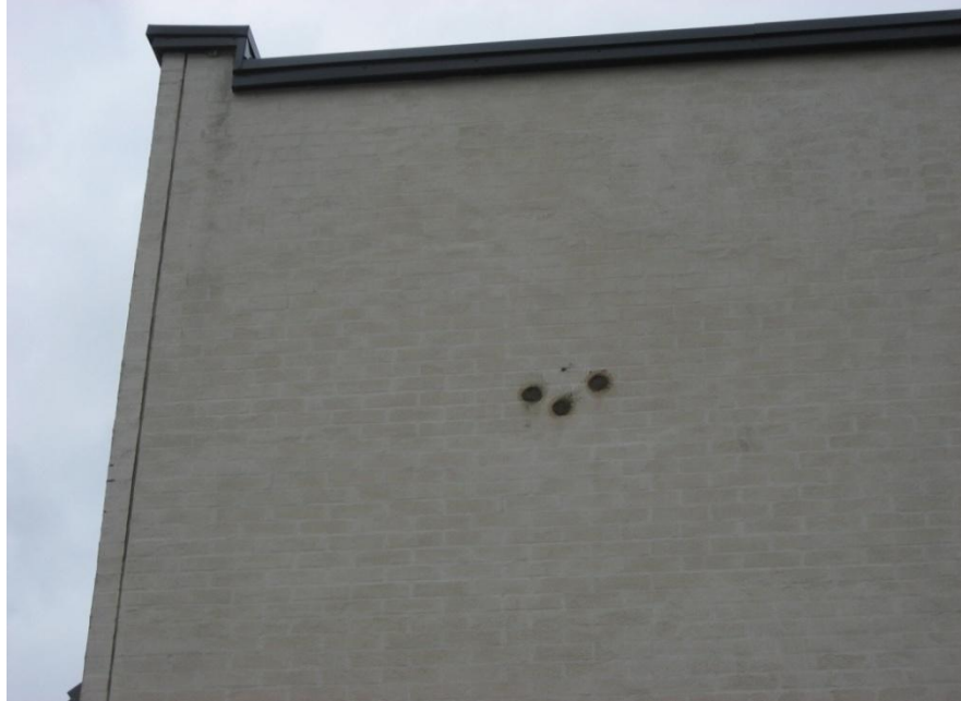
Kuva 1. Näytteenotto kohta T5 (päällepäin ehjä alue) pääsisäänkäynnin oikealla puolella olevan seinän yläosa.
