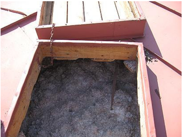
Kuva 6 Lisälämmöneristeenä puhallusvillaa.
