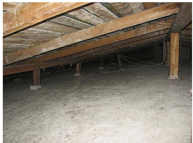
Kuva 12 Yläpohjatilassa ei havaittu valumaveden aiheuttamia jälkiä.
