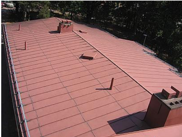
Kuva 1 1-kerroksisen rakennusosan vesikattoa.
