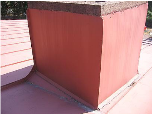
Kuva 5 Hormien kohdilla vesikaadoissa ei havaittu puutteita.
