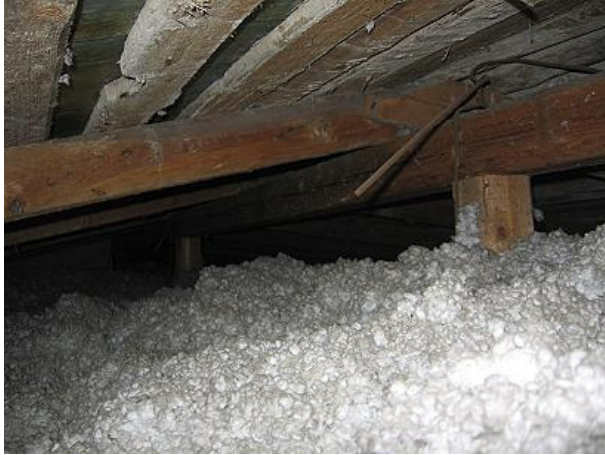
Kuva 7 Puurakenteissa ei havaittu valumaveden aiheuttamia jälkiä.
