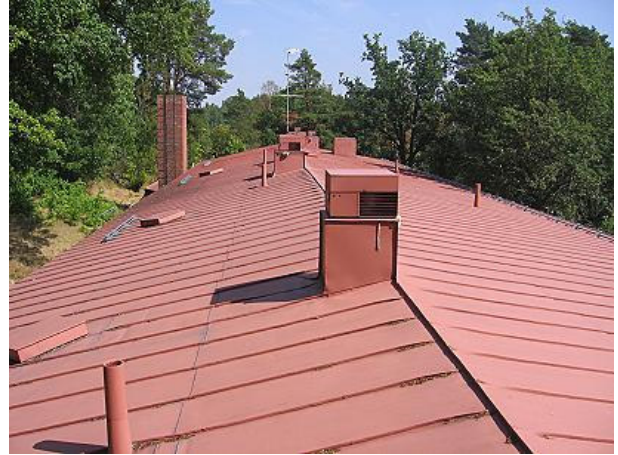
Kuva 8 2-kerroksisen rakennusosan vesikattoa.
