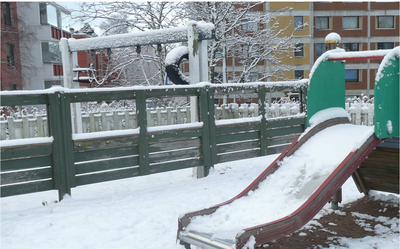
RAK- kuva 2. Aidan maalipinnassa esiintyy erittäin voimakasta kulumaa.
