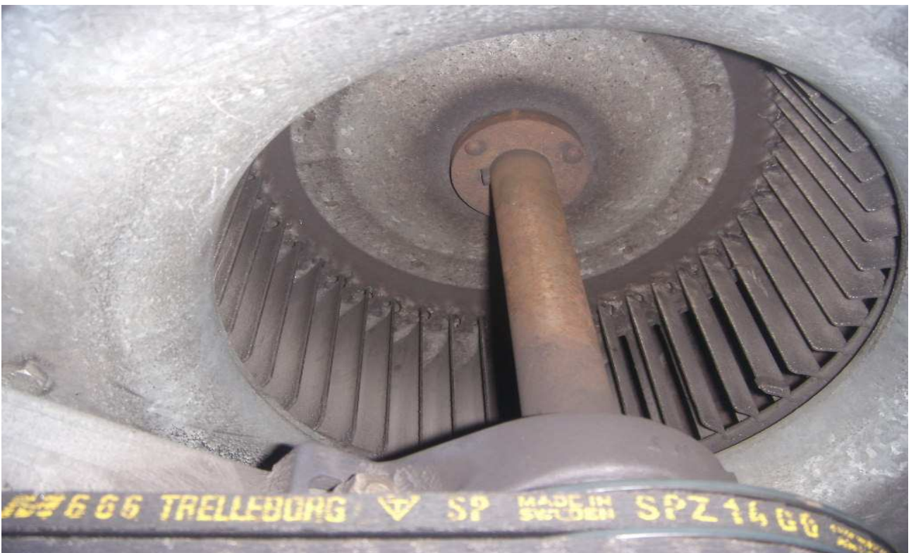
LVI- kuva 12. Poistoilmapuhallin on pölyinen.
