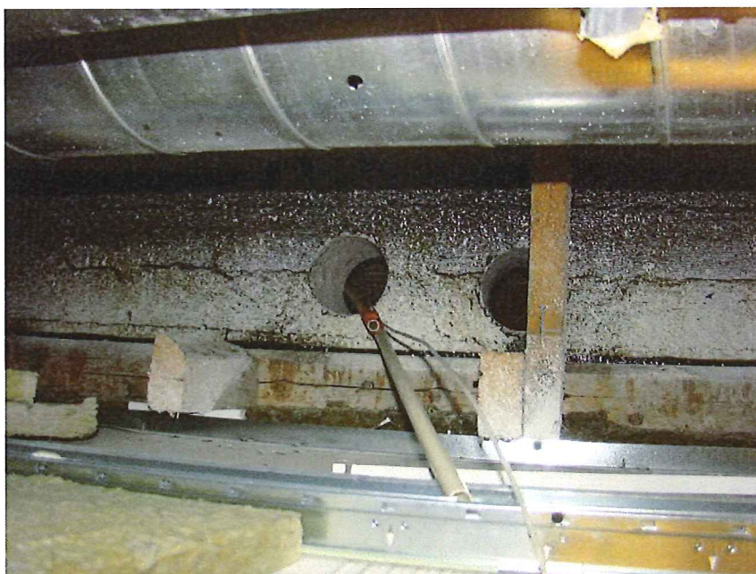
Kuva 1. Läpivienti käytävällä 180, alaslasketun katon yläpuolella
