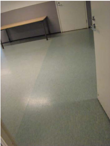
Kuva 4. Vesivahingon korjausraja.
