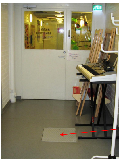
Kuva 3. Käytävällä sijaitseva tarkastuskaivo. Oikeanpuoleisessa kuvassa luukku avattuna.
