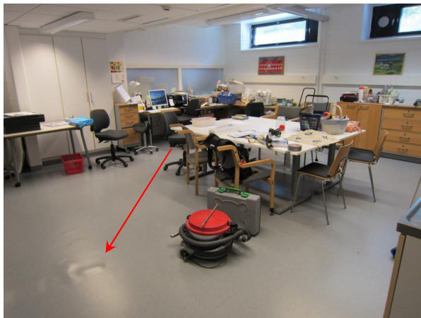
Kuva 2. Kupruja muovimatossa askarteluhuoneessa 017.
