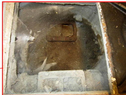
Kuva 3. Käytävällä sijaitseva tarkastuskaivo. Oikeanpuoleisessa kuvassa luukku avattuna.
