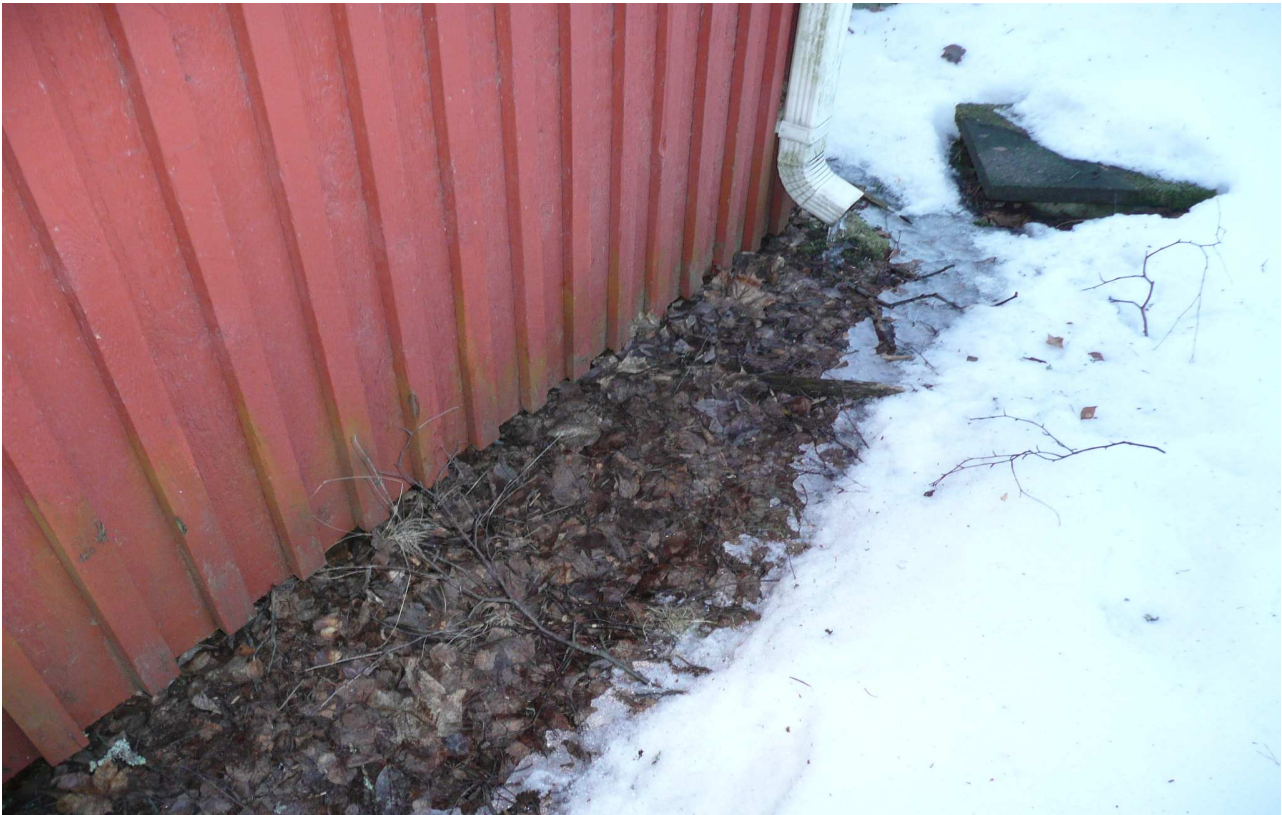
R-kuva 1. Kadun puolen maanpinta on sokkeliin nähden liian korkea.
