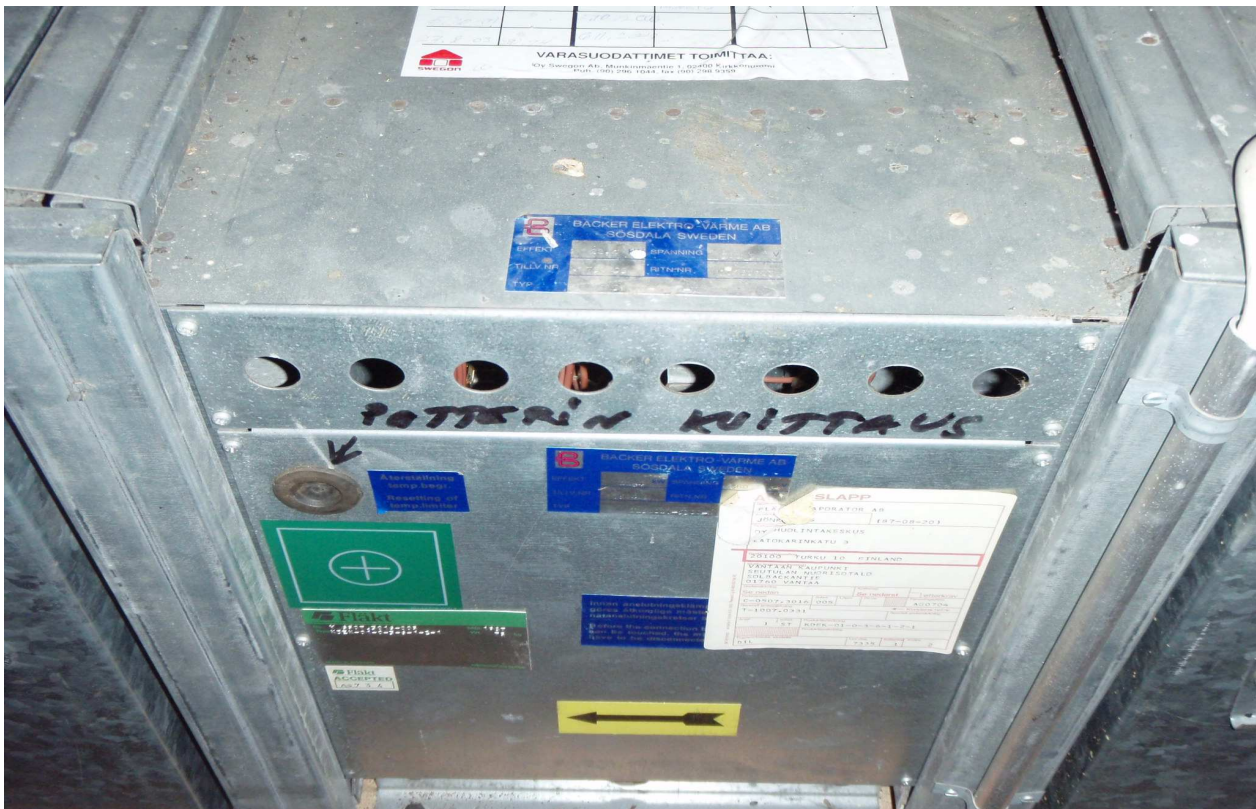
S-kuva 12. IV- koneikon lämmitysyksikkö.
