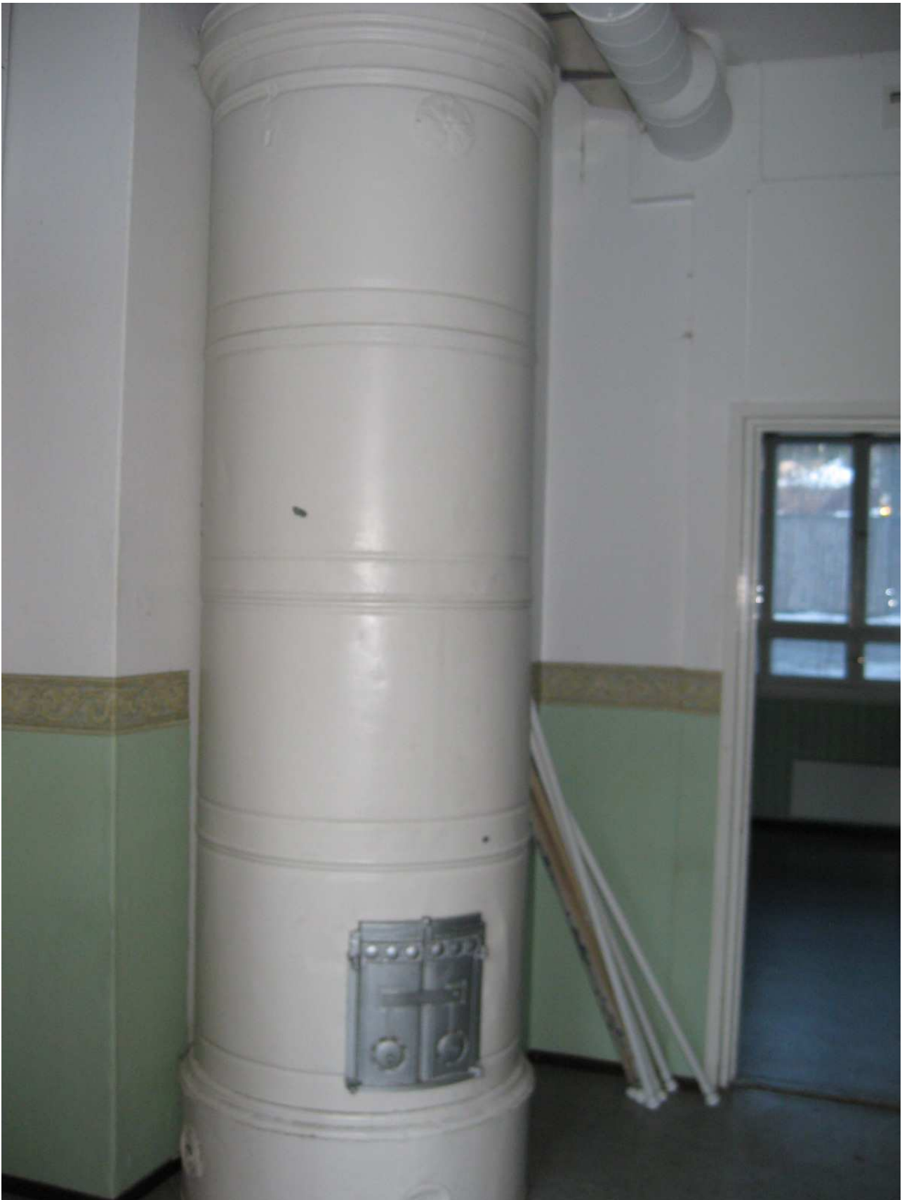
LVI-kuva 1. Yleiskuva pystyuunista.
