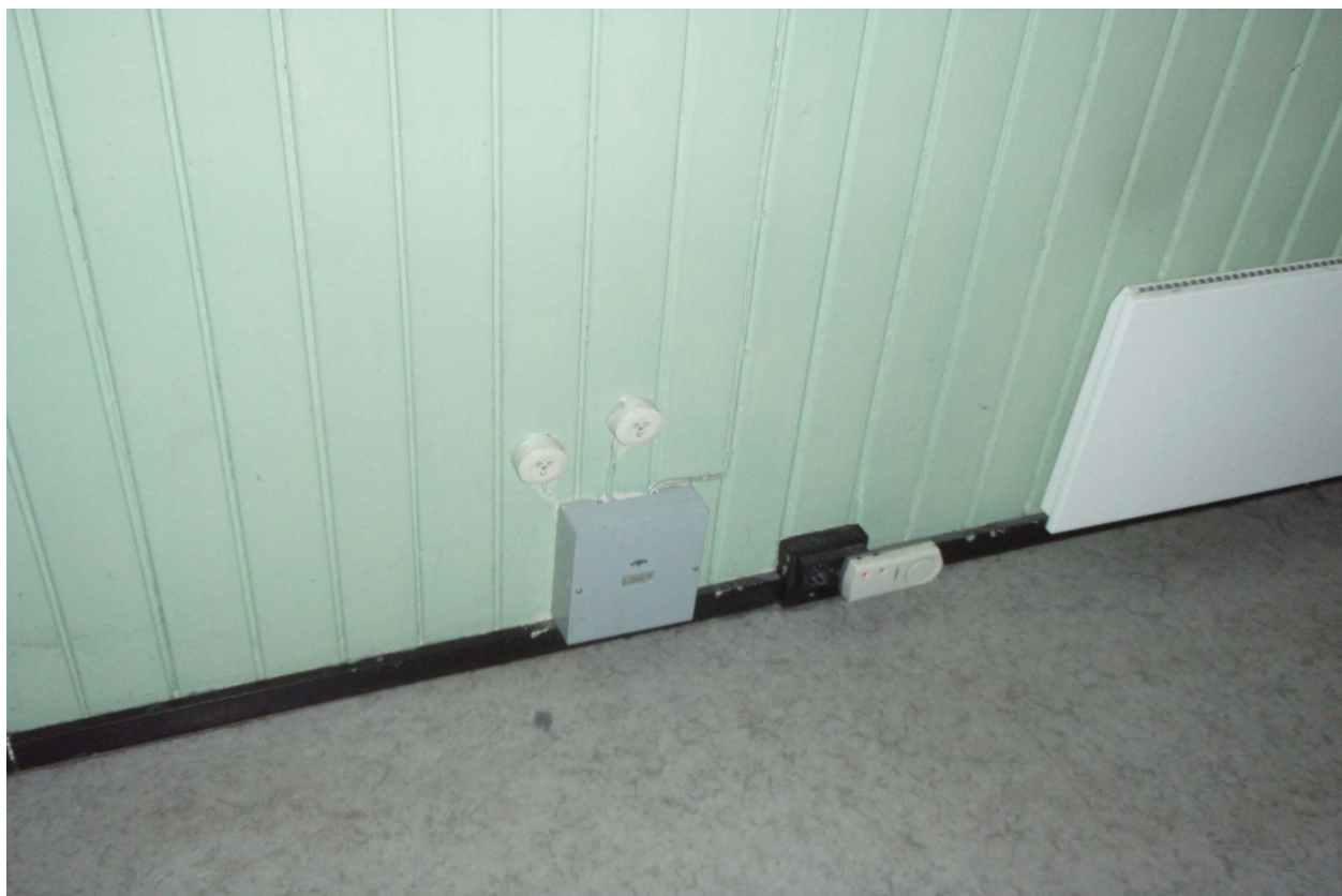
S-kuva 14. Puhelinristikytkentä.
