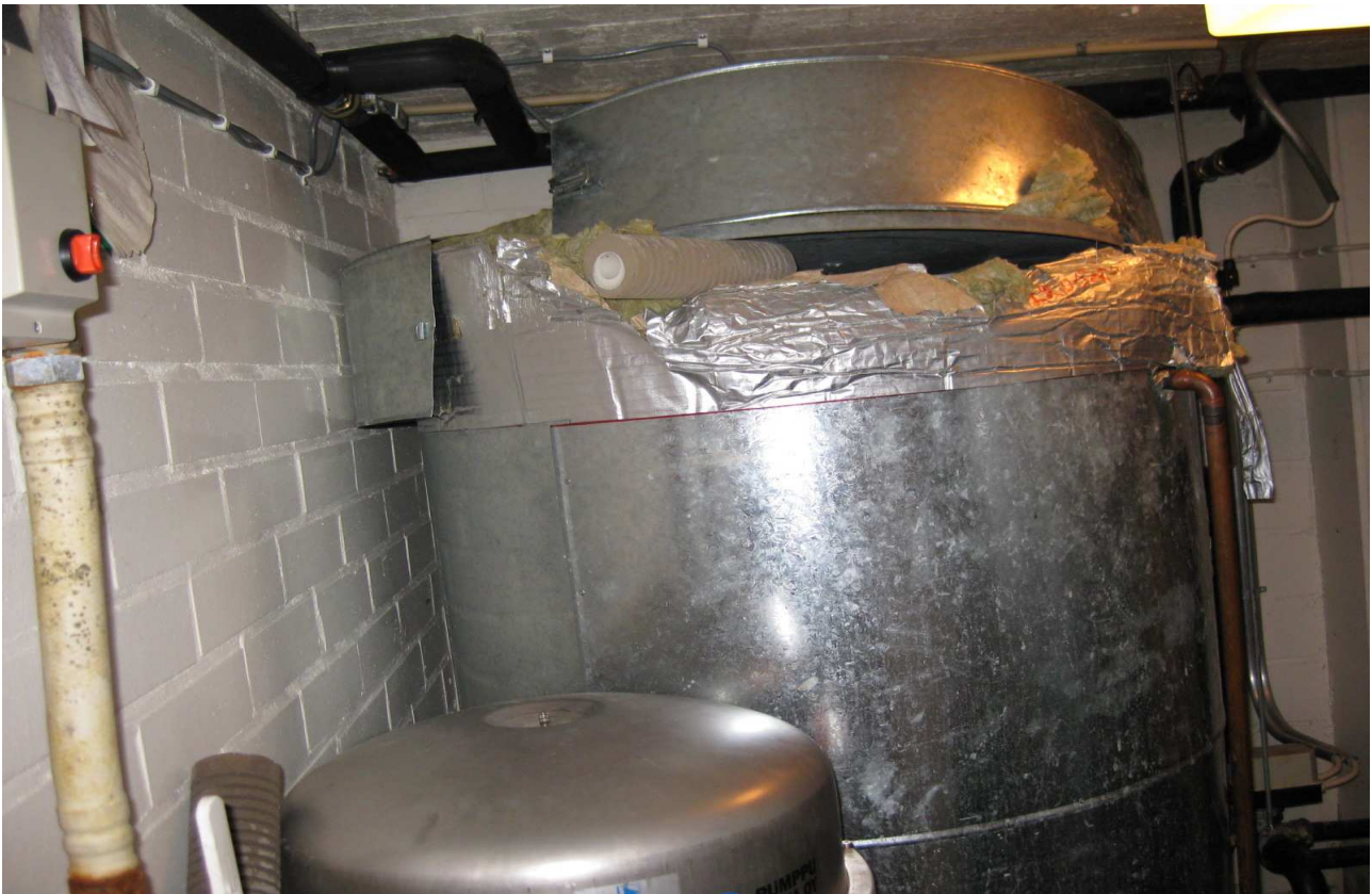
LVI-kuva 4. Yleiskuva käyttöveden varaajasäiliöistä.
