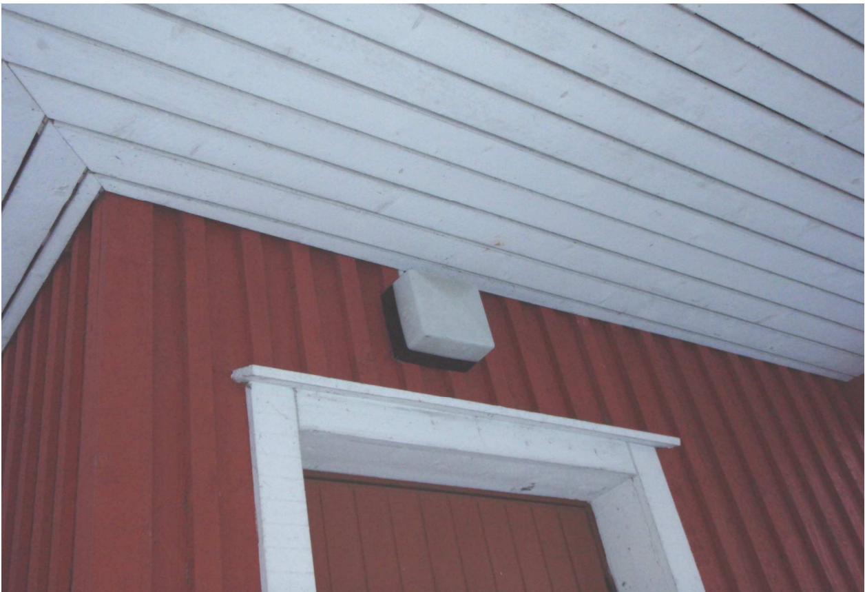
S-kuva 1. Sisäänkäynnin valaistus.
