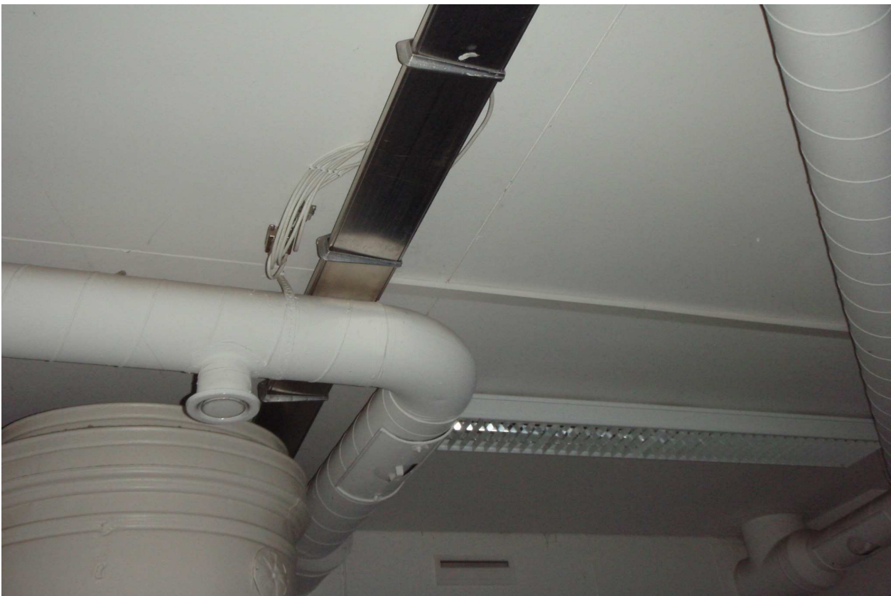
S-kuva 5. Kaapelihyllyasennus ja loistelamppuvalaisin.
