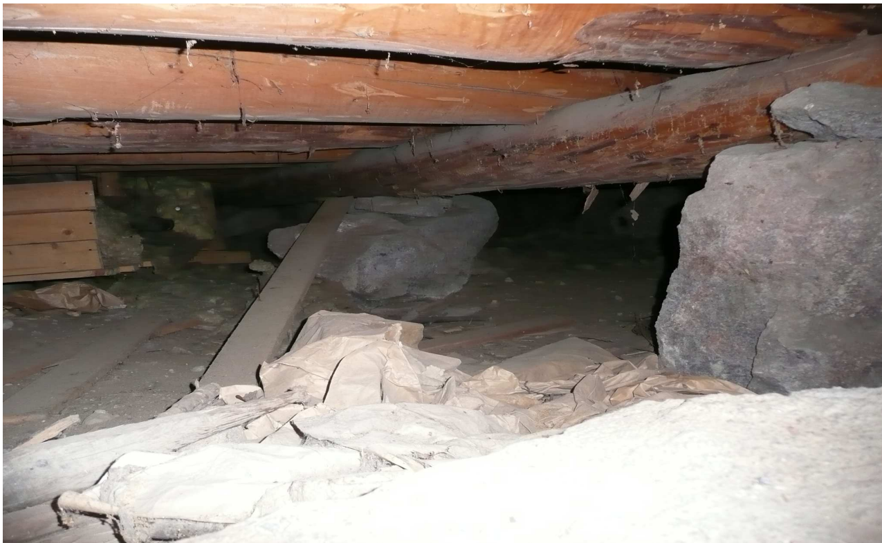
R-kuva 1. Rakennuksen alapohjatilaa.
