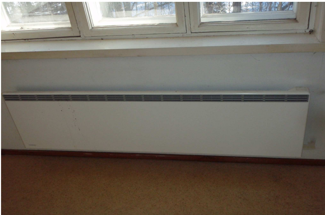
S-kuva 10. Virtauslämmitin.
