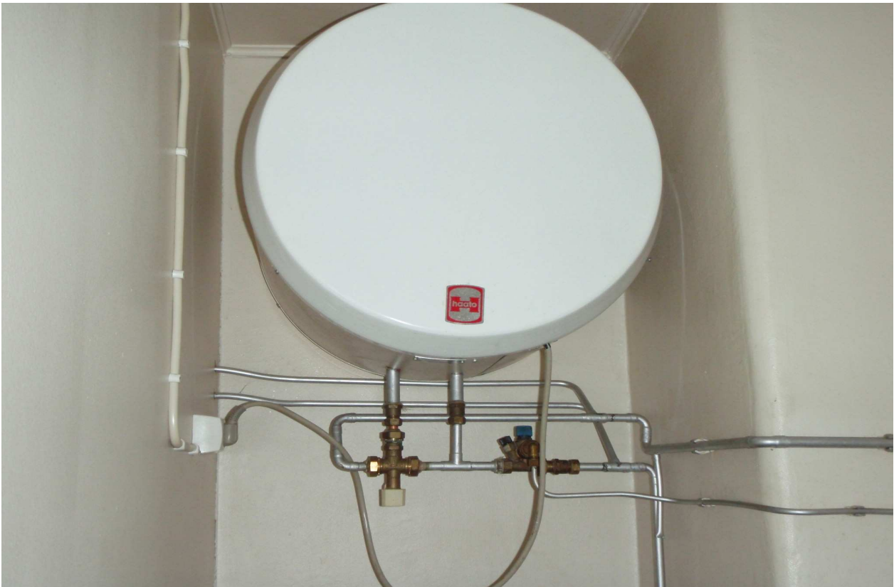
S-kuva 11. Lämminvesivaraaja.
