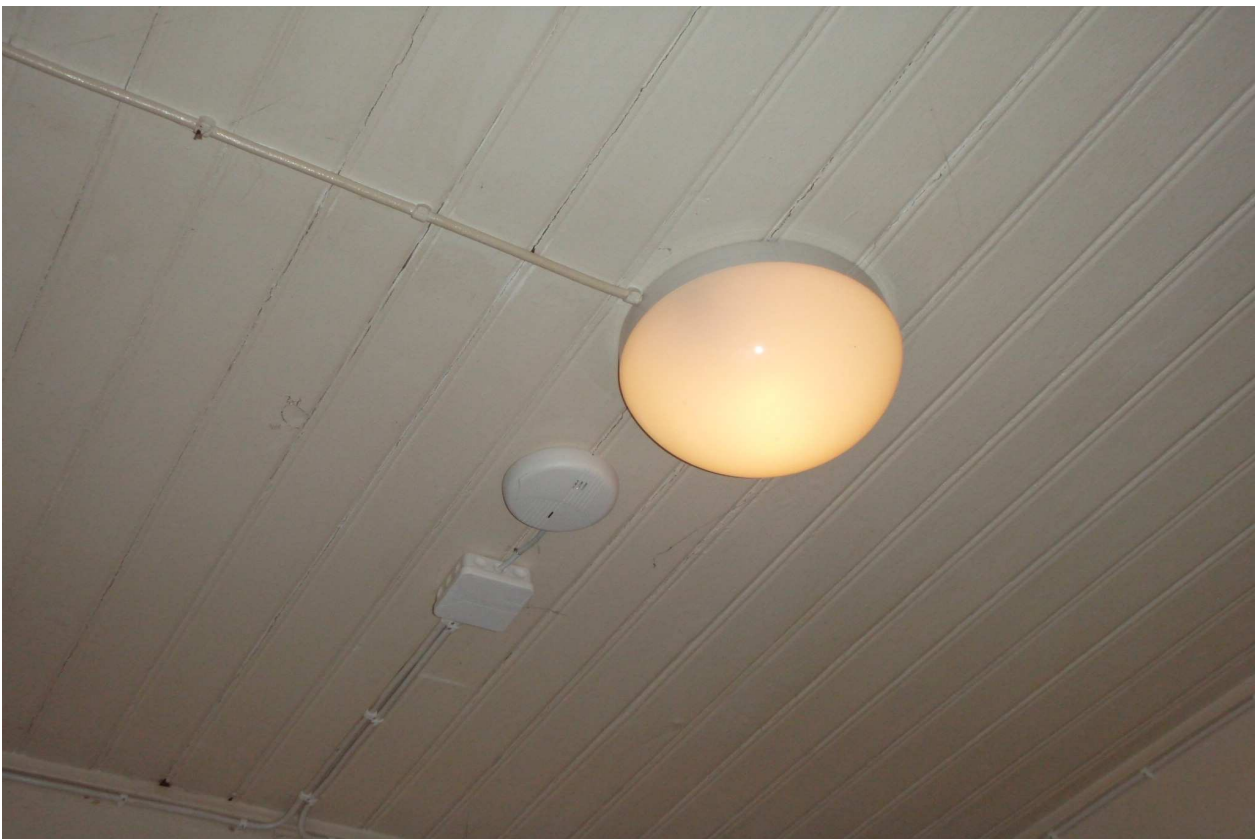
S-kuva 14. Palovaroitin.
