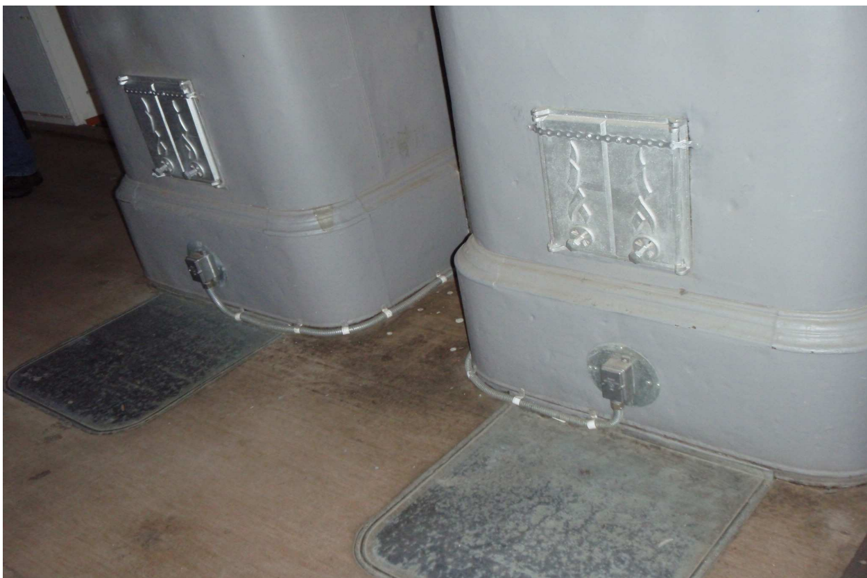
S-kuva 9. Uunin sähkövastuksen asennus.
