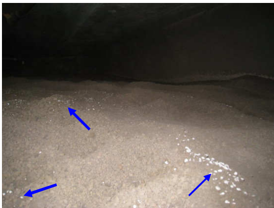
Kuva 3 Kevytsoran pinnalla valkoista kalkki- härmeen omaista nöyhtää.
