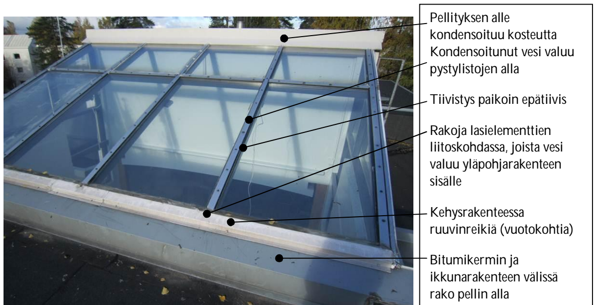
Kuva 2. Ruokopillin päiväkodin lasikatto 2. Molempien lasikattojen vuotokohdat ovat samat. Havaittuja veden vuotoreittejä on merkitty kuvaan.
