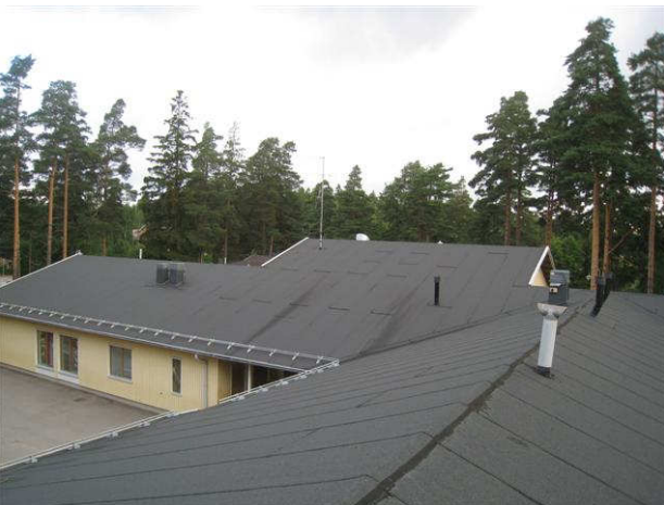
Kuva 63 Yleiskuva vesikatolta, jossa ei ole kulkusilloja huoltokohteille.
