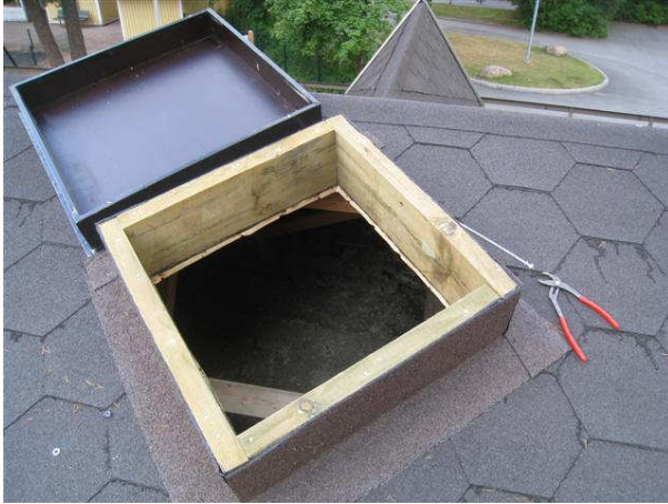
Kuva 25 Jälkikäteen tehty kattoluukku.
