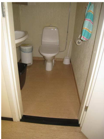
Kuva 41 Erillinen wc-tila, muovimattoa lattias- sa ja seinissä muovitapetti.
