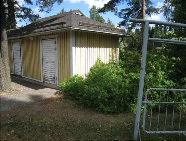
Kuva 7 Huonokuntoinen jätekatos- varastorakennus huoltopihalla.
