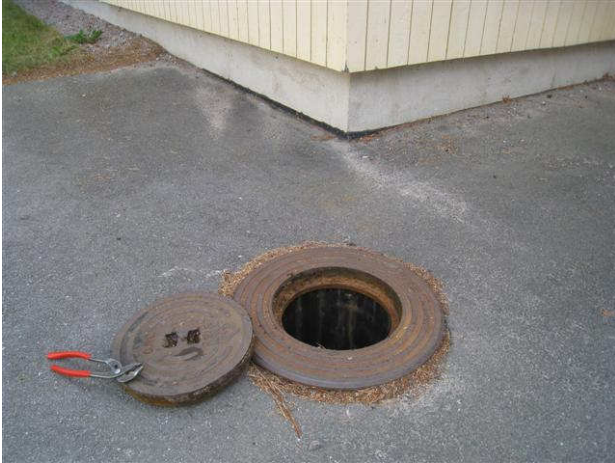
Kuva 55 Sokkelin rajalla on perusmuurilevy, tarkastettu salaojakaivo
