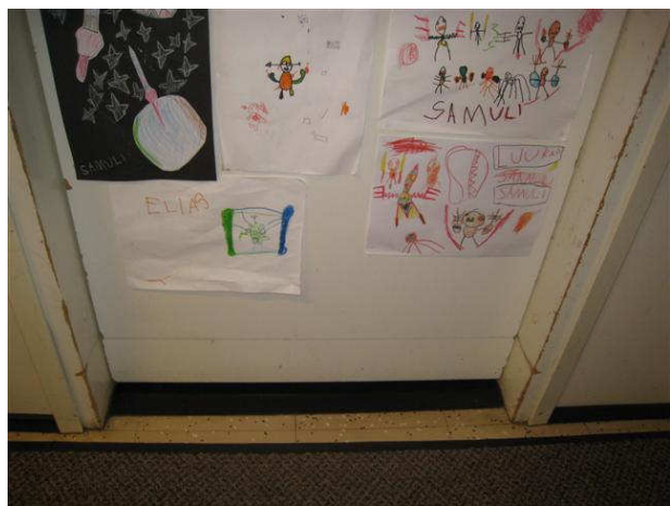
Kuva 46 Keittiökärryjen kuluttamat ovi pielet.
