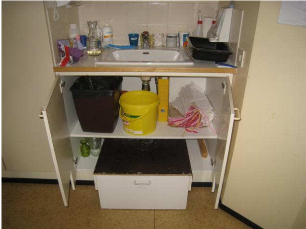
Kuva 48 Ryhmähuone 21 muokattu allaskaappi, johon on tehty vetolaatikko suojaksi.
