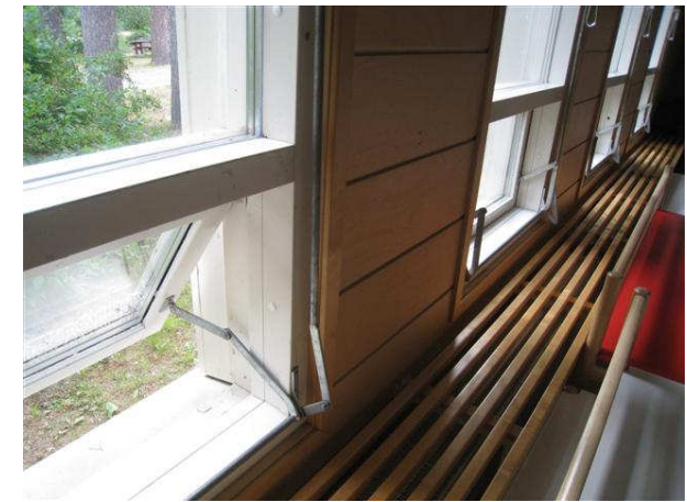
Kuva 16 Liikuntasalin umpiolasitettu tuuletusikkuna ja kiinteä yläosa.
