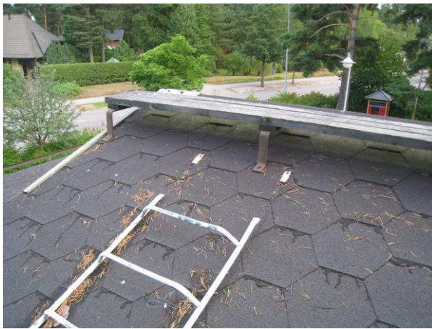
Kuva 21 Lapetikkaan yläpään kiinnitys on pettänyt, tikas nojaa lumiesteseeseen.
