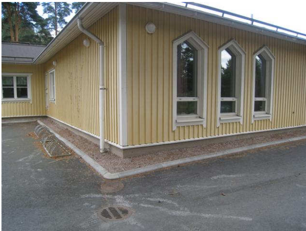
Kuva 9 Itäpihan kulmaus tilan 59 kohdalla, jossa sadevesikaivo ja salaojakaivo.
