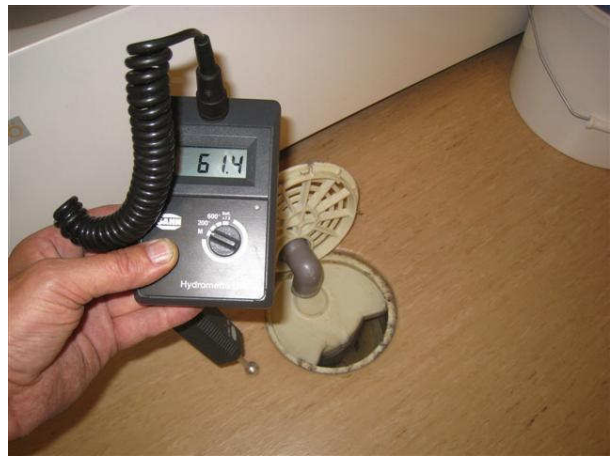
Kuva 38 Lattiakaivot ovat muovia, pintakosteudet olivat kuivaa rakennetta vastaavat.
