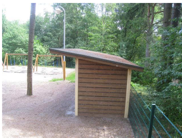
Kuva 52 Etelärajan varastovajan puuverhous viistää maata.
