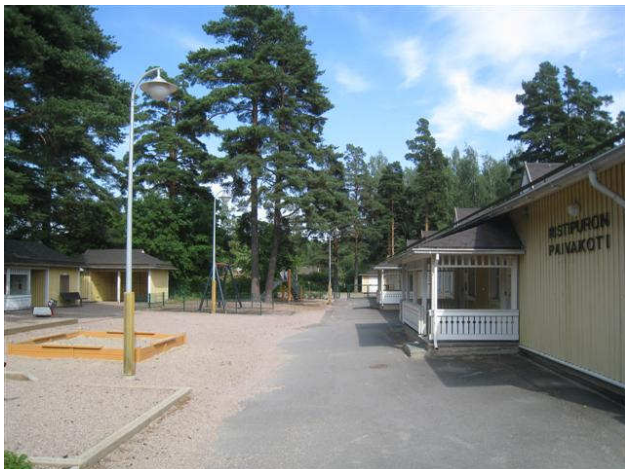
Kuva 1 Yleiskuva pohjoissivun pihalta, joka on uusittu hiljakkoin.
