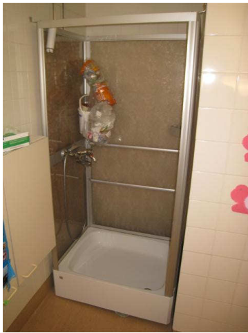
Kuva 39 Lasten suihkutilat ovat suihkukaapeissa.
