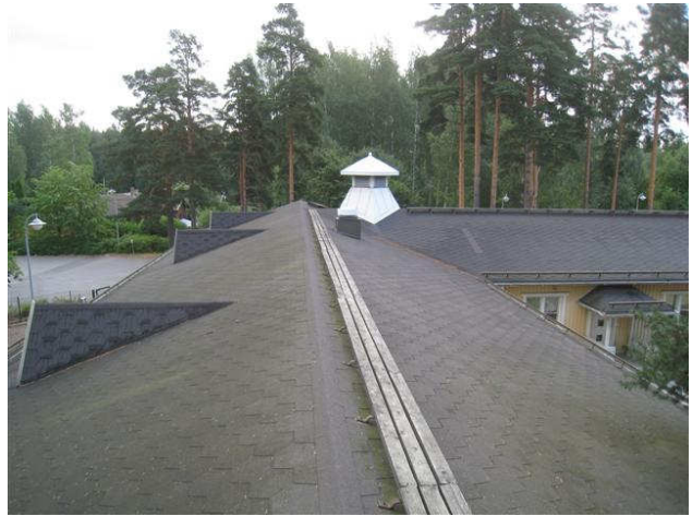
Kuva 20 Yleiskuva pohjoisosan vesikatolta.
