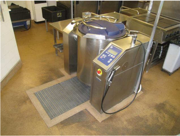
Kuva 31 Keittiöpadan ympäristän pinnoite on uusittu, vanha pinta on kulunut.
