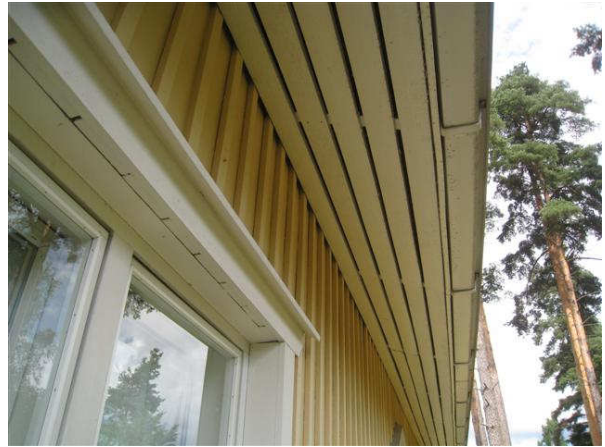
Kuva 14 Ikkunoiden yläosat ja räystäät ovat vielä kunnossa.
